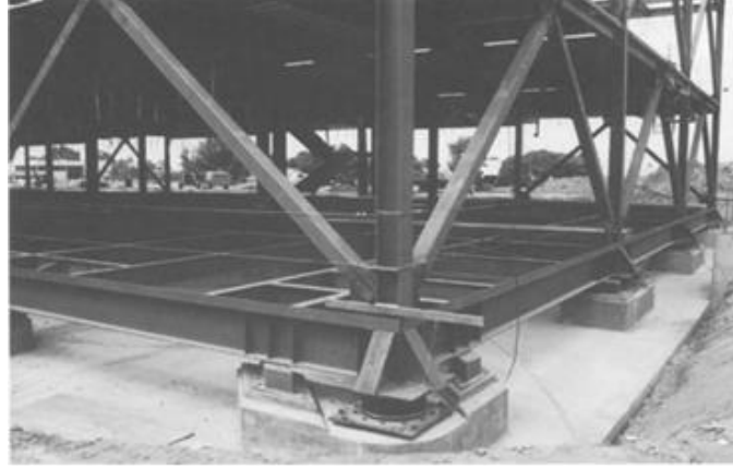
Şekil 1.26 : Trafik yönetim merkezinde kullanılan yüksek sönümlü kauçuk izolatör.
