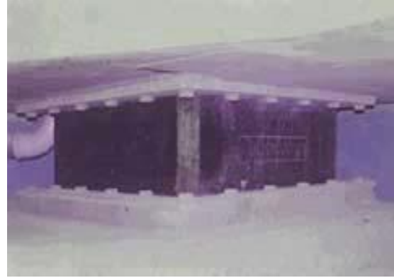
Şekil 1.22 : William Clayton bina görünümü b. Kullanılan kurşun çekirdekli yalıtım birimi (Naeim & Kelly, 1999, s.15) .
