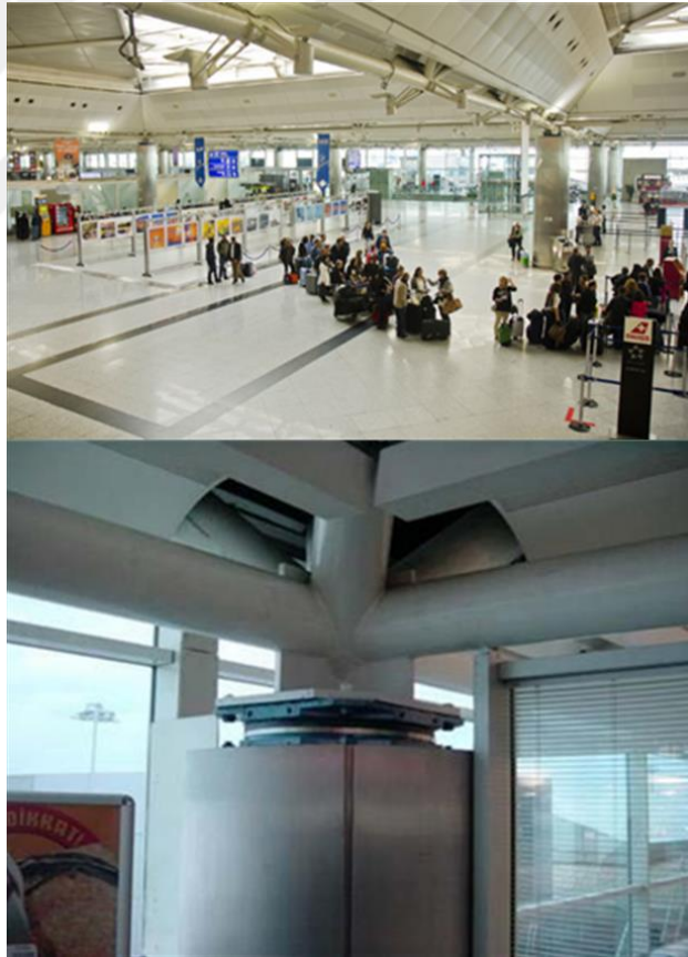
Şekil 1.37 : Atatrk Havalimanında deprem yalıtım uygulaması.
