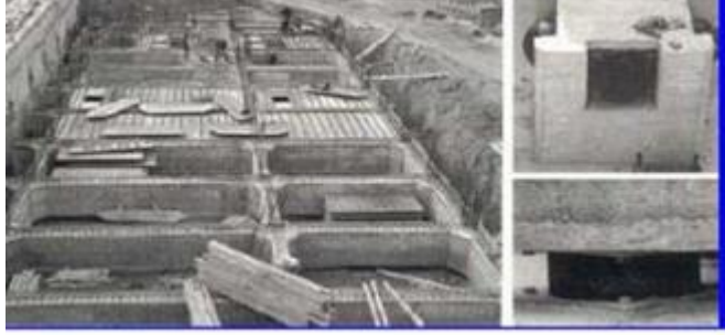
Şekil 1.35 : 297 yüksek sönümleyici kauçuk mesnet, inşaat başlangıcı (Martelli & Forni, 1998).
