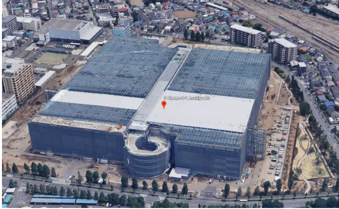
Şekil 1.32 : Park Hino lojistik binası, Japonya (Enr, Engineering News-Record).
