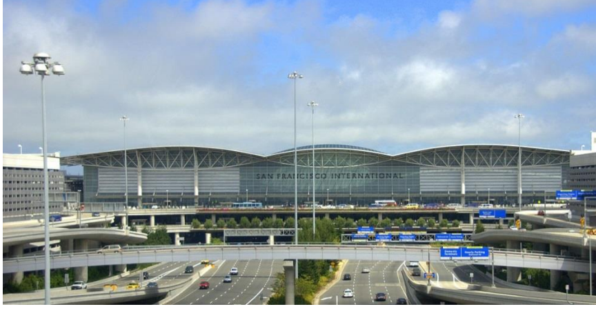
Şekil 1.28 : San Fransisko uluslararası havaalanı terminali (Kravchuk ve diğ.,2008).
