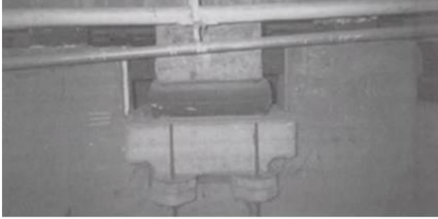
Şekil 1.21: Pestalozzi okulunda kullanılan izolatör (Robinson, 2000 , s.329).
