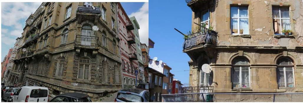
Şekil 7.2 : Valpreda Apartmanı'na ait fotoğraflar.
