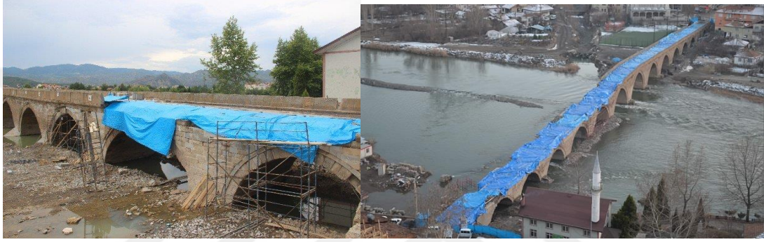
Şekil 6.5 : Koyunbaba Köprüsü'nde yapılan restorasyon çalışmaları.
