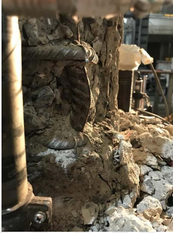
Şekil 4.46 : GDA-60M numunesi %6 öteleleme oranı çekme kuzey-doğu (N-E) köşelerindeki donatı burkulması.
