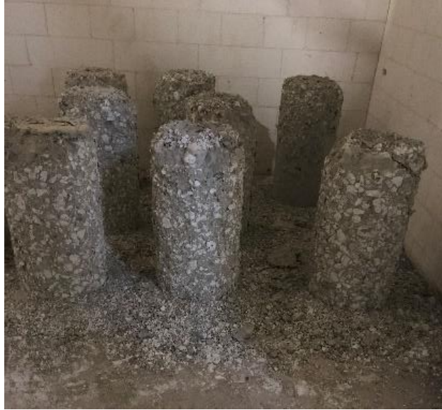
Şekil 3.12 : 90 dakikalık yangın senaryosu deneyi sonrası silindir numunelerin görünümüleri.
