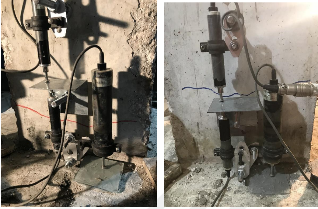
Şekil 4.37 : GDA-60M Numunesi %0.5 öteleme oranı kuzey (N) ve güney (S) yüzlerinin hasar görünümü.
