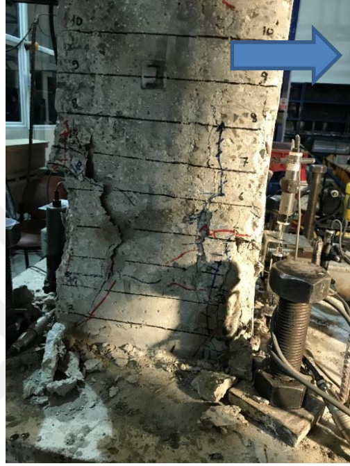
Şekil 4.64 : GDA-90M numunesi %4 öteleme oranı itme kuzey-batı (N-W) köşesindeki hasar görünümü.
