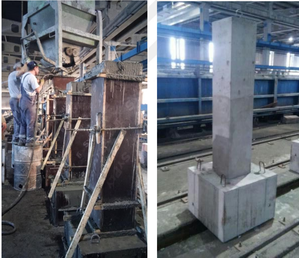
Şekil 2.10 : a) Beton dökümü ve b) üretim sonrası görünüş.
