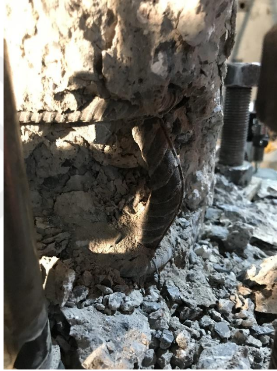
Şekil 4.48 : GDA-60M numunesi %7 öteleme oranı itme kuzey-doğu (N-E) köşelerindeki donatı burkulması.
