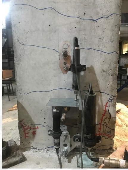
Şekil 4.5 : GDA-REF %2 öteleme oranı çekme sonrası kuzey(N) yüzünde oluşan ezilme hasarı.
