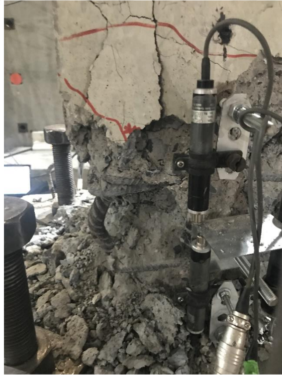
Şekil 4.28 : GDA-30M %6 öteleme oranı çekme sonrası güney (N) ve batı (W) birleşimindeki donatı burkulması.
