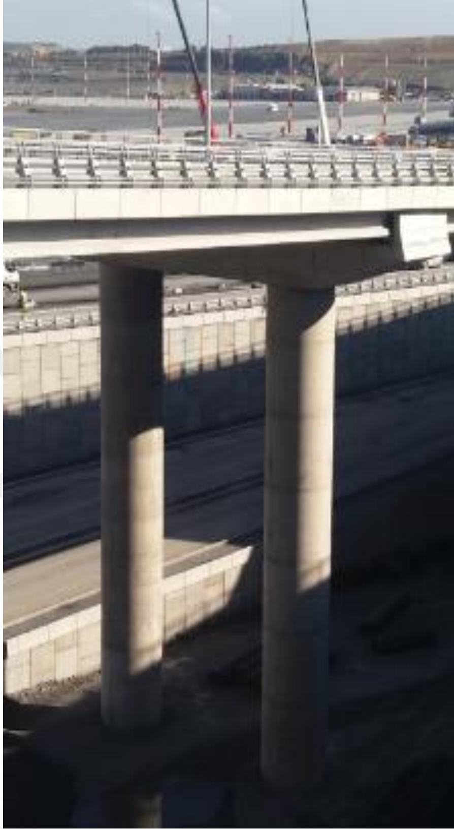
Şekil 2.6 : P6 eksenindeki orta ayakların inşası sırasında çekilen bir görünüm
