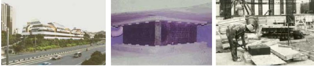
Şekil 1.10: a. William Clayton binası, b. Kullanılan bir kauçuk yalıtım birimi ve c. Montajı (Naeim & Kelly, 1999, s.15).
