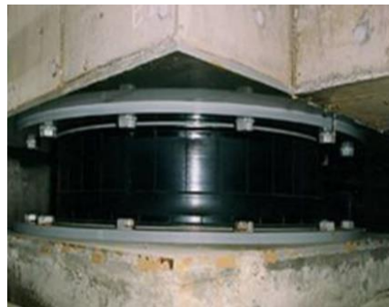
Şekil 1.28: Yüksek sönümlü kauçuk deprem yalıtım birimi (HDRB) (Mageba, İsviçre).
