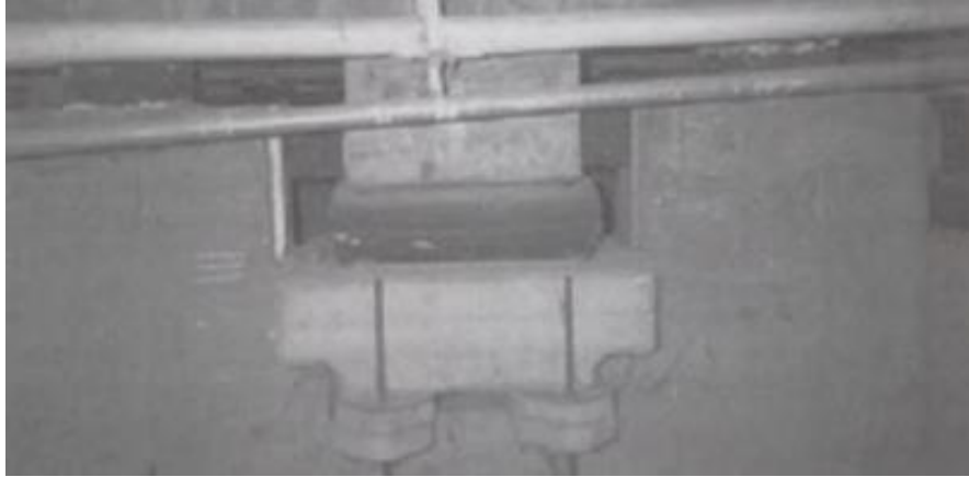
Şekil 1.9: Pestalozzi İlkokulu'nda kullanılmış olan kauçuk yalıtım birimi (Robinson, 2000, s.329).
