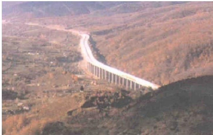
Şekil 1.18: Bolu Viyadükleri genel görünüşü (Yılmaz ve Türer, 2002).
