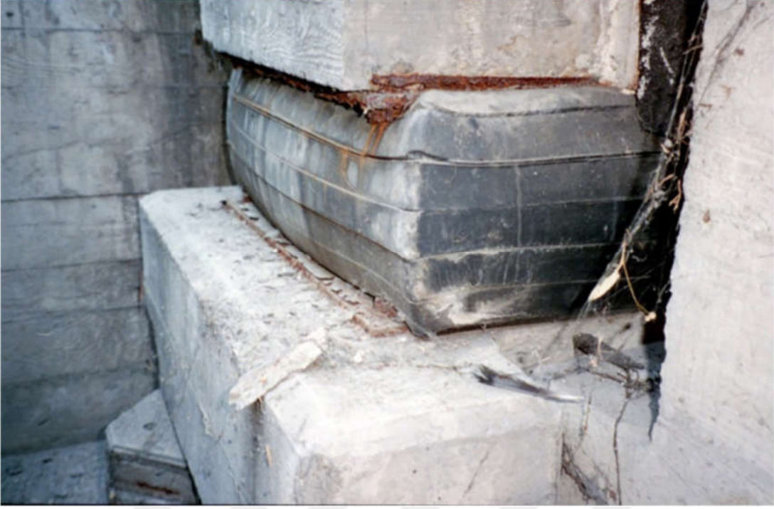
Şekil 3.1: Pestalozzi Okulu'nda kullanılan donatısız kauçuk mesnet (Kelly ve Lee, 2018).
