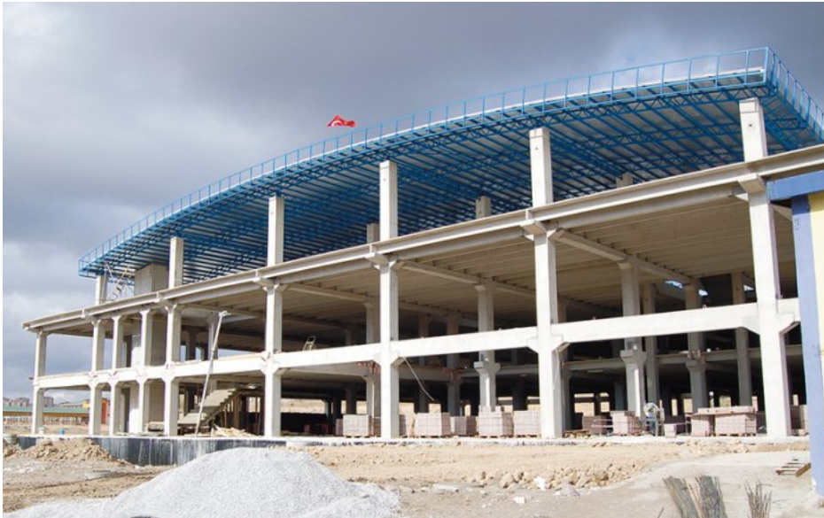
Şekil 2.2 : Kolonları üstten mafsallı bina örneği.
