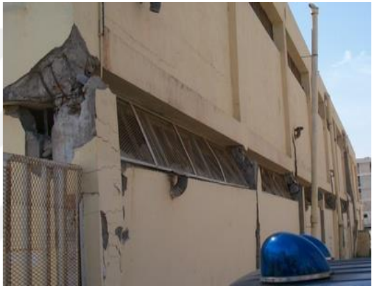
Şekil 10.8 : (a) 2010 Haiti Depremi kısa kolon hasarı (Paultre ve diğ., 2010).
