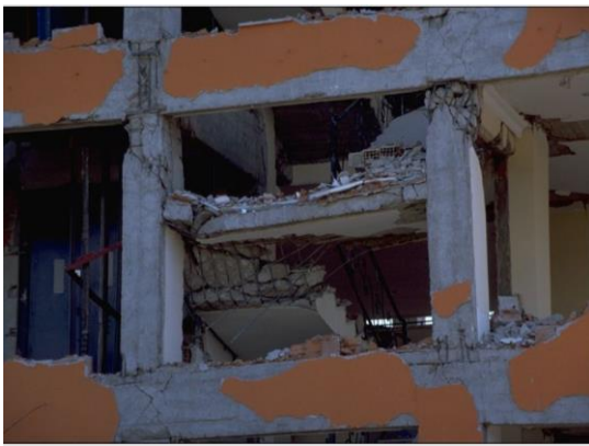
Şekil 10.9 : (a) 2010 Haiti Depremi'nde kolona mesnetlenen merdiven sahanlığı nedeni ile oluşan kısa kolon hasarı (Paultre ve diğ. 2010).
