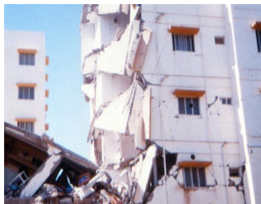
Şekil 4.3 :Köşe kolon göçmesi sonrasında hasar alan binalar (Kaplan ve diğ, 2015).
