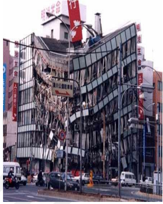
Şekil 2.11 : (a) 2006 Tayvan Tainan Depremi sonrasında gözlemlenen burulma hasarı (Chung, 2016). (b) 1995 Kobe Depremi'nde meydana gelen burulma hasarı (Meguro ve Elkholy, 2004).
