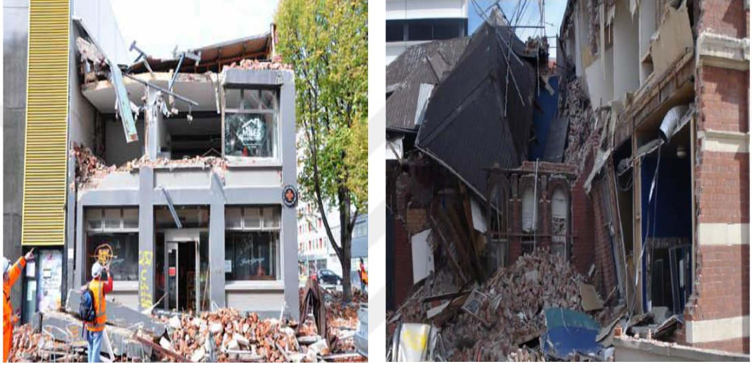
Şekil 9.4 : Farklı kütleli çekiçleme etkiyle ciddi hasar almış bir işyeri ve konut ( Cole ve diğ., 2012).
