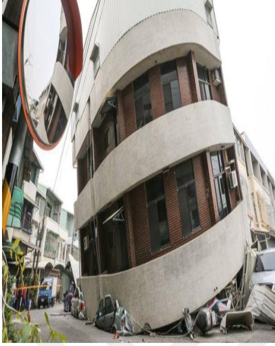
Şekil 2.11 : (a) 2006 Tayvan Tainan Depremi sonrasında gözlemlenen burulma hasarı (Chung, 2016). (b) 1995 Kobe Depremi'nde meydana gelen burulma hasarı (Meguro ve Elkholy, 2004).
