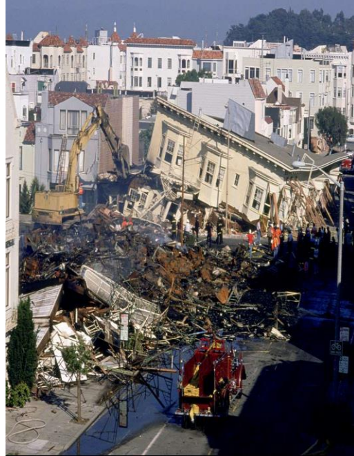
Şekil 6.3 : 1989 Loma Prieta Depremi’nde meydana gelen yumuşak kat hasarı nedeniyle kısmen göçen binalar (Shapiro ve Hirsch, 1989).
