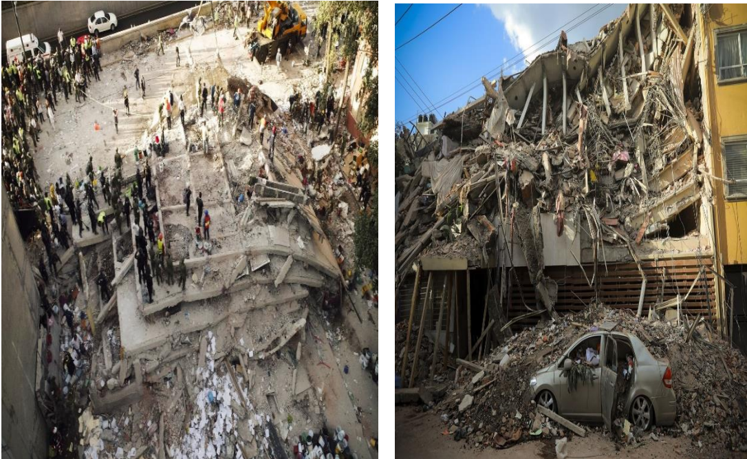
Şekil 8.6 : 2017 Meksika Depremi'nde kuvvetli kolon – zayıf kiriş prensibine uyulmadan inşa edilen binalarda görülen toptan göçmeler (Jeffery, 2017).
