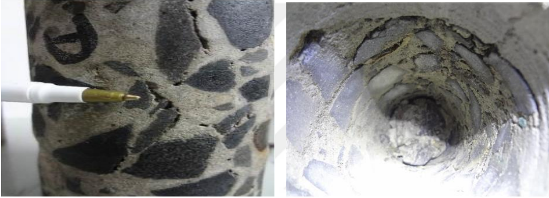
Şekil 11.18 : Yeterince sıkıştırılmadan dökülen beton numunesi (Yepez, 2017).
