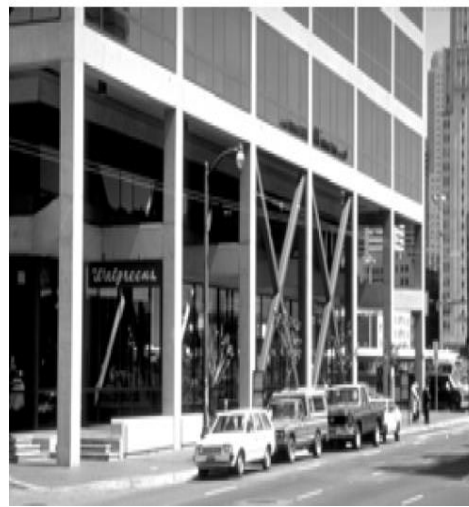
Şekil 6.6 : San Fransisco'da oluşabilecek muhtemel yumuşak kat hasarına karşı önlem alınmış binalar (FEMA454, 2006).
