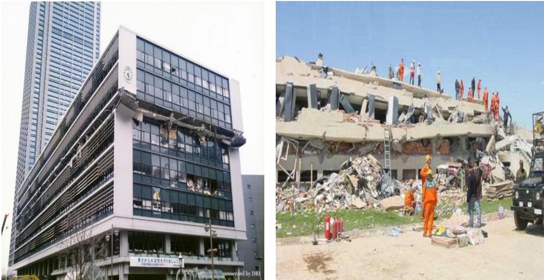
Şekil 8.8 : (a) 1995 Kobe Depremi'nde orta katı göçen iş merkezi (Ghosh, 1995). (b) 2003 Bingöl Depremi'nde tamamen yıkılan bina (Kalafat ve Ölmez, 2003).
