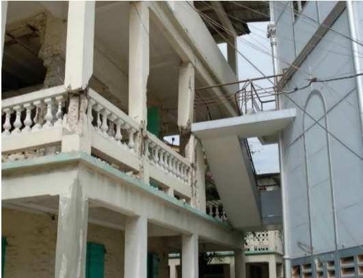
Şekil 10.9 : (a) 2010 Haiti Depremi'nde kolona mesnetlenen merdiven sahanlığı nedeni ile oluşan kısa kolon hasarı (Paultre ve diğ. 2010).
