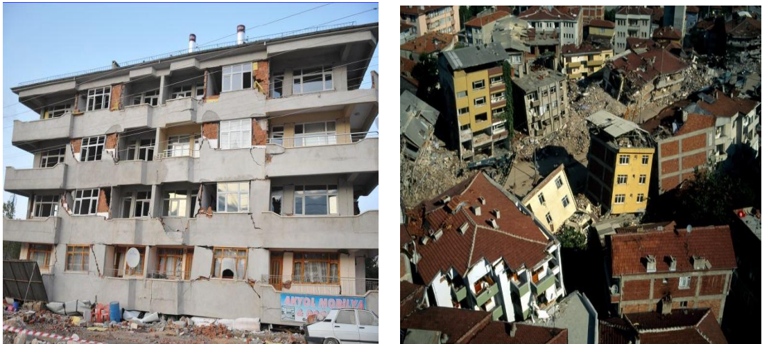
Şekil 6.5 : (a) 2011 Van Depremi yumuşak kat hasarı (Gürer, 2012).
