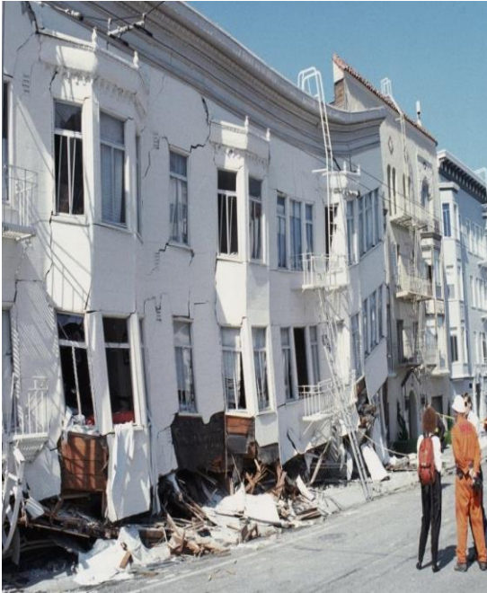
Şekil 6.3 : 1989 Loma Prieta Depremi’nde meydana gelen yumuşak kat hasarı nedeniyle kısmen göçen binalar (Shapiro ve Hirsch, 1989).
