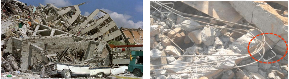
Şekil 11.21: 1985 Meksika Depremi yapı malzemesi kaynaklı meydana gelen hasarlar (Adler, 2015).
