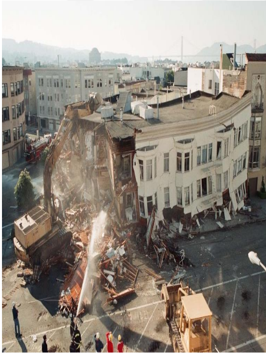
Şekil 2.12 : (a) 1989 Loma Prieta Depremi'nde meydana gelen burulma hasarı (Wilkey, 2011). (b) 1994 Northridge Depremi'nde meydana gelen burulma hasarı (FEMA 454, 2006).
