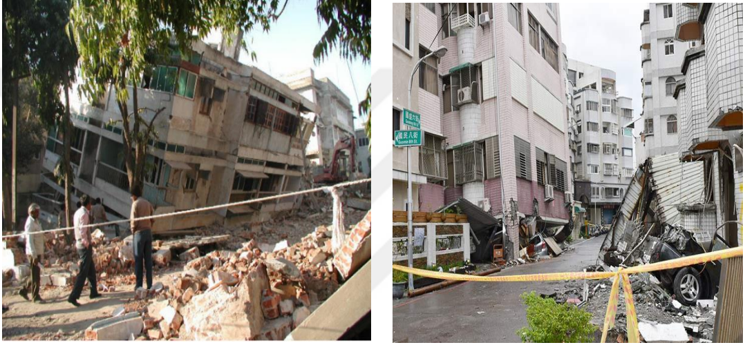
Şekil 6.4 : (a) 2010 Haiti Depremi yumuşak kat hasarı (Özmen ve diğ., 2007).
