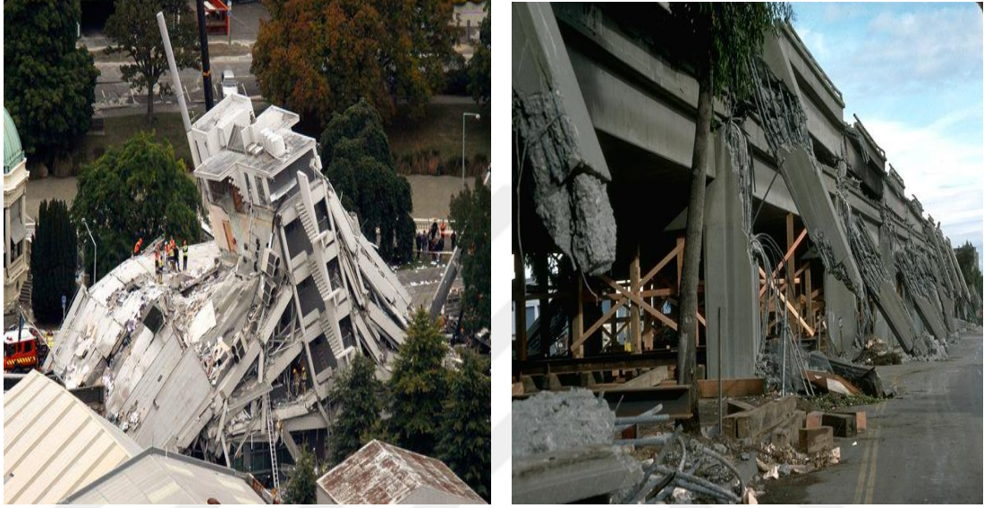
Şekil 8.7 : 2011 Christchurch Depremi'nde kuvvetli kolon zayıf kiriş prensibine uyulmaması nedeniyle göçen binalar ( Alim, 2014).
