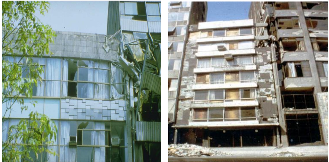
Şekil 9.5 : 1985 yılında Meksika Depremi’nde birbirinden farklı yükseklikte çekiçleme etkisi nedeniyle hasar görmüş binalar (Öztürk ve diğ., 2013).
