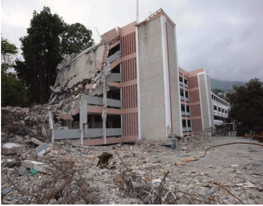
Şekil 10.8 : (a) 2010 Haiti Depremi kısa kolon hasarı (Paultre ve diğ., 2010).
