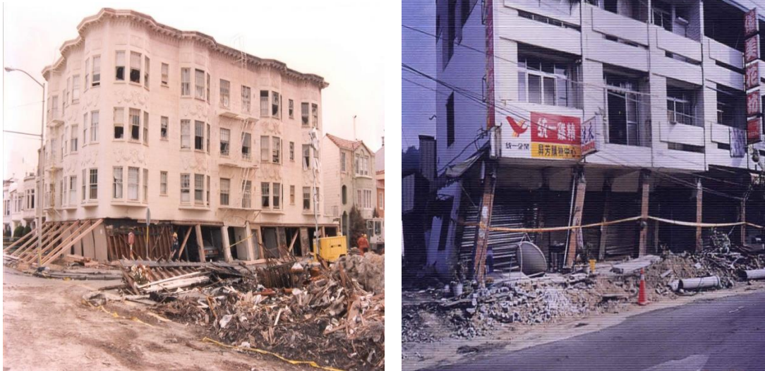
Şekil 5.3 : (a) 1989 Loma Prieta Depremi zayıf kat hasarı (Yao ve Sheu, 2001). (b) 1999 Chi Chi Depremi zayıf kat hasarı (Yao ve Sheu, 2001).
