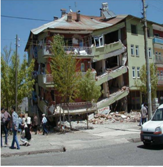
Şekil 5.4 : (a) 2003 Bingöl Depremi zayıf kat hasarı (Temur, 2005).
