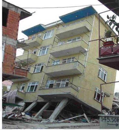
Şekil 5.4 : (a) 2003 Bingöl Depremi zayıf kat hasarı (Temur, 2005).
