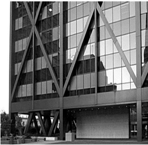
Şekil 6.6 : San Fransisco'da oluşabilecek muhtemel yumuşak kat hasarına karşı önlem alınmış binalar (FEMA454, 2006).
