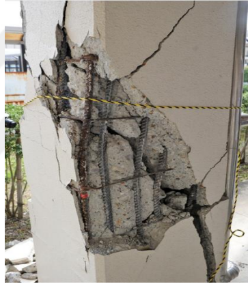
Şekil 11.8 : 2011 Tohoku Depremi’nde Tohoku Üniversitesi Kimya Fakültesi’nde meydana gelen kolon kesme hasarı (Swanson, 2011).
