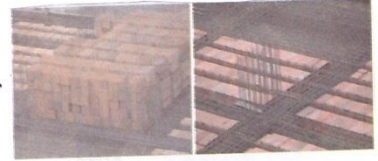
Katlar arasında delikli tuğla uygulaması
