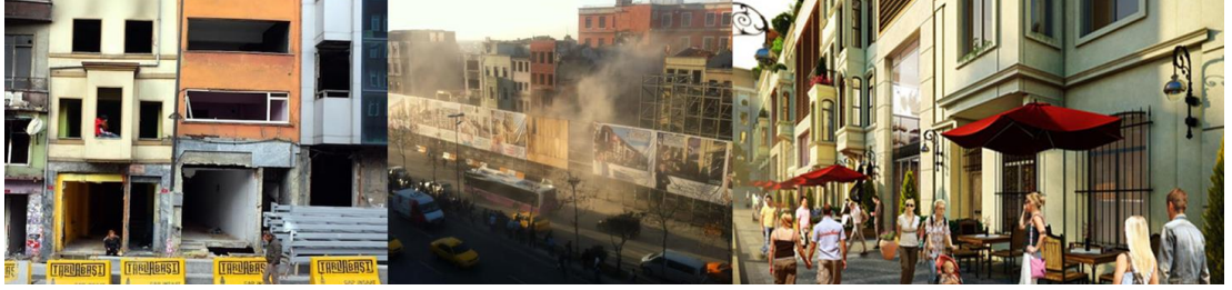
Şekil 4.2. Tarlabası Kentsel Dönüşüm Projesi (Kaynak: İstanbul SMD, www.ismd.org.tr , megaprojeleristanbul.com )
