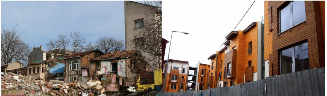
Şekil 4.3. Sulukule Kentsel Dönüşüm Projesi (Kaynak: İstanbul SMD, www.ismd.org.tr , megaprojeleristanbul.com )
