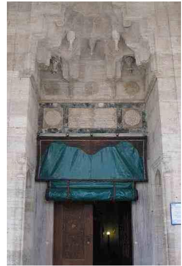
Hadım İbrahim Paşa Câmii cümle kapısı
