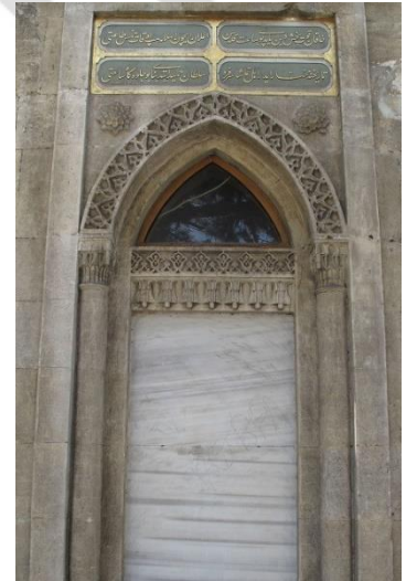
Yıldız Saat Kulesi kuzey cephesi
