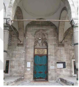
Dâvud Paşa Câmii cümle kapısı
