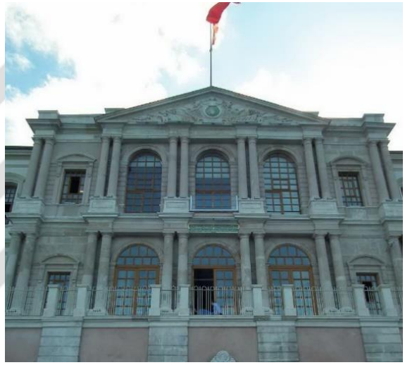
Kuleli Kışlası Şeref Kapısı
