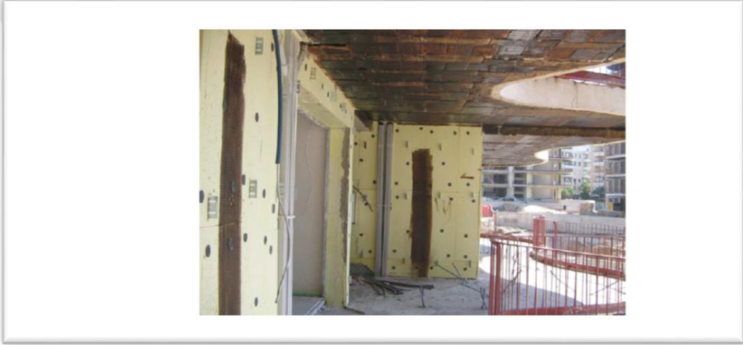
Şekil 11.3.1. Hava kaçaklarının olduđu bölgelerin uygun malzemelerle kapatılması
