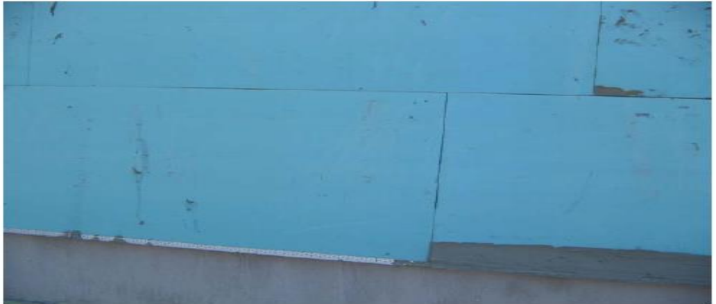
Şekil 11.5.1. Doğrudan duvara monte edilmiş ısı yalıtım uygulaması
