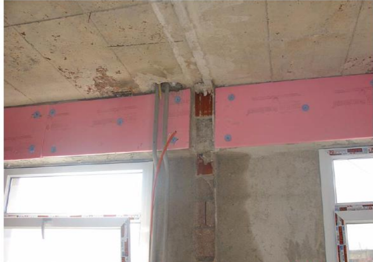
Şekil 11.1.18. İçten ısı yalıtım uygulaması
