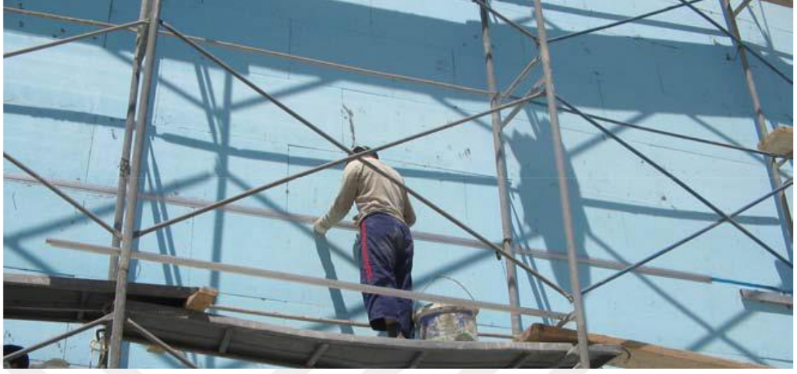
Şekil 11.1.13. Yalıtımın doğrudan duvara uygulanması
