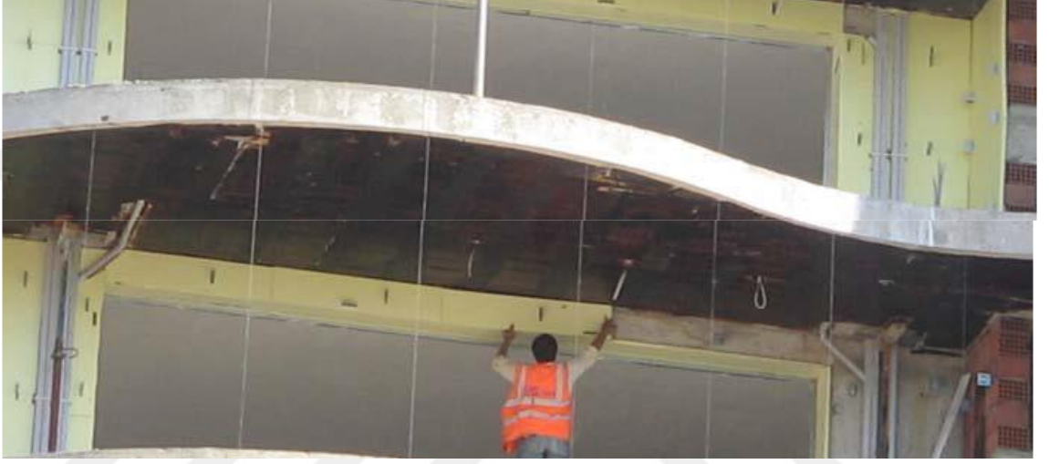
Şekil 11.1.11. Dışarıdan(mantolama )ısı yalıtım uygulaması
