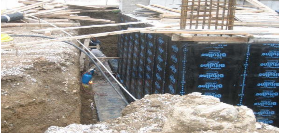
Şekil 11.4. Temel duvarların yalıtılması
