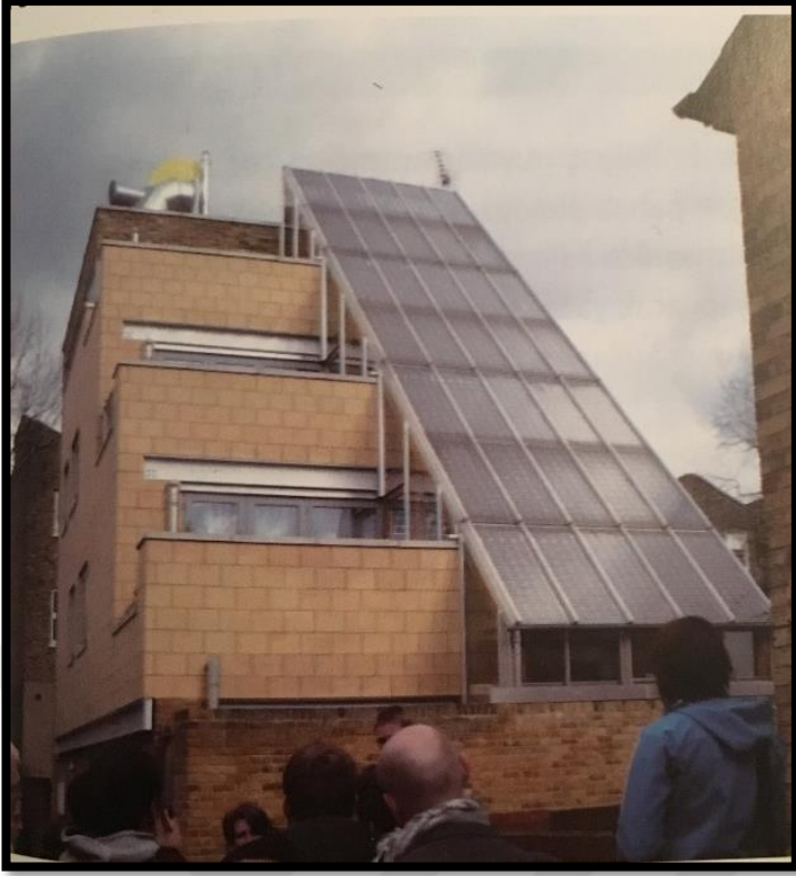
Şekil 82: Fotovoltaik Piller Mimarinin Parçası Olarak Uygulanmıştır. Londra – İngiltere Kaynak: Mete Sezer Fotoğraf Arşivi
