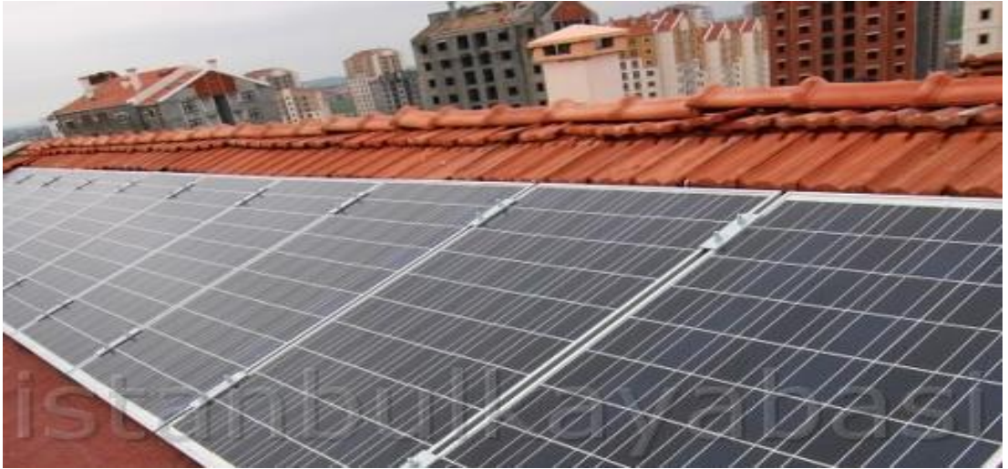
Şekil 83: Kayaşehir fotovoltaik pil uygulaması ( çevre aydınlatması, hidroforlar ve ortak elektrik tüketimine ait giderleri karşılamaktadır.)
