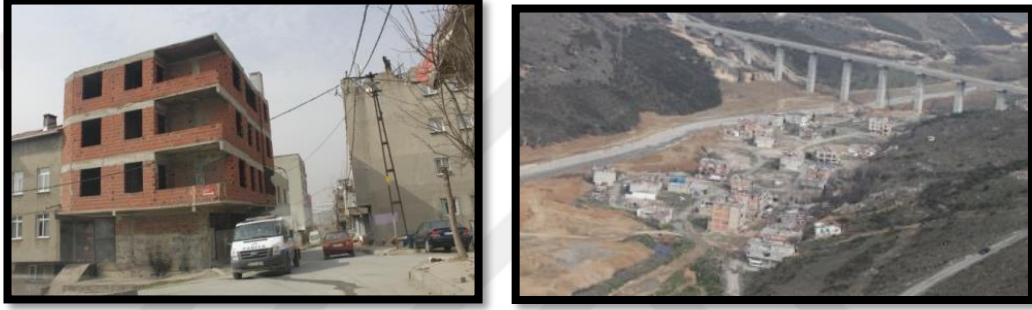
Şekil 58: Kentsel Dönüşüm Öncesi Durum
