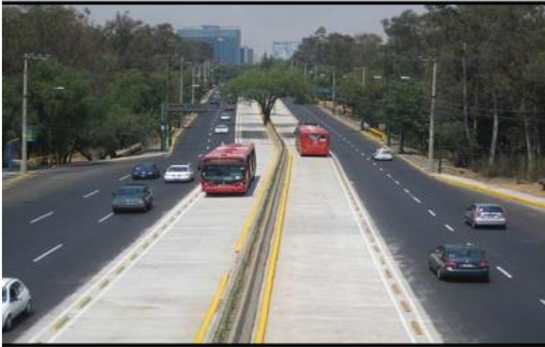
Şekil 2: Quito Ecovia (Ekvator) Fiziksel Engellerle Ayrılmış Metrobüs Yolu 38
