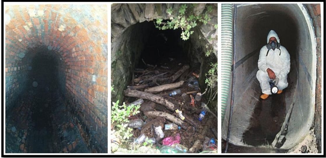
Şekil 11 Eski İçmesuyu Galerisi (solda), Rumeli Hisarı Altından Geçen Eski Yağmursuyu Tüneli (ortada), Kaplama Yapılmış Tuğla Tünel (sağda)
