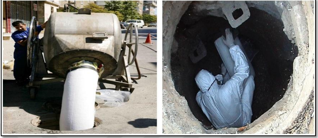
Şekil 28 CIPP Yöntemi ile Uygulama Resimleri Kaynak: (İski, Fotoğraf Albümü,)
