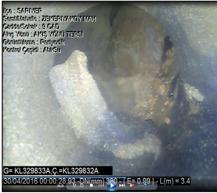
Şekil 4 Çalışma sırasında kanalda kalan künk parçası
