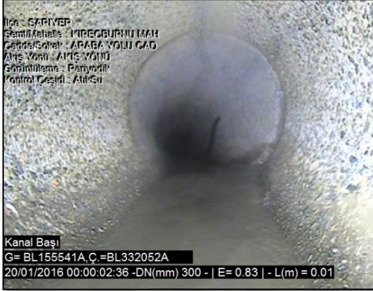
Şekil 10 İmalat Sonrası Yeni Kanal Görüntüsü
