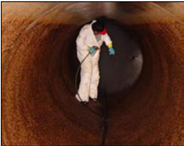
Şekil 21 İsale Hattında Reçine Kaplama Çalışması Kaynak: (Nastt, 2013)
