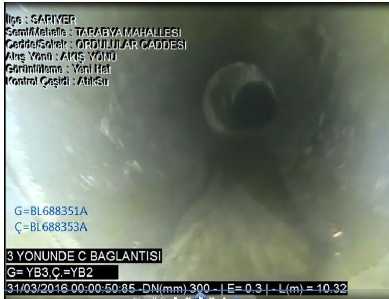
Şekil 6 Eğimi Fazla olan Kanal Görüntüsü
