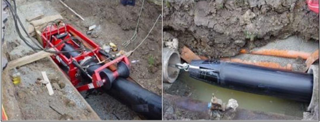
Şekil 15 Boru Patlatma Çalışması Giriş ve Çıkış Çukuru Kaynak: (Nastt, 2013)
