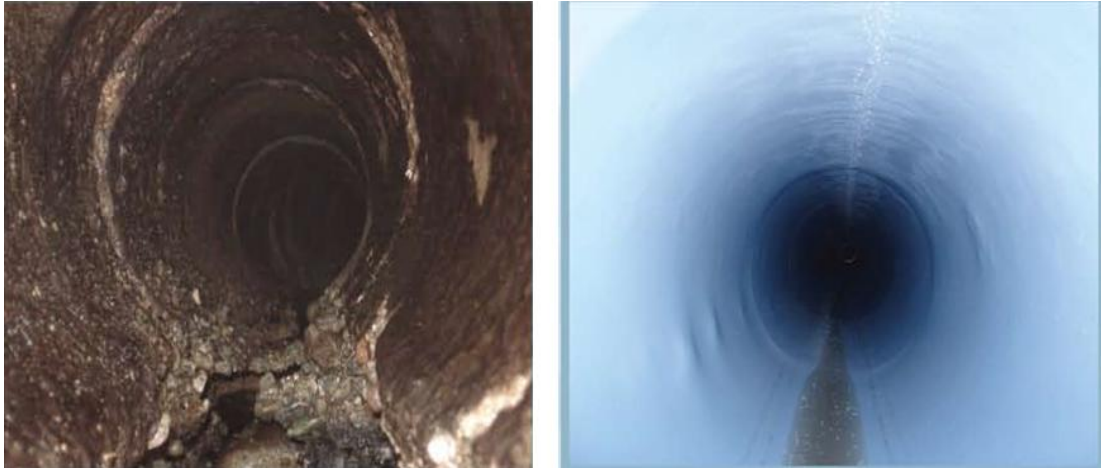
Şekil 23 CIPP Yöntemi ile Yenilenen Kanılın Öncesi (solda) ve Sonrası (sağda) Kaynak: (İski, Tem.Gör.Raporları, 2015)
