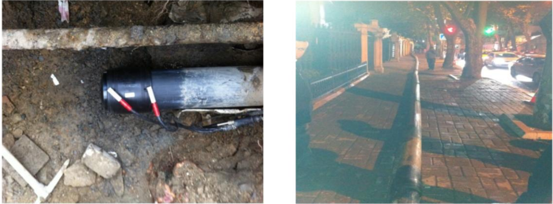
Şekil 25 Çalışma Resimleri [HDPE Boru ve Fizyon Kaynağı (solda), HDPE Borunun Dışarıdaki Görünümü (sağda)] Kaynak: (İski, Fotoğraf Albümü,)
