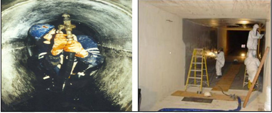
Şekil 20 Atıksu Hattının Kaplanması(solda), Yağmursuyu Kapalı Galerisinin Çimento İle Kaplanması (sağda) Kaynak: (Japonya Eğitim Notları, 2009)
