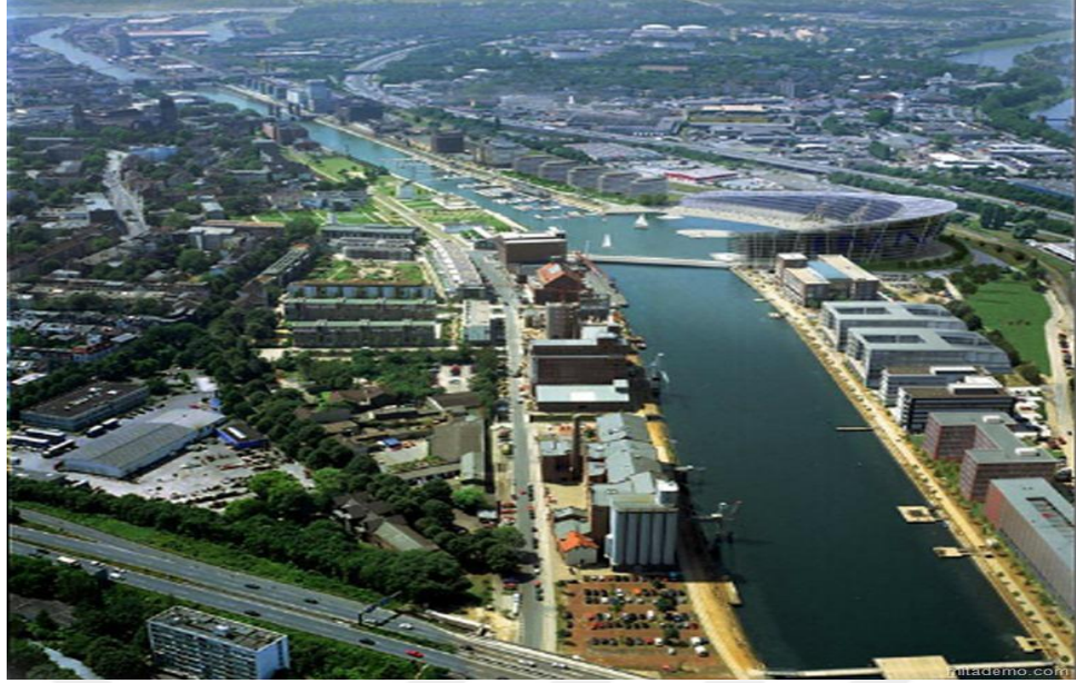
Şekil 3.6 Duisburg Şehrinin Kentsel Dönüşüm Sonrası Fotoğrafı (A.Şatıroğlu, 2011)
