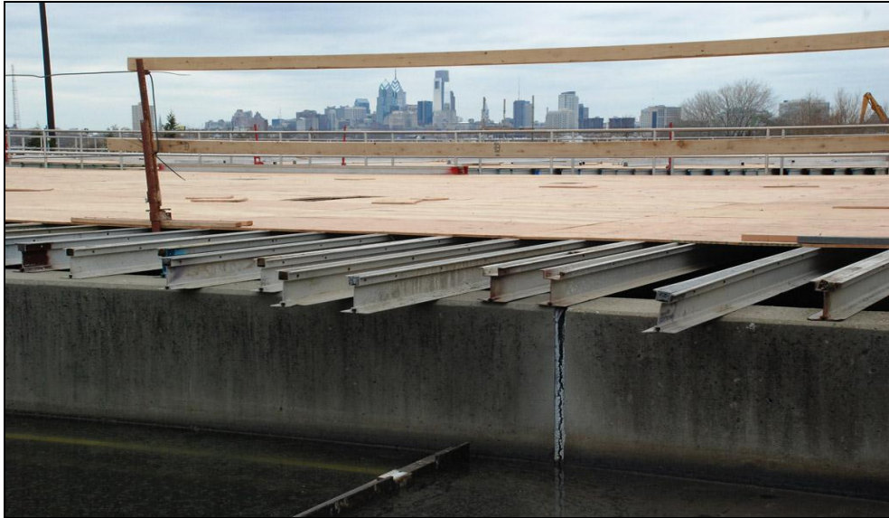
Şekil 3.26 Havuzlara Döşenen Kirişler Üzerindeki Ahşap Paneller( http://www.ccmua.org/?page_id=1818 )
