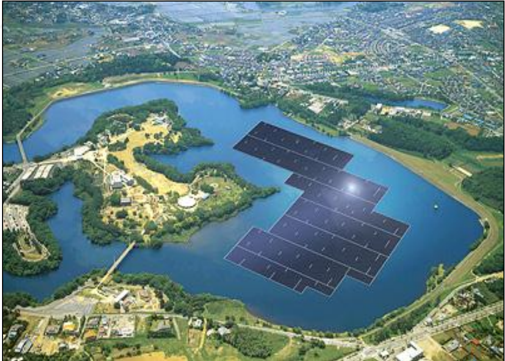
Şekil 3.20 13.7MW Fabrikasının Yamakura Barajı Rezervuarında Oluşturulması ( http://global.kyocera.com/news/2016/0102_knds.html ).
