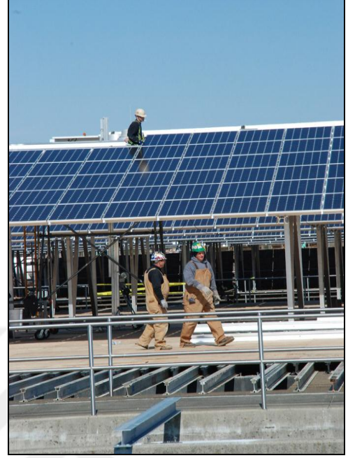
Şekil 3.28 Panellerin Montaj Aşaması ( http://www.ccmua.org/?page_id=1818 )
