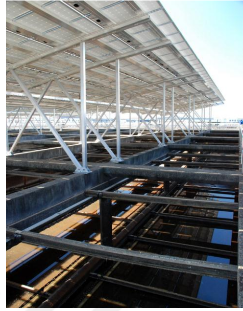
Şekil 3.32 Atıksu Tanklarının Üzerine Döşenen Alüminyum Kirişler ( http://www.ccmua.org/?page_id=1818 )
