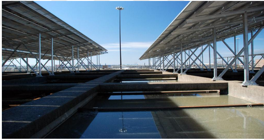
Şekil 3.33 Tankların Üzerine Kurulan Panellerin Son Hali ( http://www.ccmua.org/?page_id=1818 )
