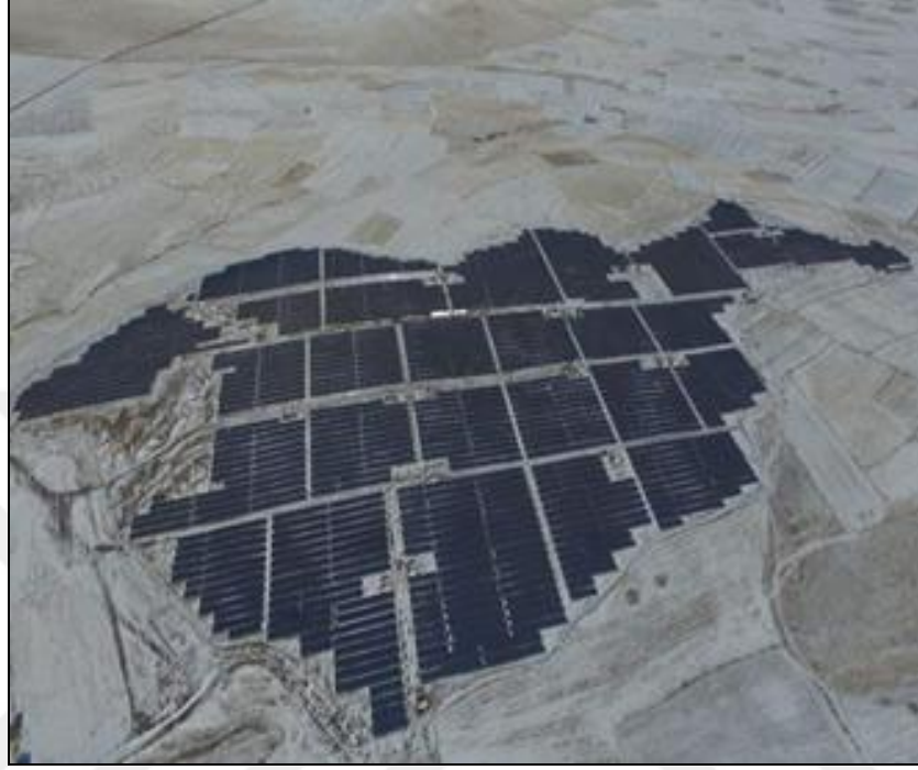
Şekil 3.50 Derinkuyu Güneş Enerjisi Santrali( http://www.enerjiatlası.com/gunes/derinkuyu-gunes-enerjisi-santrali.html )
