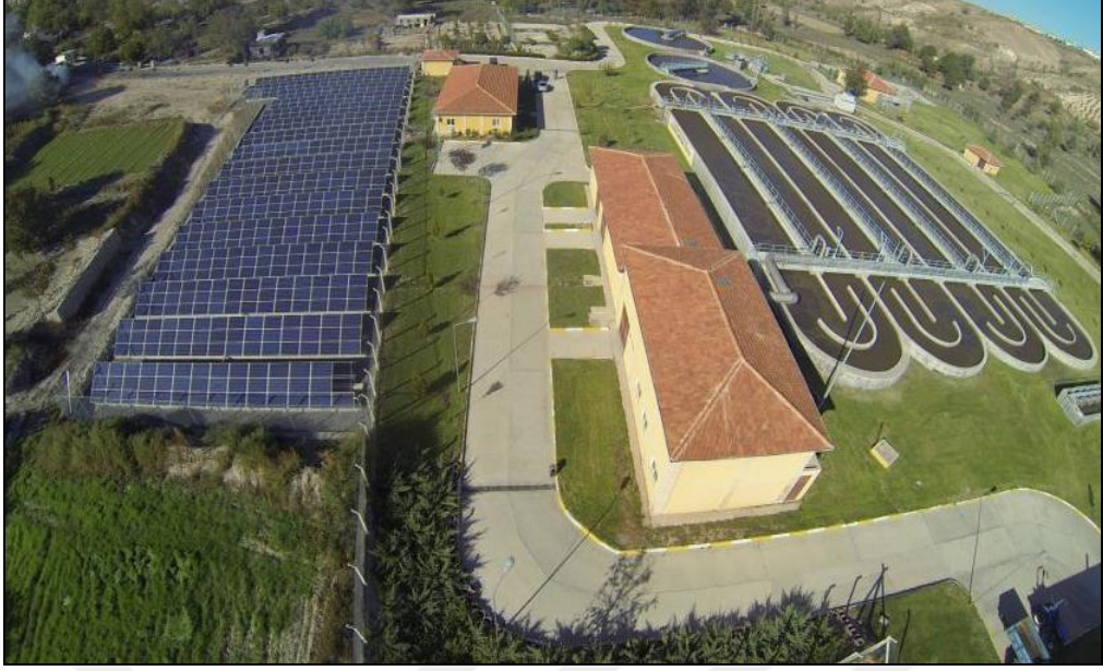
Şekil 3.55 Nevşehir Belediyesi Biyolojik Atık Su Arıtma Tesisi( http://www.lalehaber.com/haber-nevsehir-belediyesi-gunes-panelleri-ile-elektrik-uretiyor-12889.html )
