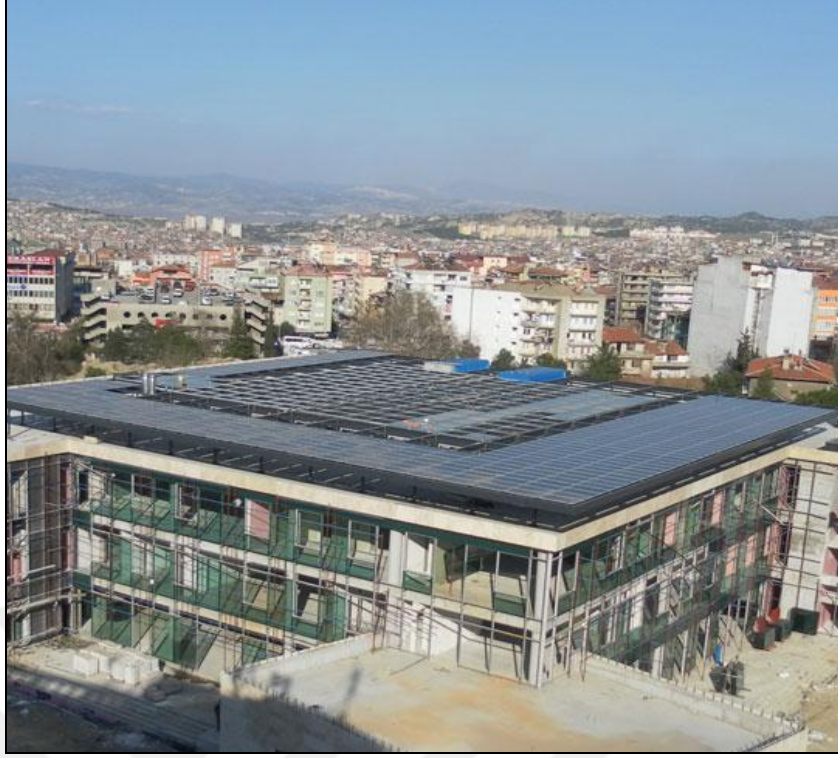
Şekil 3.51 Denizli Hükümet Binası BIPV Çatı Uygulaması ( http://gsrenerji.com.tr/index.php/referanslarimiz )
