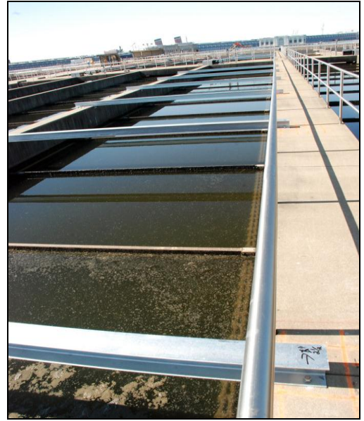
Şekil 3.30 Tankları Aralayan Alimünyum Kirişler ( http://www.ccmua.org/?page_id=1818 )
