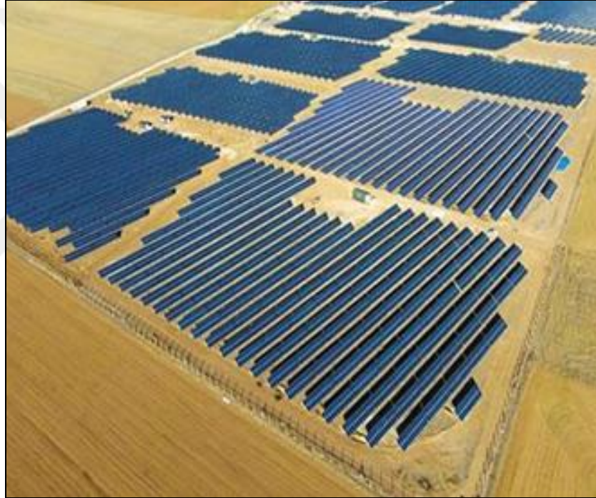
Şekil 3.49 Konya Karatay Kızören Güneş Enerji Santrali ( http://www.enerjiatlası.com/gunes/karatay-kizoren-ges.html )
