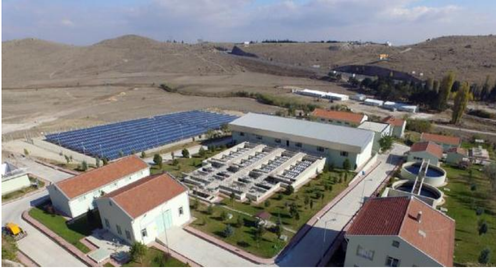
Şekil 3.54 Afyonkarahisar Belediyesi İçmesuyu Arıtma Tesisi ( http://afyonkarahisar.bel.tr/news/1/5437/gunes-enerji-santrali-hedefleri-as.aspx )
