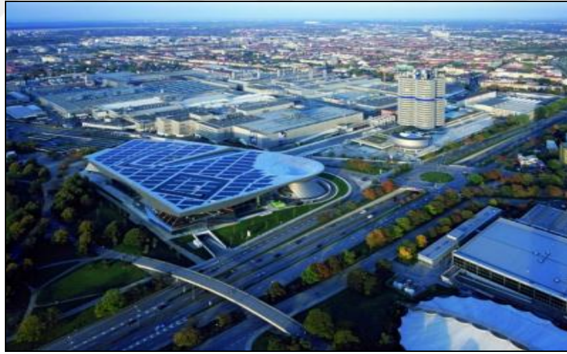
Şekil 3.13 BMW Binası ( http://www.coop-himmelblau.at/ )
