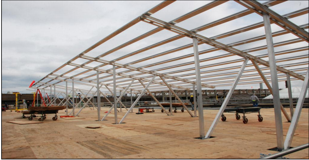
Şekil 3.25 İskele İnşaati, Camden, NJ Atıksu Tesisi( http://www.ccmua.org/?page_id=1818 )
