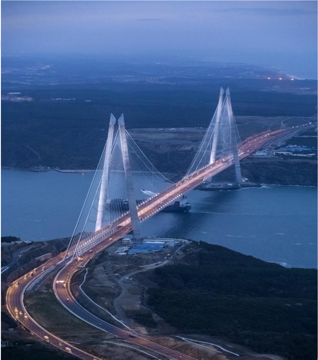
Şekil 4.11: Yavuz Sultan Selim Köprüsü
