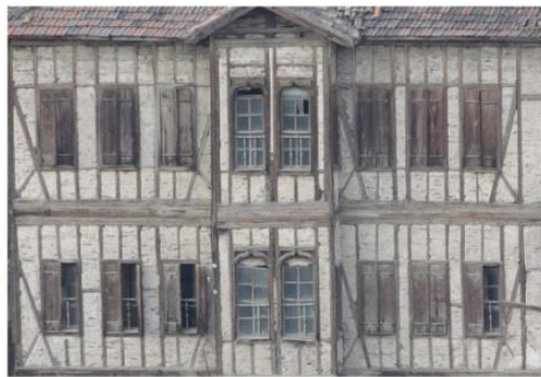
Hımış duvar örneđi, Safranbolu
