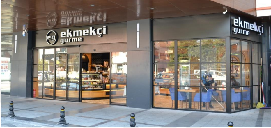
Şekil 4.4.13 Güneşli Şubesi-Cephe Fotoğrafi
