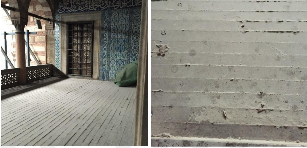
Şekil 4.52: Hünkâr mahfilini balkonun ahşap kaplama zemin (2018)
