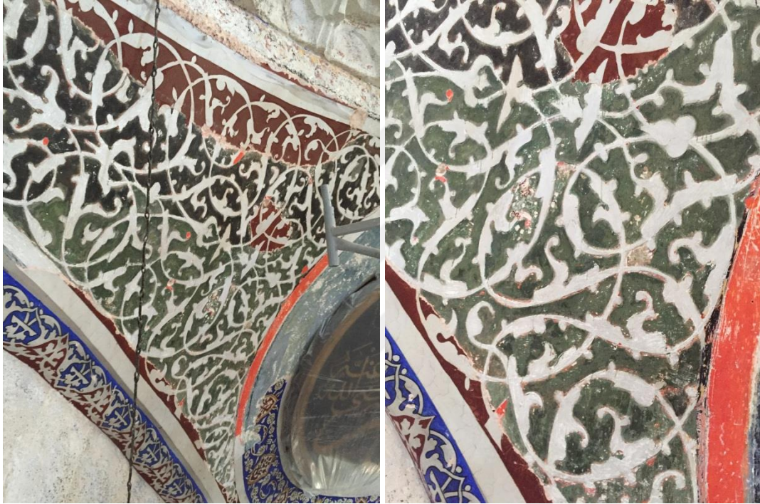
Şekil 6.39: Araştırma raspa sonucu pandantiflerde ortaya çıkan özgün malakâri yüzeyler (2018)
