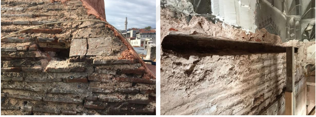
Şekil 6.20: Avlu kuzeybatı yönündeki giriş revağının kubbe kasnağındaki hatıl boşluğu (GETA,2017)
