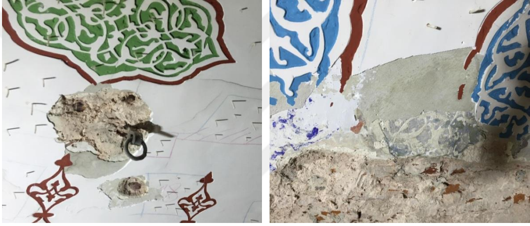
Şekil 6.23: Ana kubbe çimento sıvalı yüzeyler (2018)
