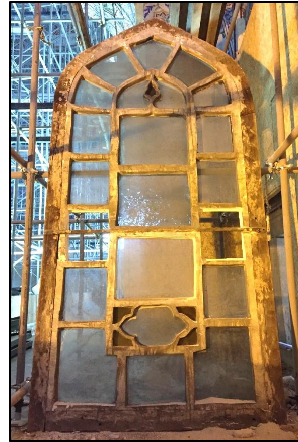
Şekil 5.9d : Özgün ahşap kasalı içlik pencere (2018)
