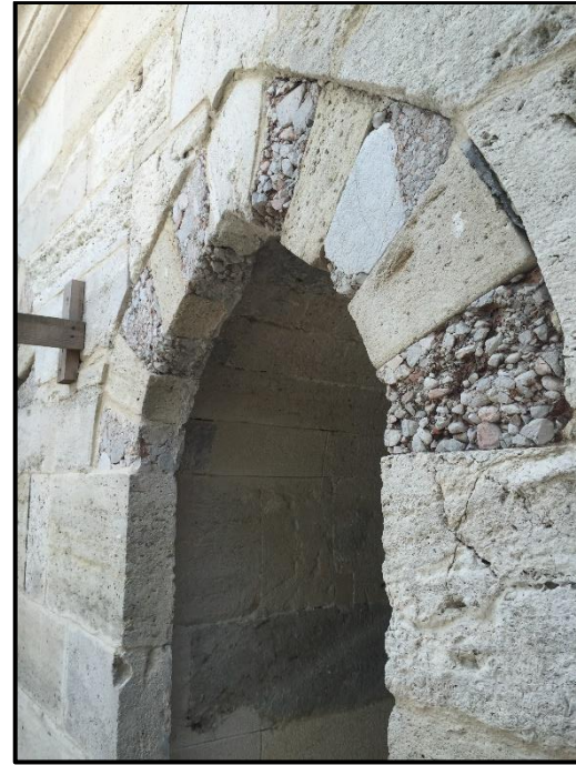
Şekil 5.5c: Kuzeybatı cephesi, almasıık örgü sivri kemer pencere (2018)
