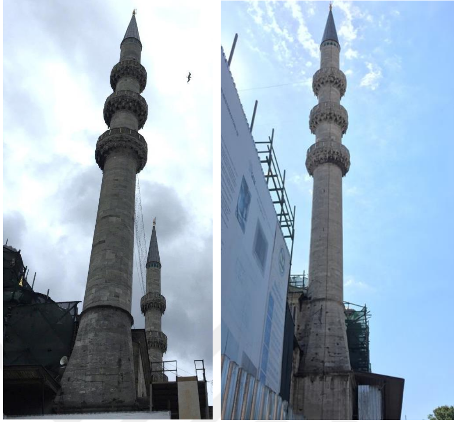
Şekil 4.32: Yeni Cami kuzeydoğu (sol) ve güneybatı (sağ) minareleri (2018)
