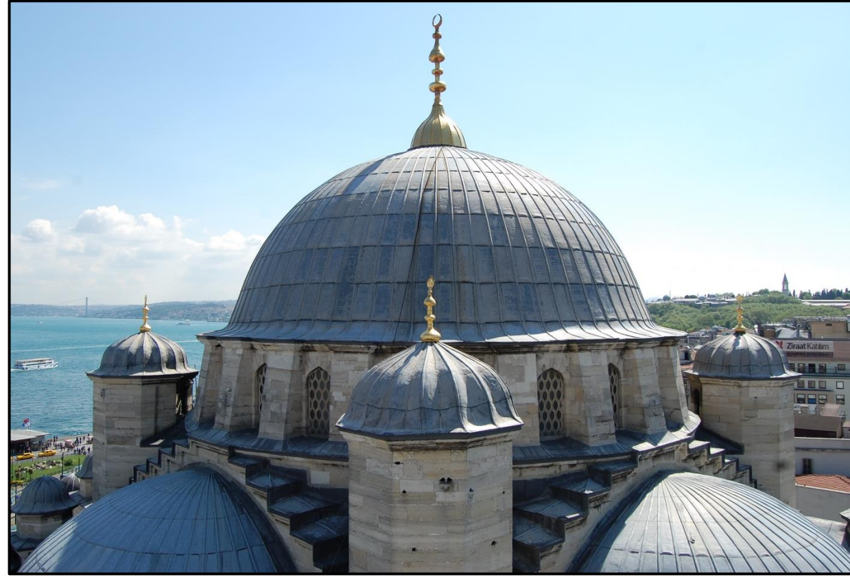
Şekil 5.15a: Kurşun örtü ve bakır alemler – ana kubbe bakır alemi (GETA,2016)
