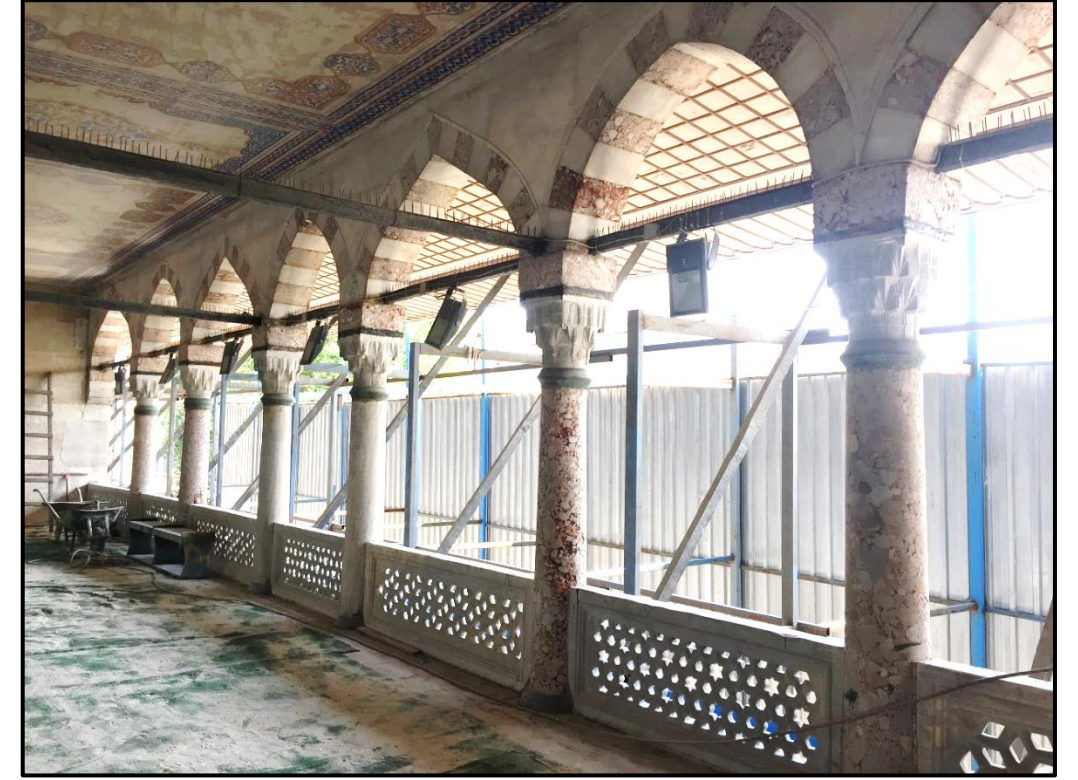
Şekil 5.3a: Güneybatı cephesi, yan galeri Marmara mermeri ve Hereke pudingi sütunlar (2018)
