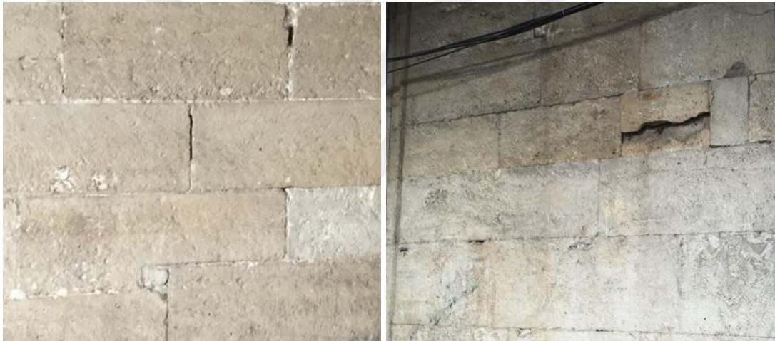
Şekil 4.49: Harimin (sol) ve avlunun (sağ) küfeki taş duvarları (2018)
