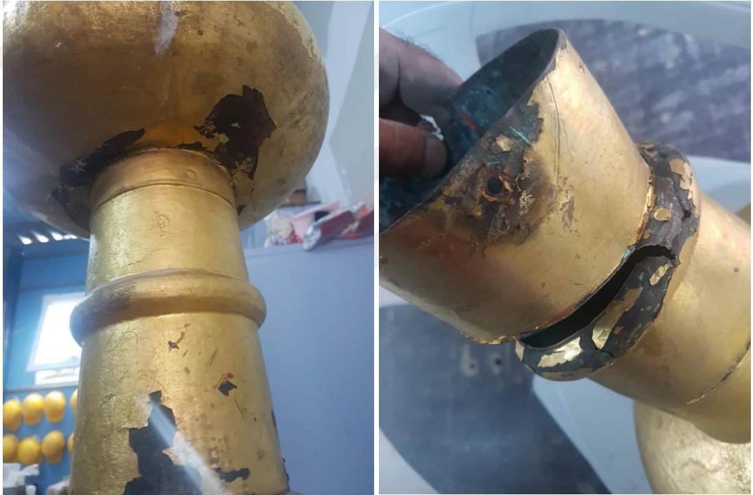
Şekil 6.47: Bakır alemlerde görülen bozulmalar (GETA, 2018)
