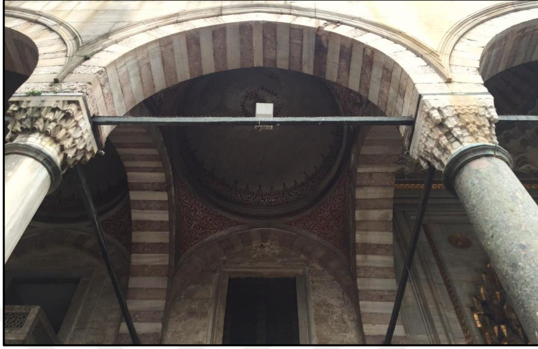
Şekil 5.14a: Avlu revak kemerleri arasındaki demir gergi (2018)
