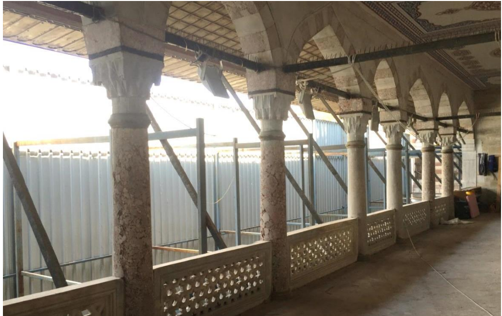
Şekil 4.18: Kuzeydoğu cephesi galerisi üst kat balkonu, kemerlerle bağlanan taş sütunlar (2018)
