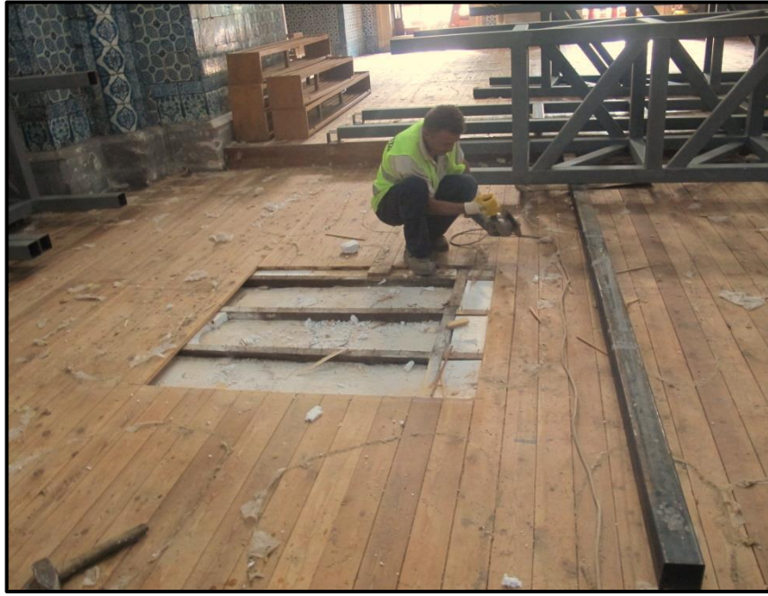
Şekil 5.8c: Harim zemini ahşap kaplama tahtaları (GETA. 2016)
