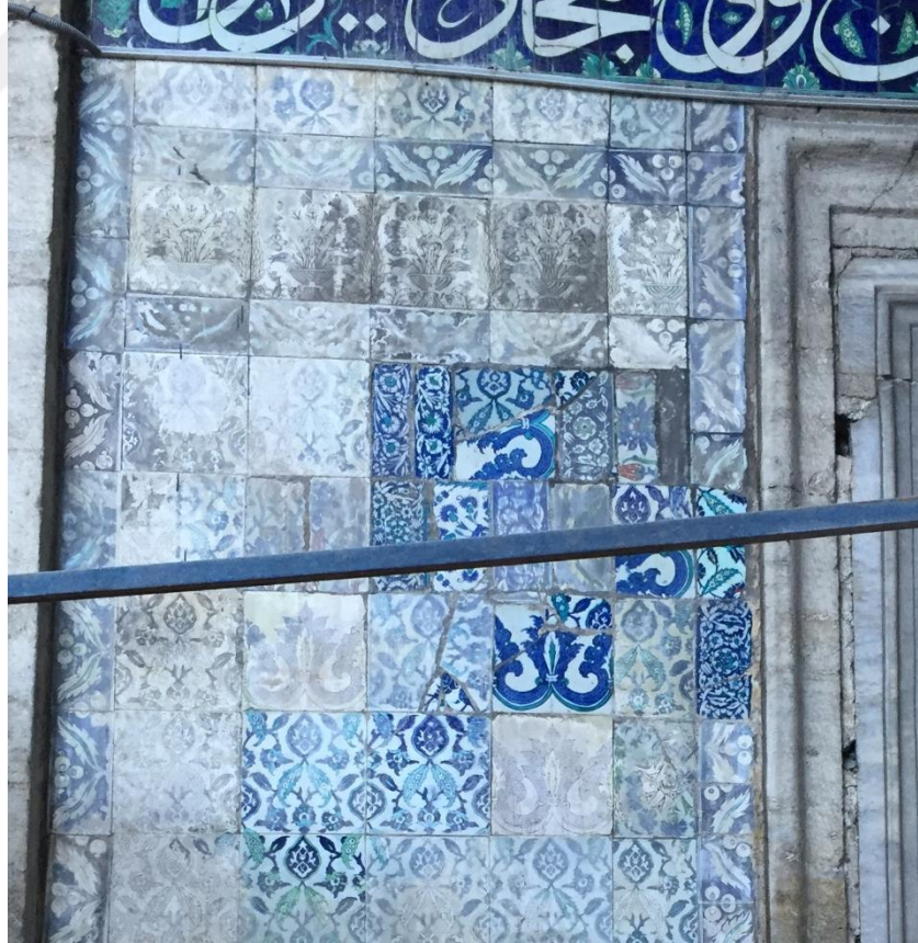
Şekil 6.44: Son cemaat yeri duvarındaki yanlış yerleştirilmiş olan özgün çini karolar
