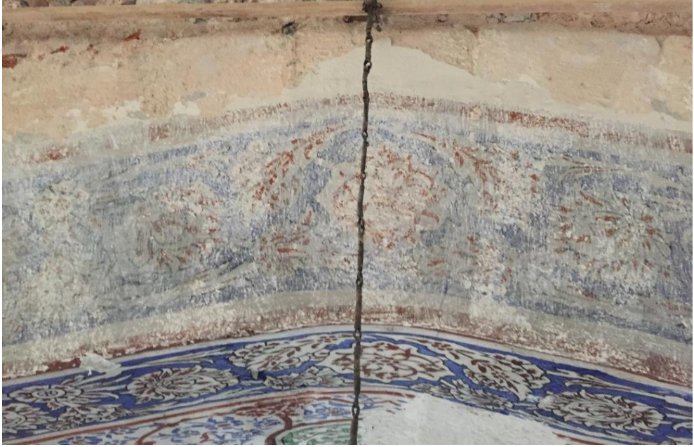
Şekil 6.31: Araştırma raspaları sonucu yarım kubbe kemer yüzeyinde ortaya çıkan üçüncü dönem kalemîşi bezemeler (2018)
