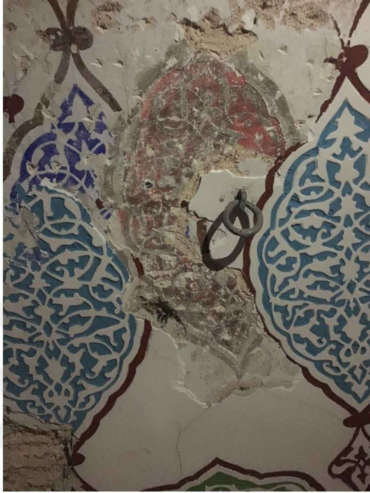
Şekil 6.32: Araştırma raspaları sonucu ana kubbede ortaya çıkan birinci dönem malakâri, üçüncü dönem kalemîşi ve son dönem malakâri bezemeler (GETA, 2018)
