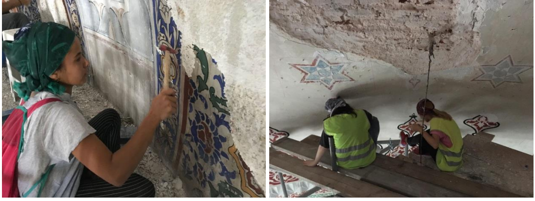
Şekil 6.28: Harim, yarım kubbelerde raspa yapılması (2018)
