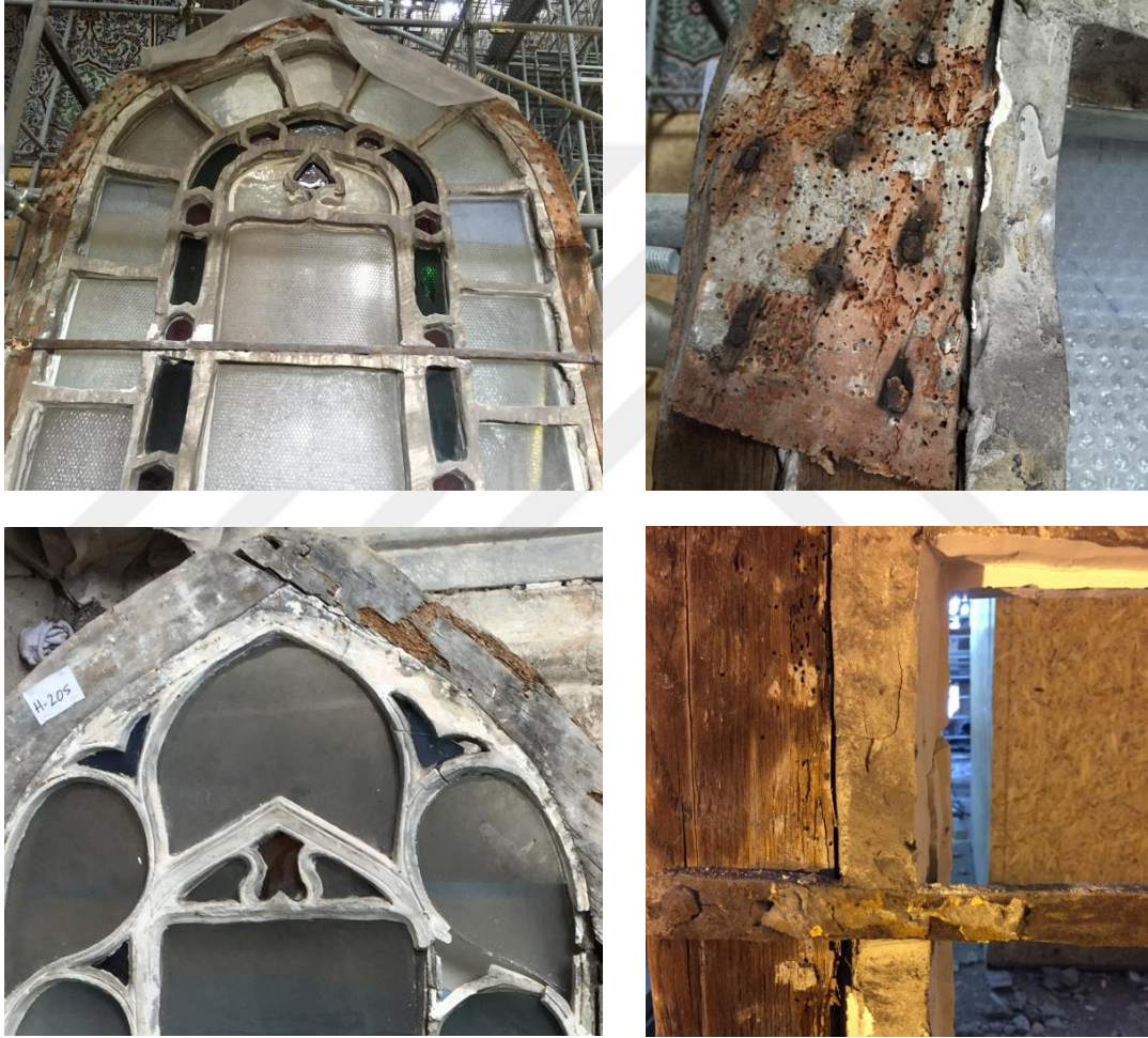
Şekil 6.17: Özgün ahşap kasalarda görülen bozulmalar (2018)
