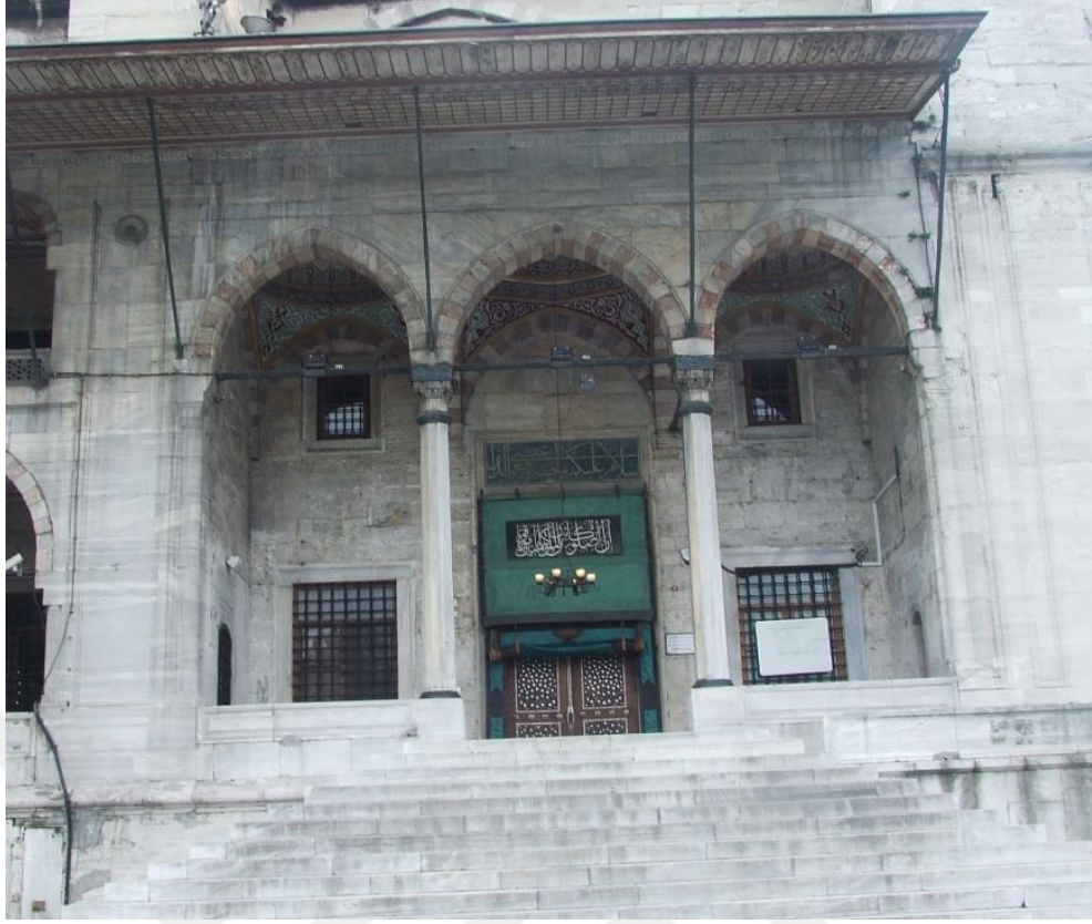
Şekil 4.36: Kuzeydoğu cephesi harime girişi sağlayan cümle kapısı (GETA, 2016)
