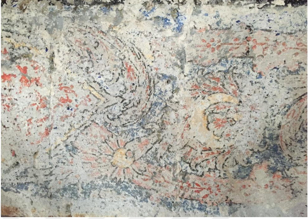
Şekil 6.30: Araştırma raspaları sonucu yarım kubbe kemer yüzeyinde ortaya çıkan birinci dönem kalemîşi bezemeler (2018)
