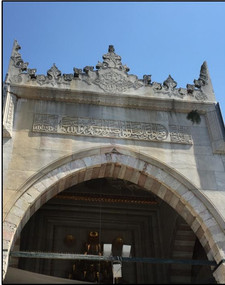
Şekil 5.4d: Güneybatı cümle kapısı giriş revağı, mermer taç ve kitabe (2018)
