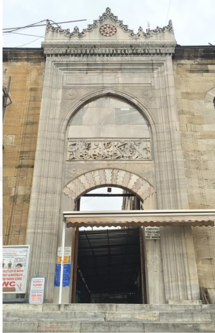
Şekil 4.42: Güneybatı cephesinden avluya girişi sağlayan taç kapı (2018)
