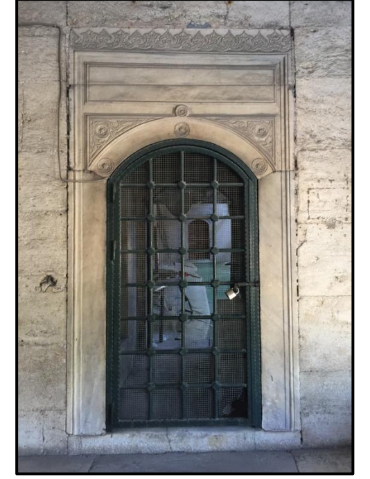
Şekil 5.14d: GB yan revağa geçişi sağlayan demir şebekeli kapı (2018)
