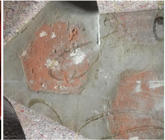
Şekil 4.51: Mahfil katı altıgen tuğla döşemesi (2018)
