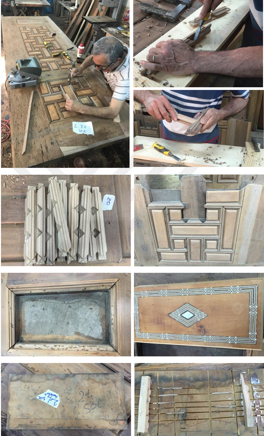
Şekil 6.15: Merhamet tamirlerinin yapılması (2018)
