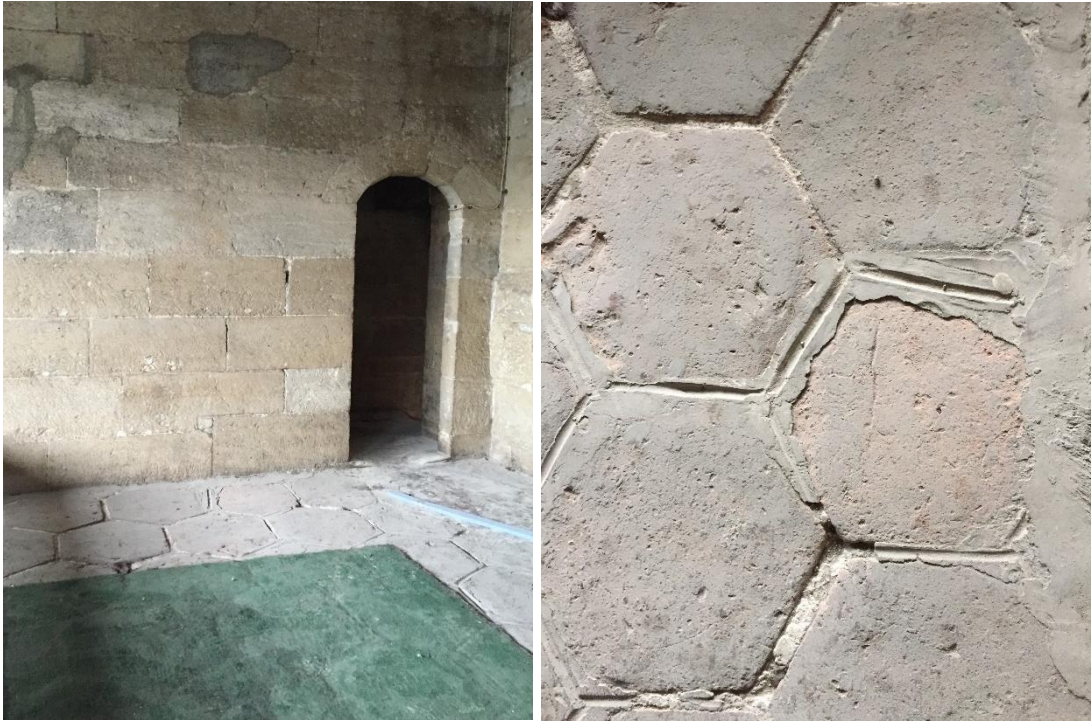
Şekil 4.53: Kuzeybatı yönündeki balkonun altıgen tuğla döşemesi (2018)
