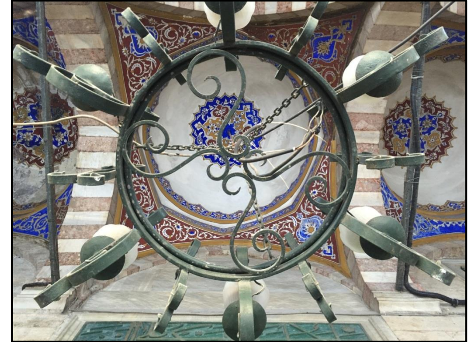
Şekil 5.14e: GB cümle kapısı giriş revağı demir kandili (2018)
