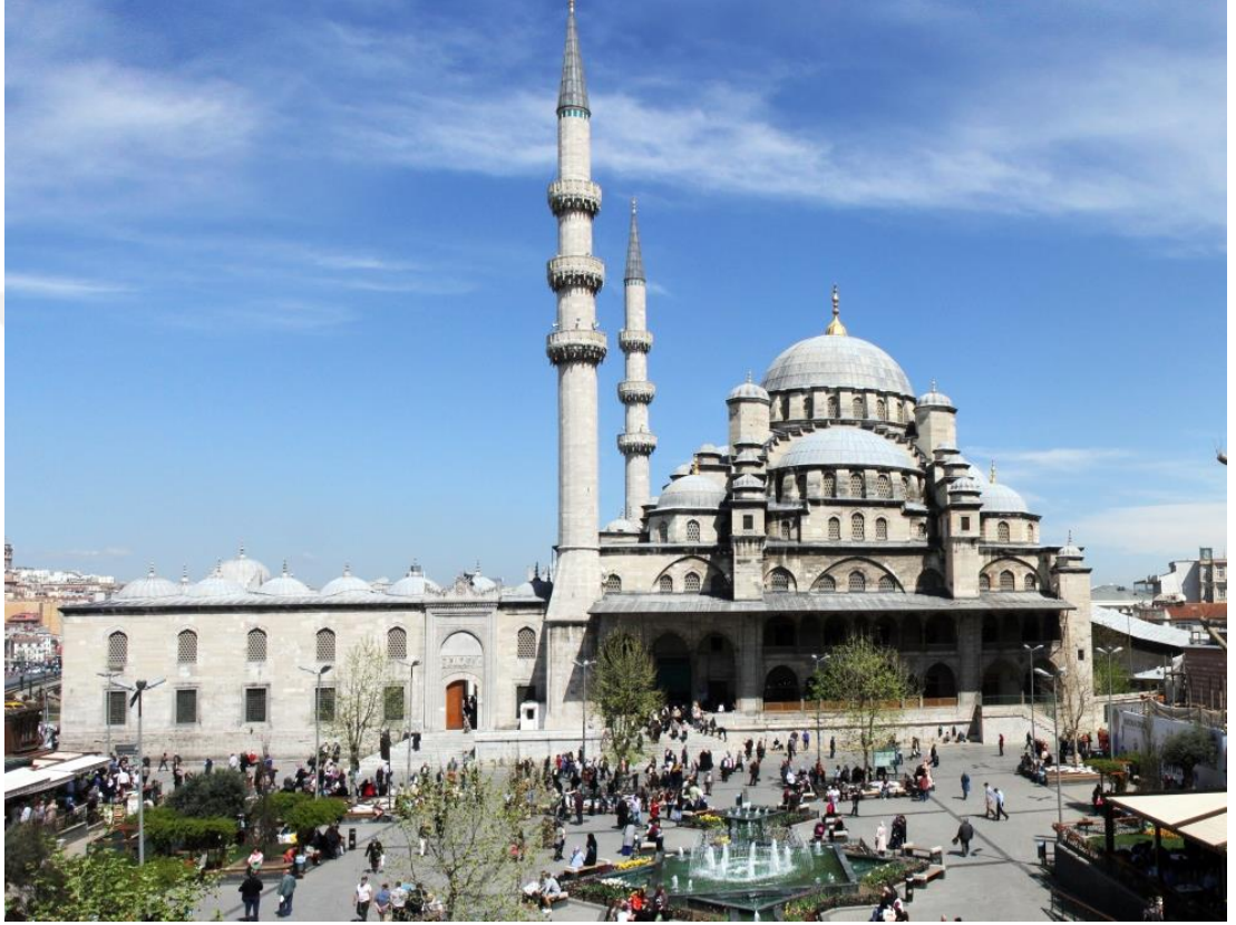
Şekil 4.38: Yeni Cami güneybatı cephesi (Ceylan, 2016)
