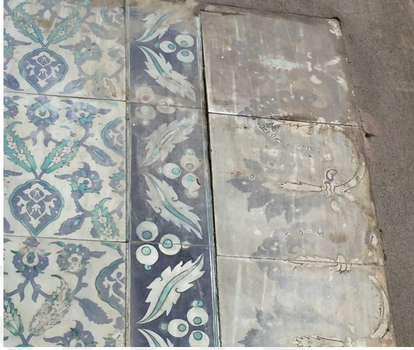
Şekil 6.43: İmitasyon çinilerde görülen renk kaybı ve ondülasyon (2018)
