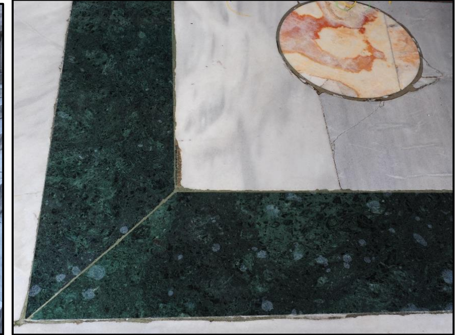
Şekil 5.1d: Serpantin breşi bordür-oniks disk yer döşemesi (2018)
