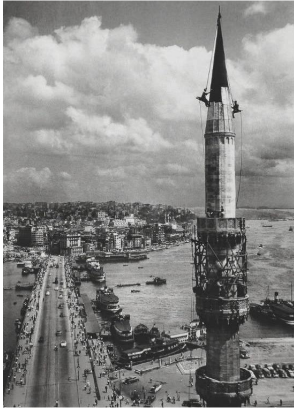
Şekil 3.3: Yeni Cami minare onarımı (www.potuks.com, erişim: 2018)
