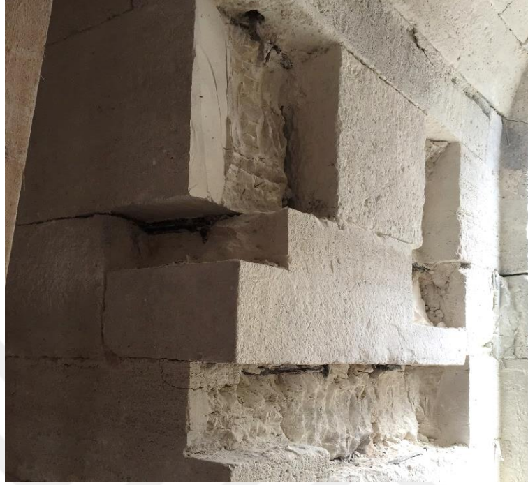
Şekil 6.7: Taş çürütmesi yapılan bölgeler (2018)
