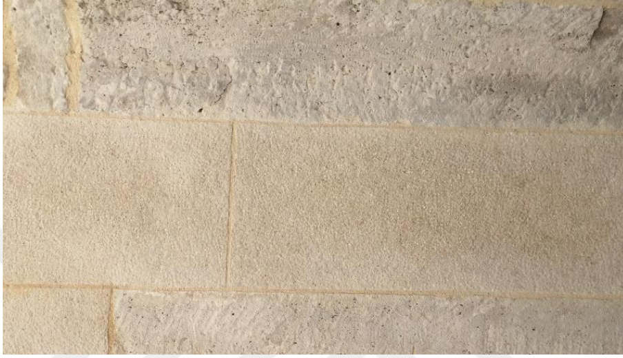
Şekil 6.6: Plastik onarım yapılan yüzeyler (2018)
