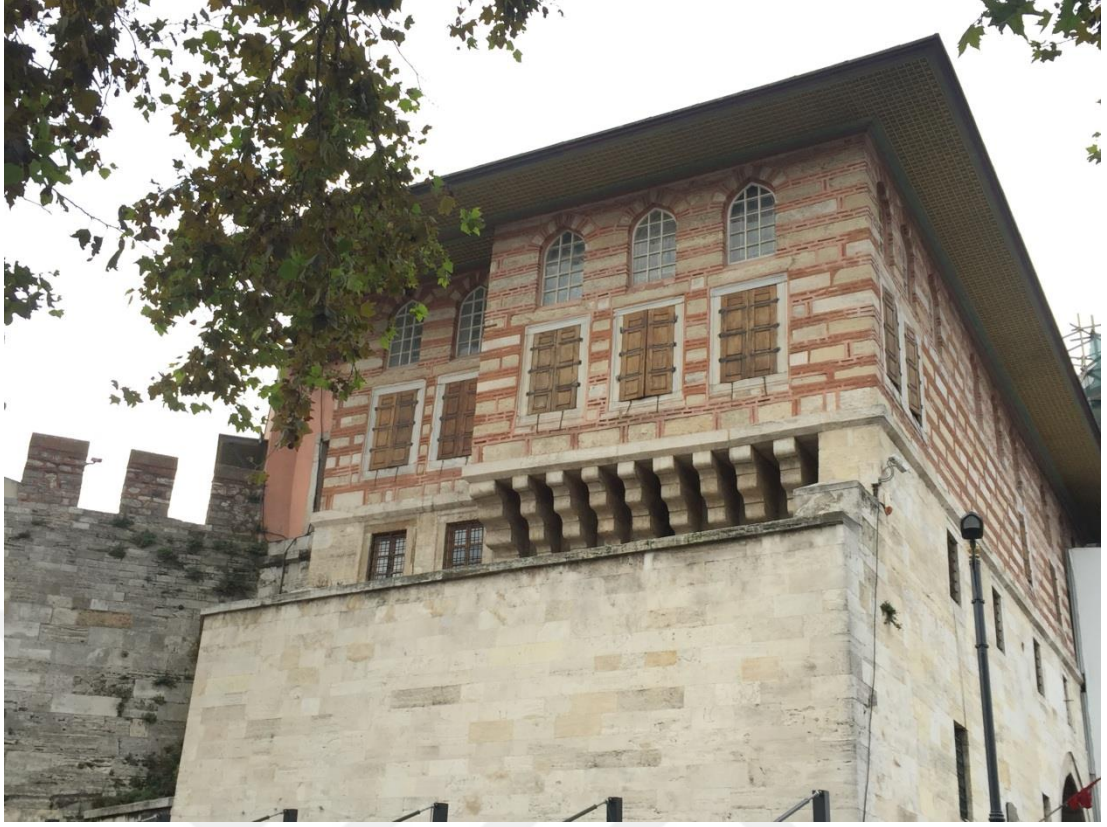
Şekil 2.6: Yeni Cami Külliyesi, Hünkâr Kasrı (2018)
