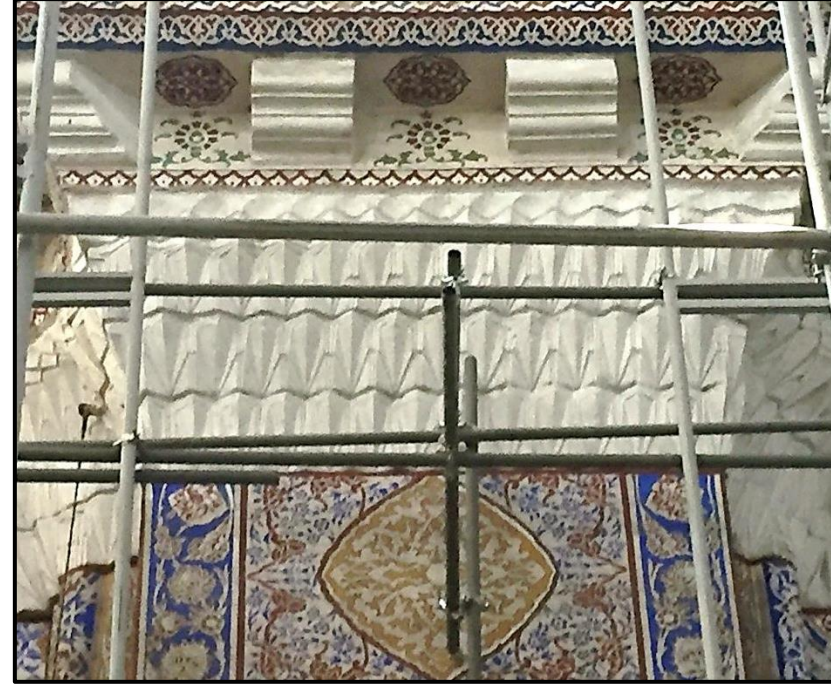
Şekil 5.12c: Filayağı üzengi seviyesi alçı kornişler (2018)
