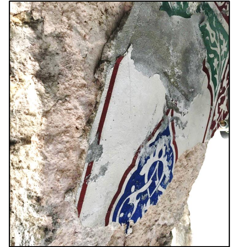
Şekil 5.10e: GB yarım kubbe çimento sıvalı yüzey (2018)
