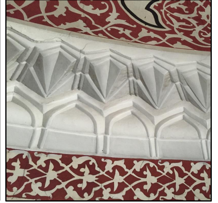
Şekil 5.12d: Güneybatı yarım kubbe kasmağı üst seviyesi alçı mukarnas korniş (2018)
