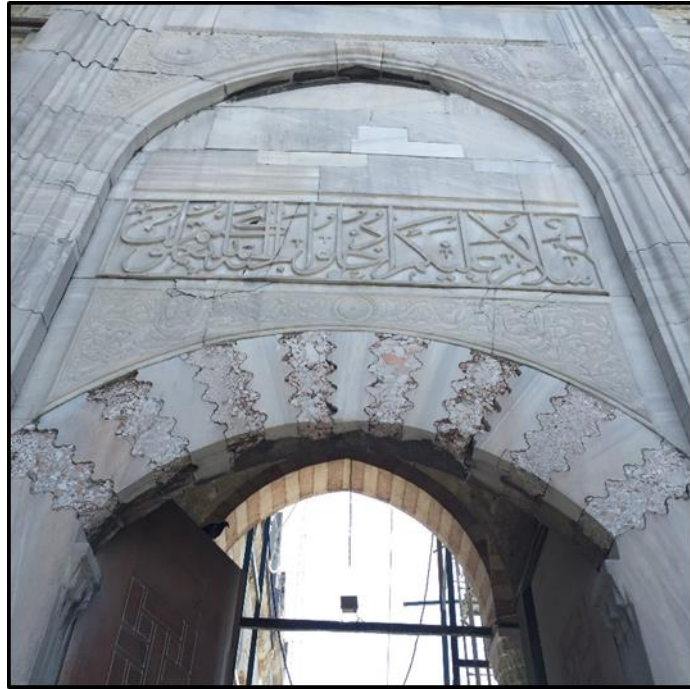
Şekil 5.5b: Kuzeybatı taç kapı, mermer-Hereke pudingi makaralı kemer (2018)
