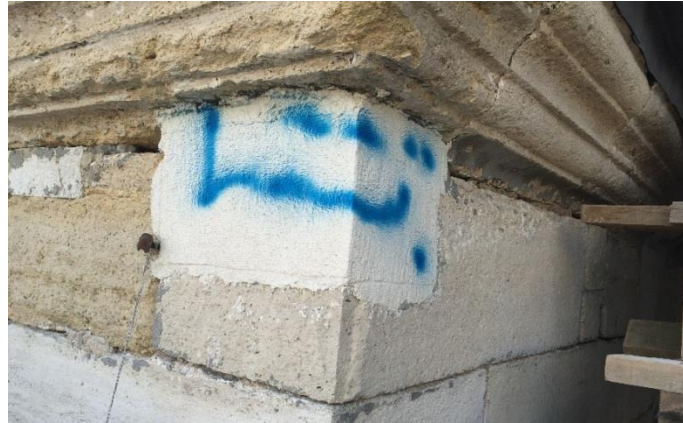
Şekil 6.5: Beyaz Portland çimentosu ile yapılan imitasyonların tespiti (2017)
