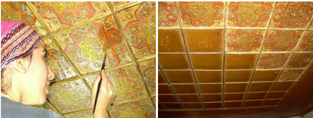
Şekil 6.19: Müezzin mahfilinin özgün edirnekâri tavanının ortaya çıkarılması (Önel, 2006).
