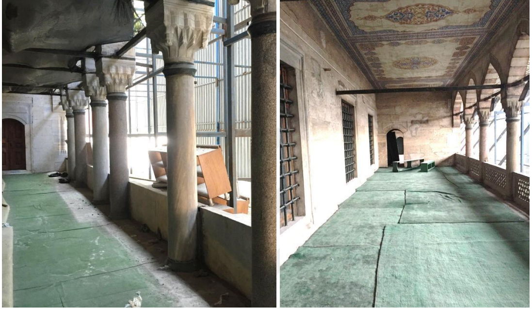
Şekil 4.17: Güneybatı cephesi galerisi alt katı (sol) ile üst kat balkonu (sağ) (2018)
