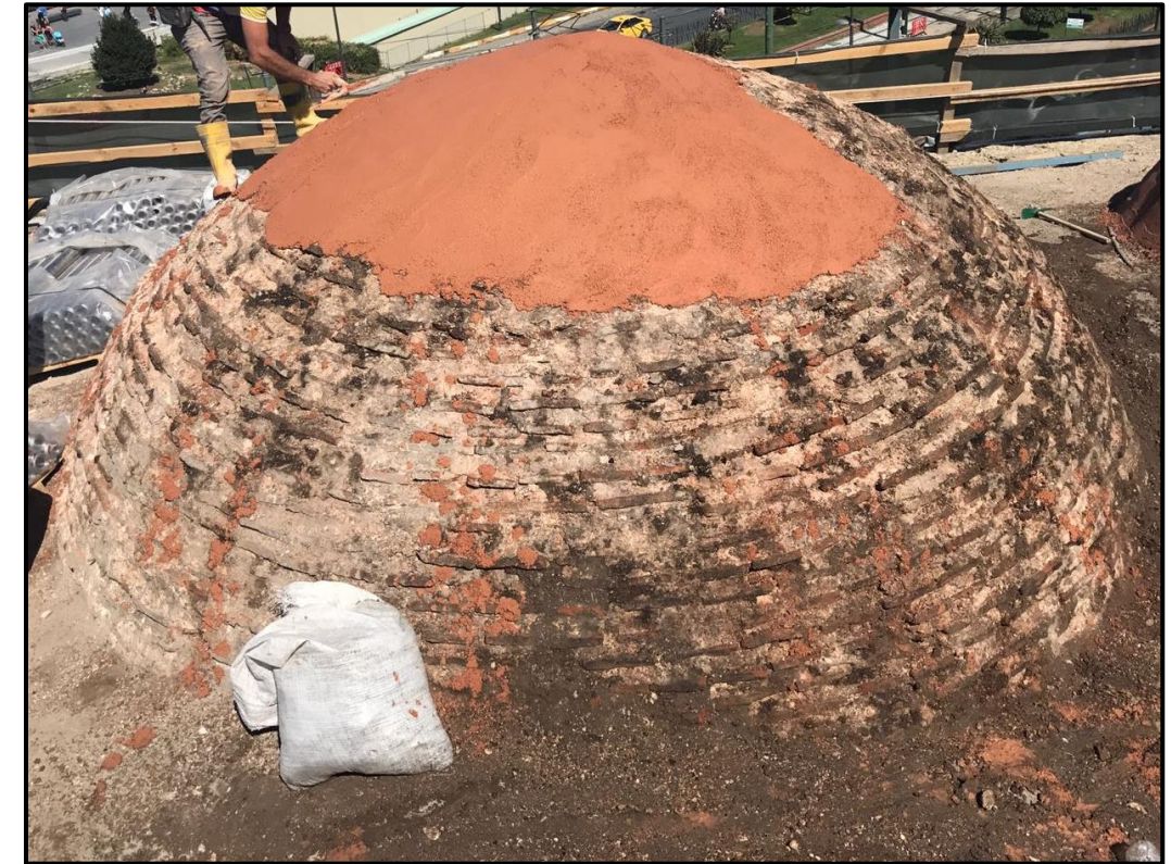
Şekil 5.6d: Avlu revak kubbesi tuğla örgüsü (GETA, 2017)
