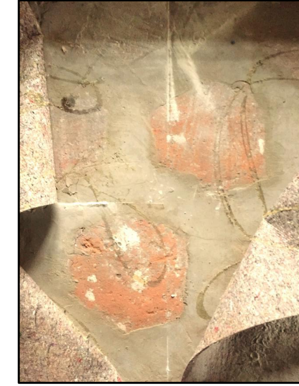
Şekil 5.6b: Mahfil zemini altıgen tuğla (2018)
