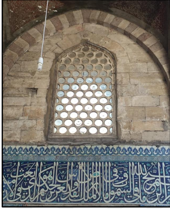
Şekil 5.12a: Avlu, alçı içlik revzen (2018)
