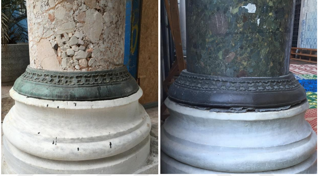
řekil 6.48: Avludaki tun stun bileziklerde grlen oksitlenme (2018)
