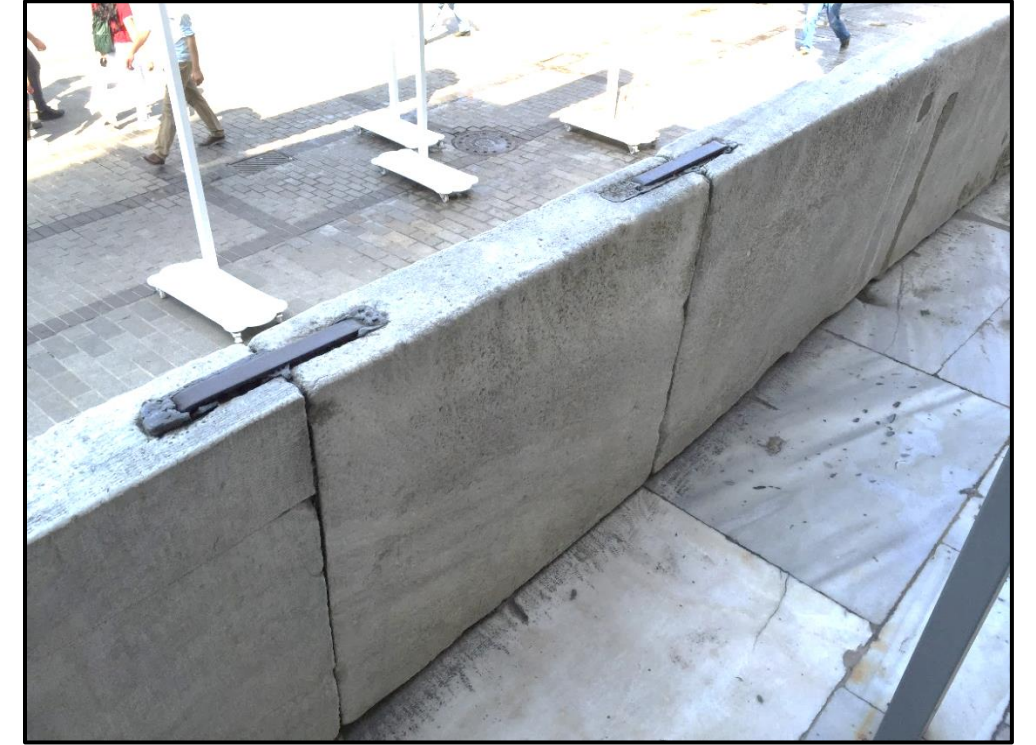
Şekil 5.1a: Mermer korkuluk ve kenet ile birleşimi (2018)
