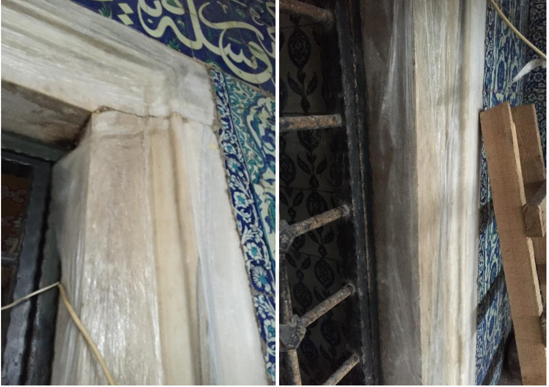
Şekil 6.8: AB57 sürülen yüzeylerin ambalaj kâğıdı ile kapatılması (2018)
