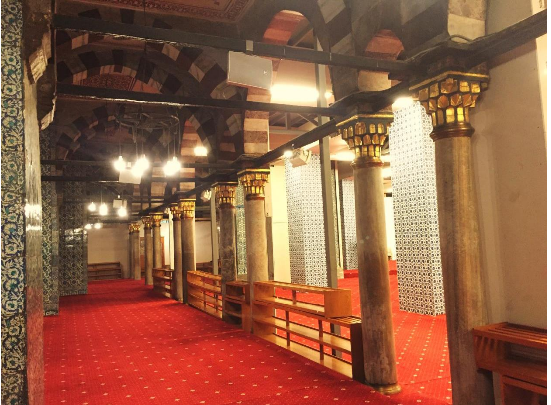
Şekil 4.12: Harim mekânı, kuzeydoğu yönü revak bölümü (2018)
