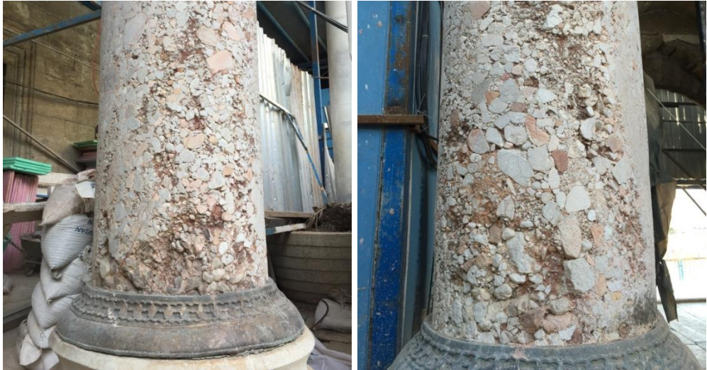
Şekil 6.11: Avlunun kuzeybatı giriş kapısının sağ ve solunda yer alan hereke pudingi sütunlarda görülen bağlayıcı kaybı erozyonu (2018)
