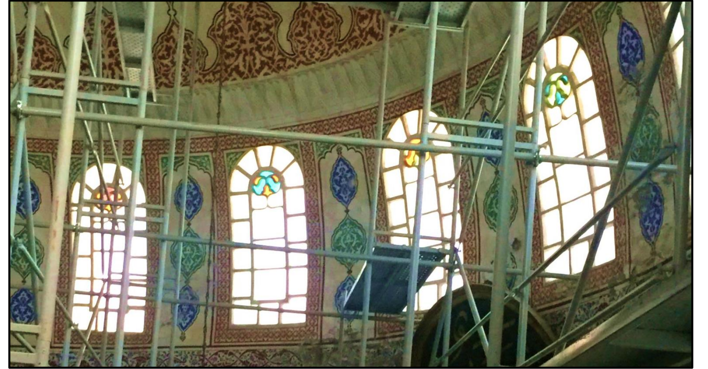
Şekil 5.11a: Güneybatı yarım kubbe, basit alçı içlik revzenler (2017)
