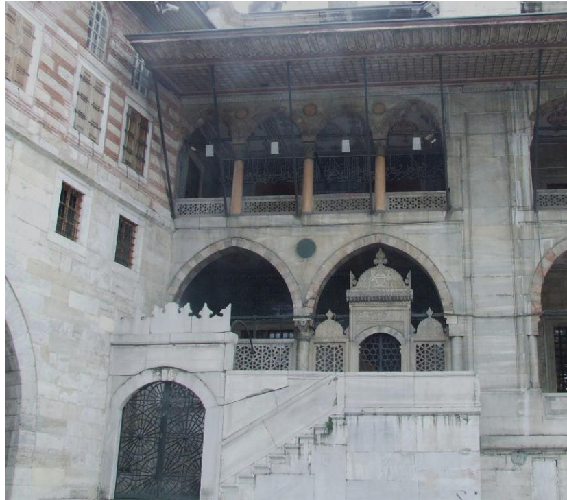
Şekil 4.34: Kuzeydoğu cephesi, Hu kapısının da bulunduğu yan galeri bölümü (GETA, 2016)
