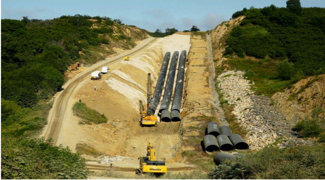
Şekil 3.4: Melen Projesi 2.Etap İnşaatı (URL-6).
