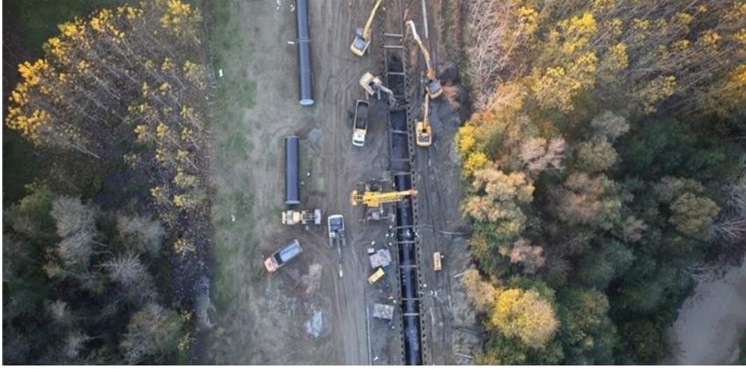
Şekil 3.3: Melen Projesi 3. Aşama 1. Kısım İnşaatı (URL-5).
