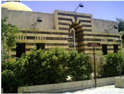
(Şekil 1.56): Yelbuğ Hamamı. (Aalo M.,2008)
