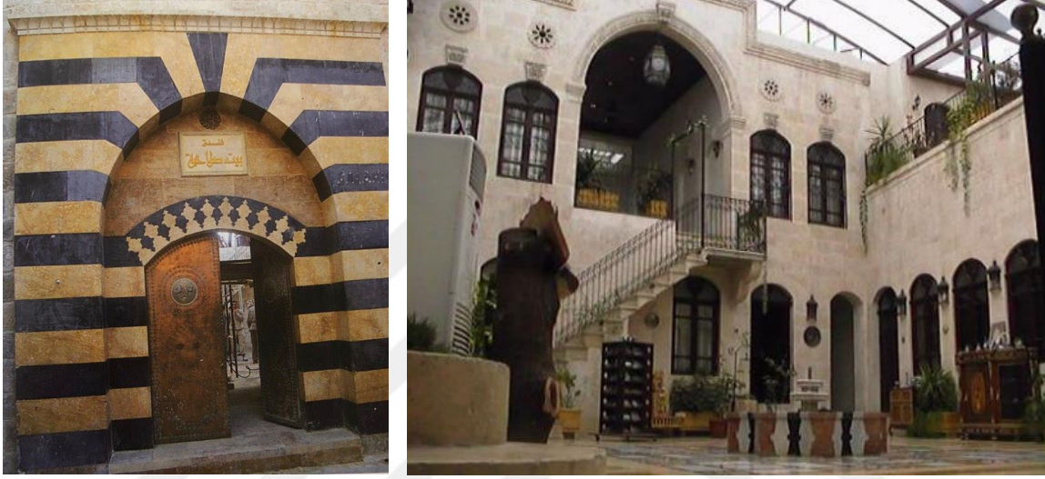
(Şekil 2.36):Salahieh Ailesi Evi Ana Girişi ve Avlusu(Gazi AntepÜniversitesi (2010).Halep’te AdımAdım Osmanlı’nın İzinde.S.356+357).
