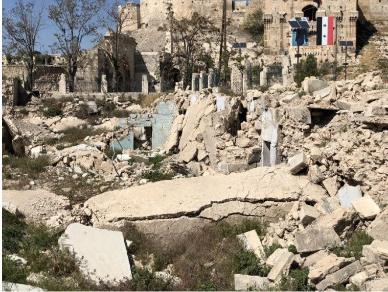
(Şekil 3.60): Husruviye Yıkılan Bölümleri(Nisan-2018).
