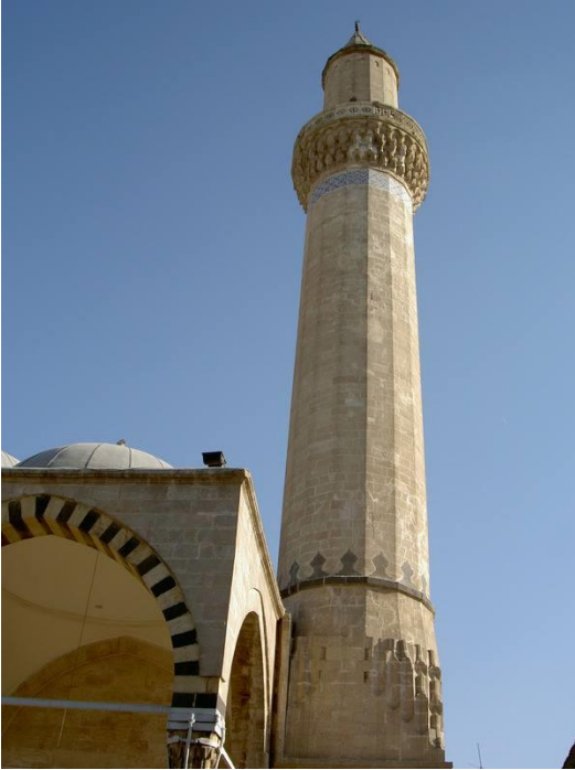
(Şekil 2.5):Hüsrüviye caminin Minaresi(2007).
