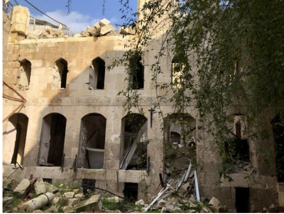
(Şekil 3.52):Vekil Evinde İç Cephesi(Ocak-2019).
