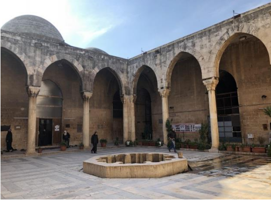
(Şekil 3.3):Firdevs Binanın Avlusu(Ocak-2019).
