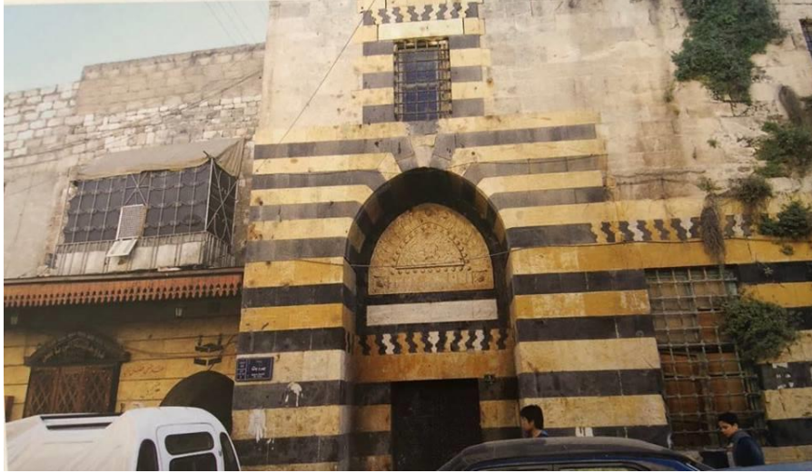
(Şekil 2.19):Behram Paşa Hamamı'n Dış Cephesi. (Gazi Antep Üniversitesi (2010).Halep'te AdımAdım Osmanlı'nın İzinde.S.566).
