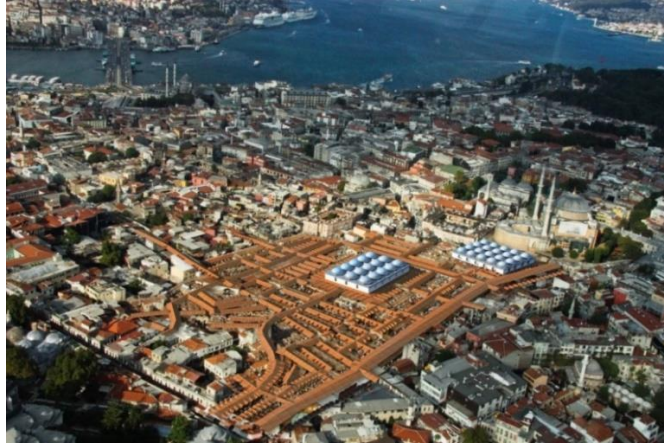
Resim E.76: Çatı Restorasyonu Günümüz (Fatih Bel. 2019).
