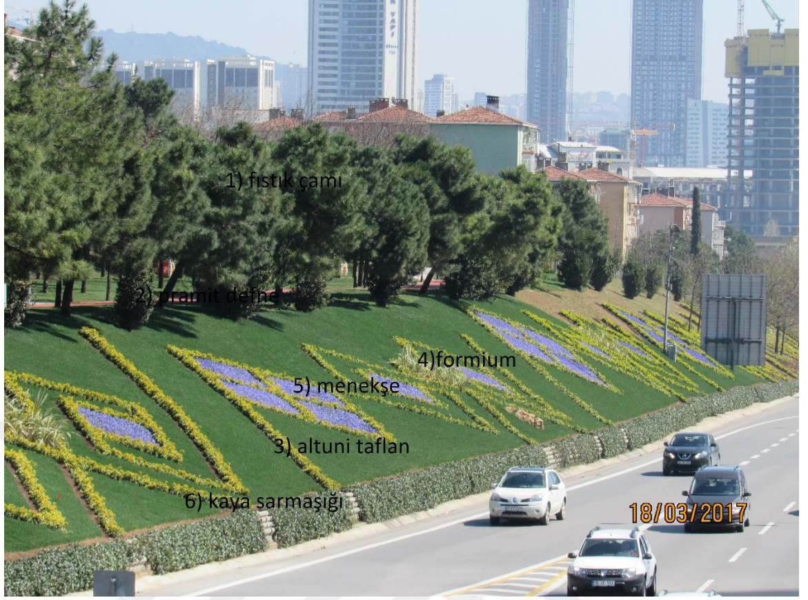
Şekil 6.58: Gülsuyu Kavşağı-Cevizli Kavşağı Arası (Orijinal)
