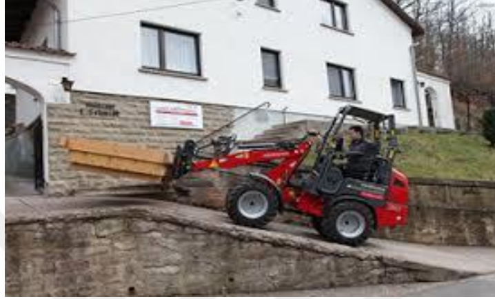
Resim 4.9 Eğimli yolda forklift ( Makine Eğitimi)
