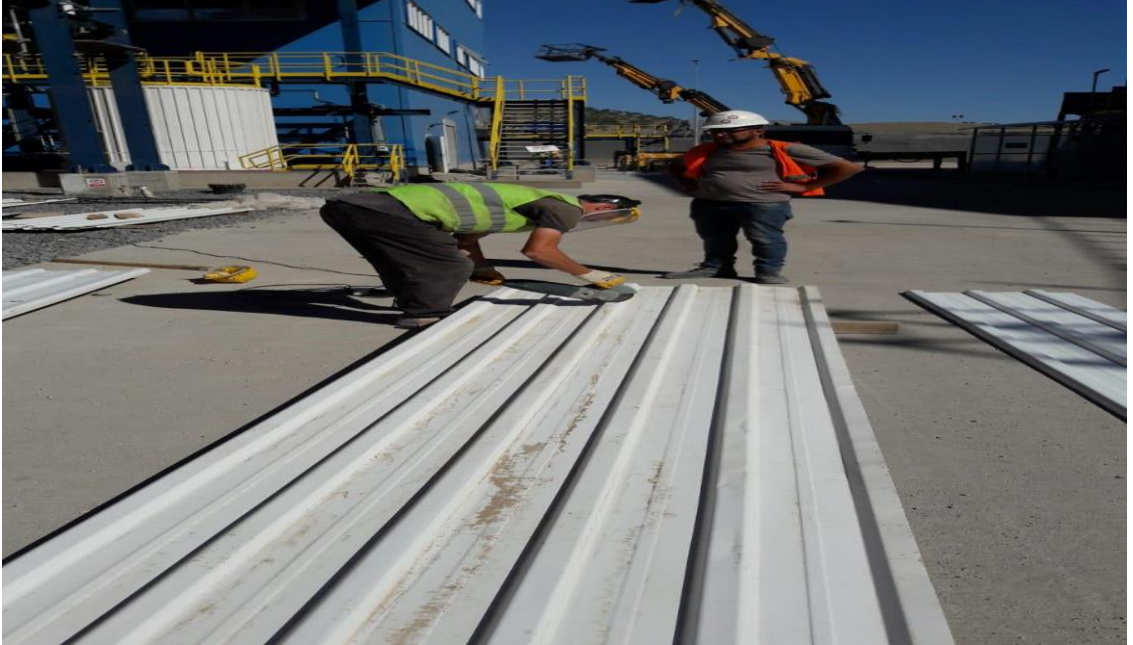
řekil 5.8. Sandvi panellerin kesimi. (Etibakır İřletme Sahası, 2019)
