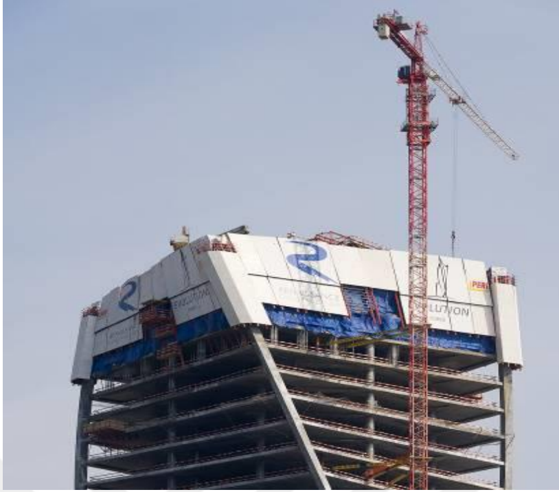
Şekil 29 : Evolution Tower Raylı (Rail Climbing System) Kalıp Sistemi
