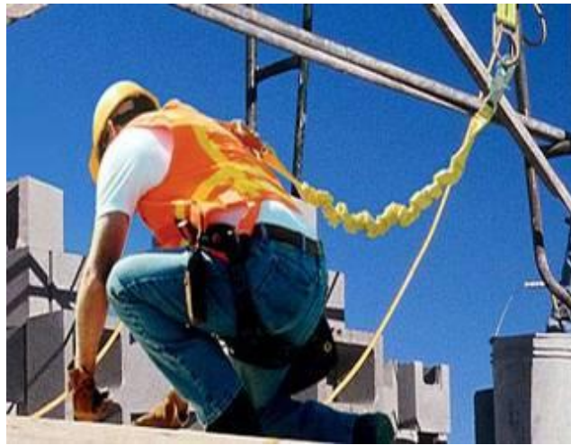
Şekil 30 : Çalışan düşme ve durdurma sistemi
