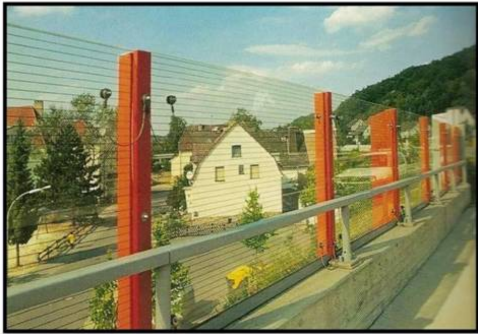
Görsel-6 Kuş çarpmalarına karşı şeritlere sahip bir cam perde 94
