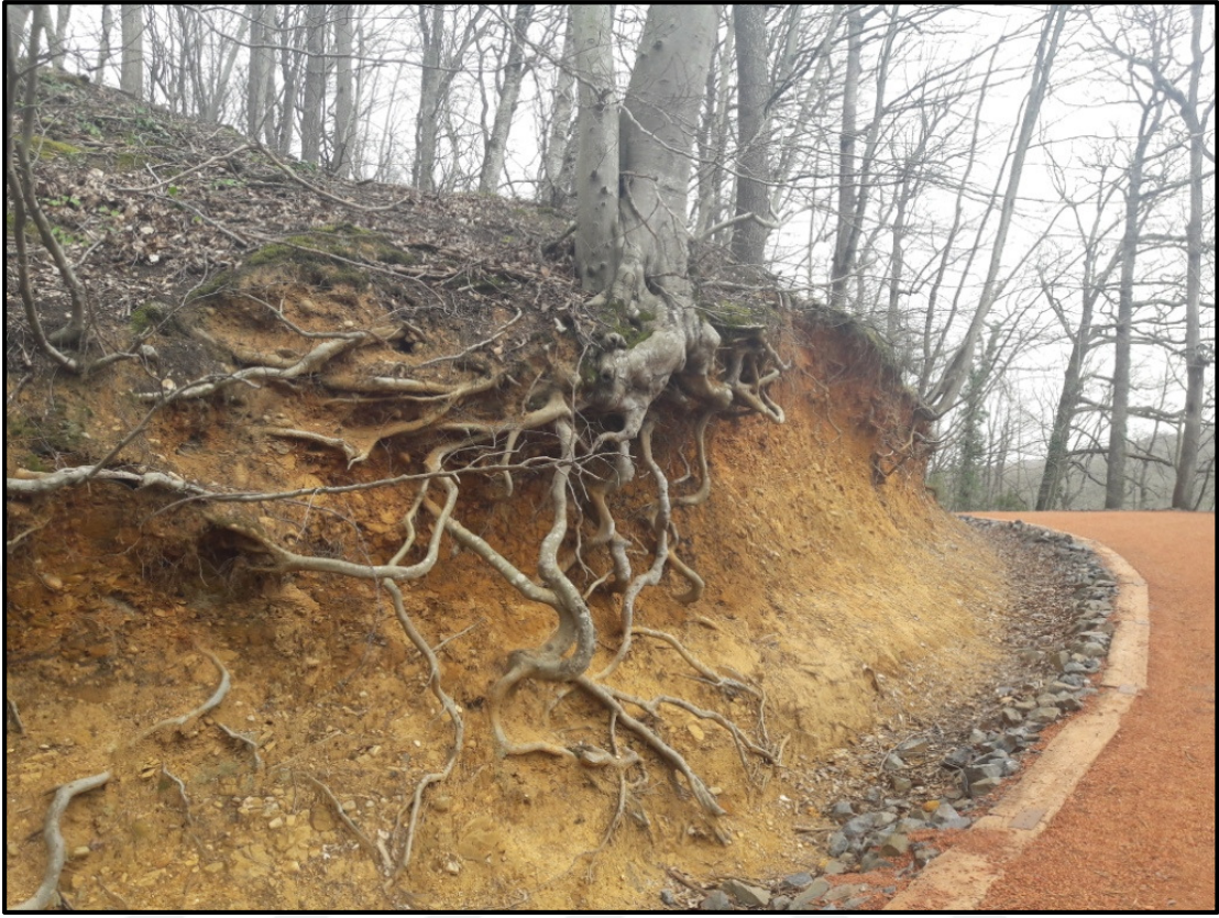
Şekil 2.2. Yamaç ve şevlerde bulunan ağaç/bitki köklerinin yüzeysel göçmeleri önlemesi (Fotoğraf çekim tarihi: 18 Mart 2018, Yer: Belgrad Ormanı, Sarıyer, İstanbul)
