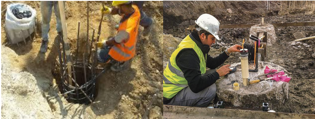
Şekil 19: İnklinometre borularının fore kazık ile beraber indirilmesi ve sonrasında ölçümlerinin yapılması.
