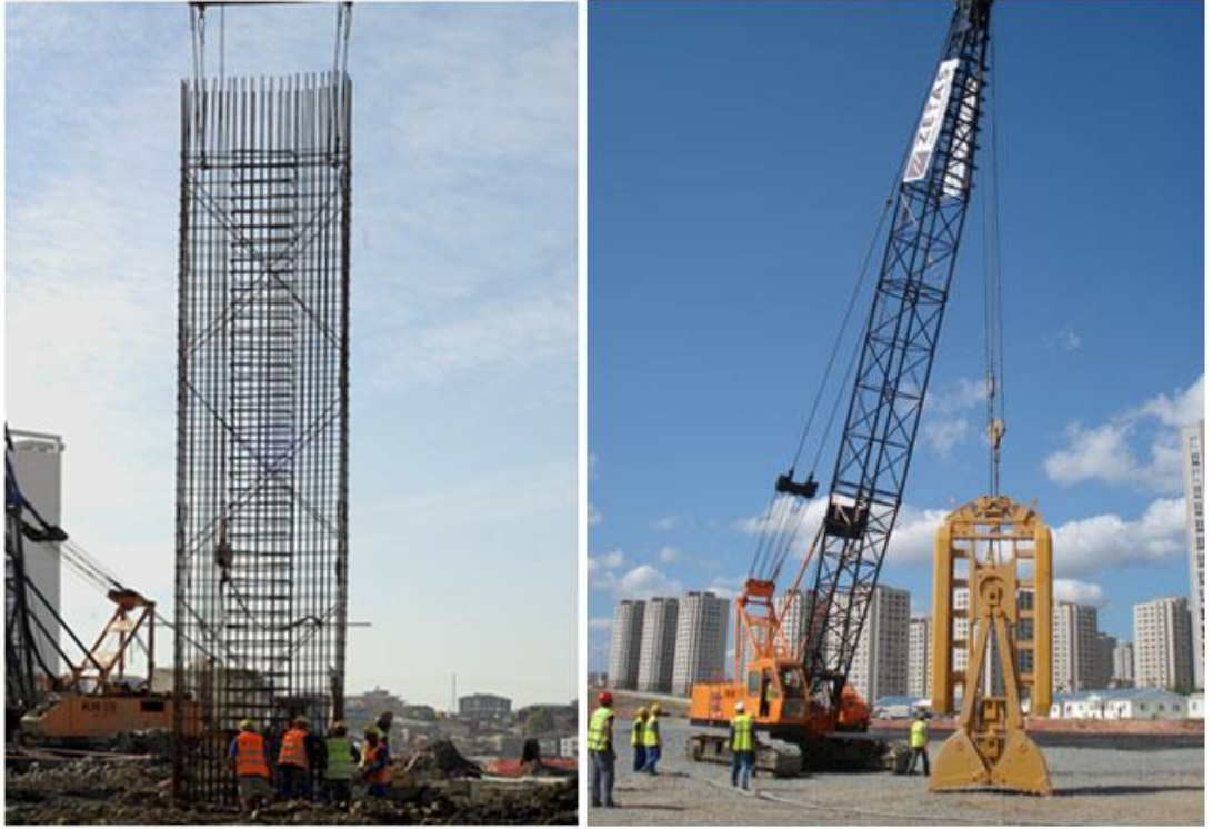
Şekil 9: Diyafram duvar donatı kafesi ve grab [14].
