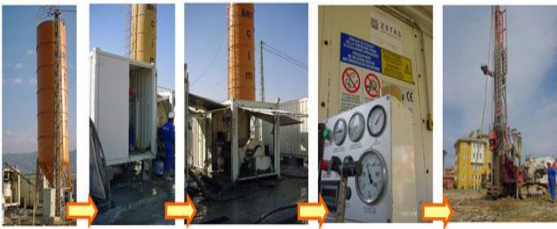
Şekil 14: Jet siloları ve jet kolon imalatı yapım sırasındaki sahadan fotoğraf [14].
