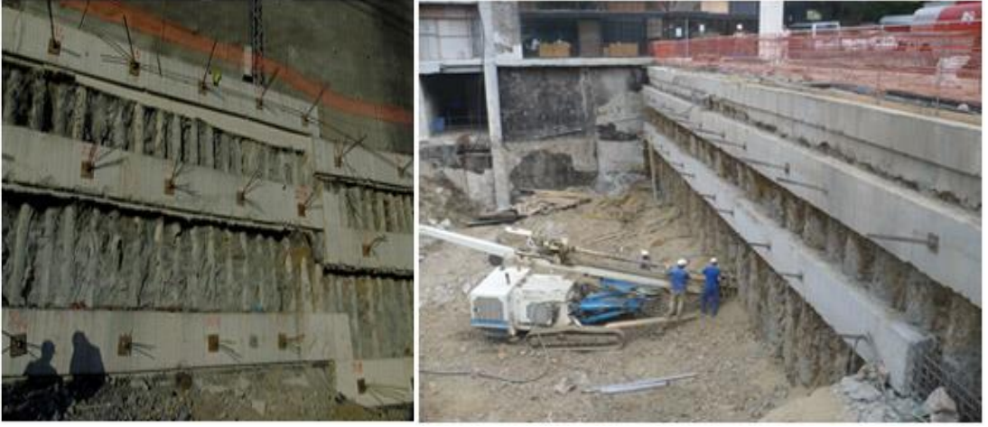
Şekil 10: İmal edilmiş ankrajlı bir iksa sistemi ve ankraj imalatı sırasında bir kare[14].
