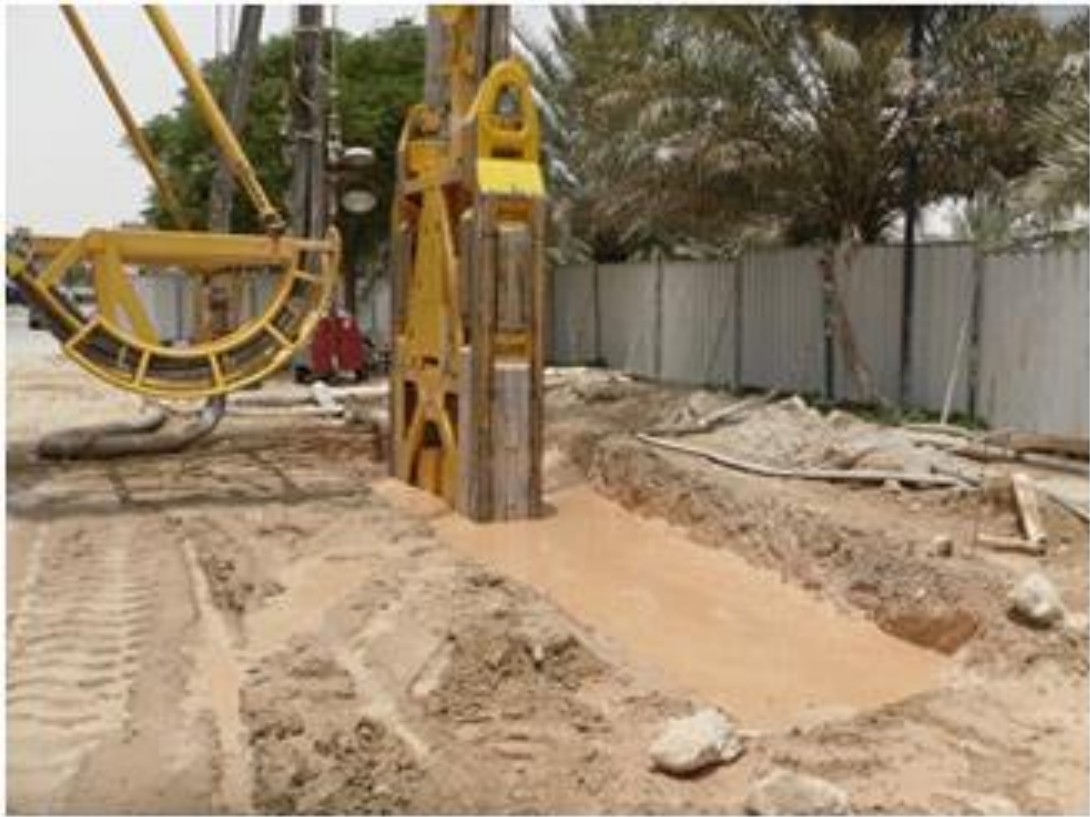
Şekil 6: Bentonit çamuru ile diyafram duvar imalatı yapımı sırasında bir fotoğraf [14].
