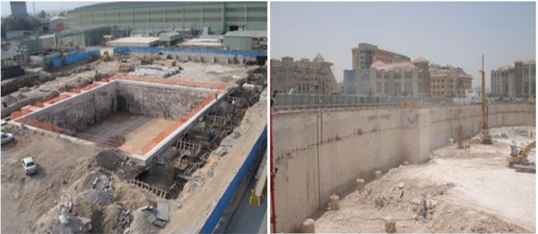
Şekil 7: Diyafram duvar imalatı bitmiş yan al yükleri karşılayan iksalı şantiyelerden fotoğraflar [14].
