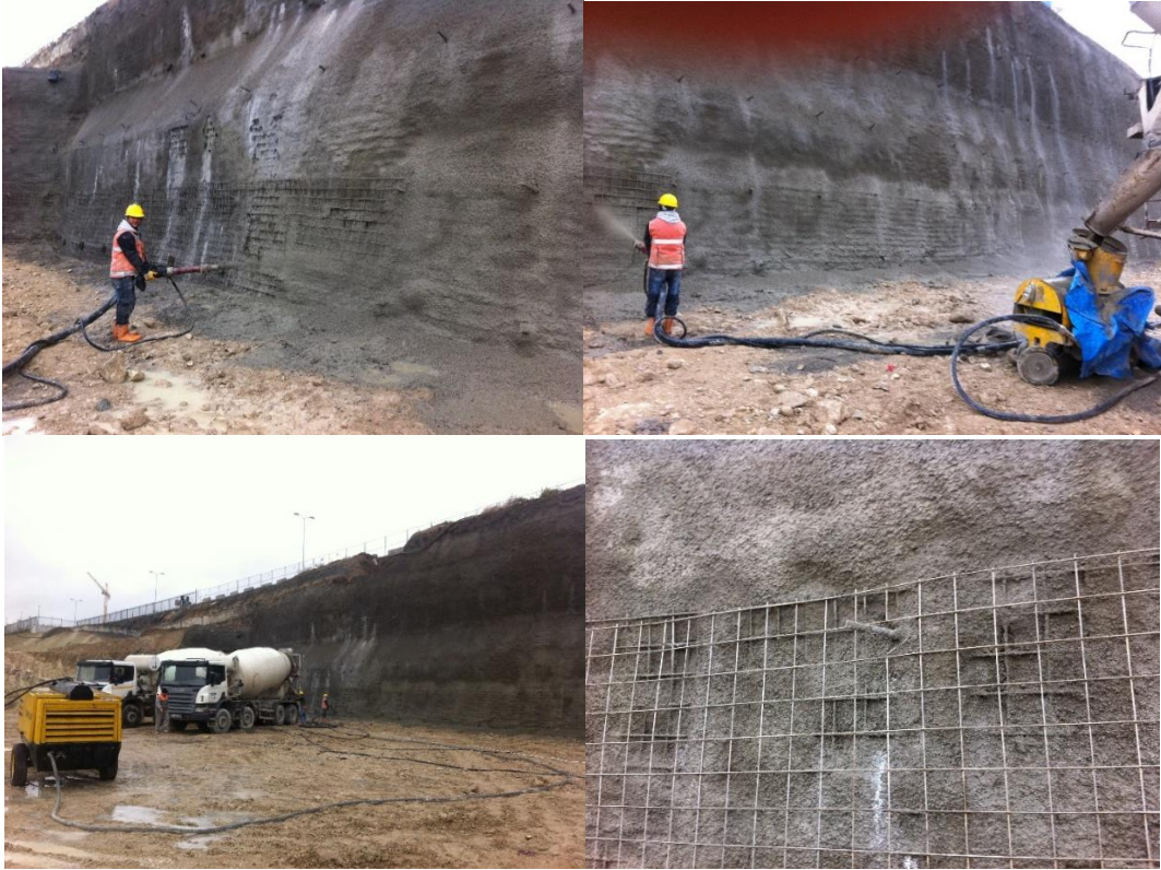
Şekil 16: Şantiyelerden püskürtme betonlu çelik hasır uygulamaları [7].
