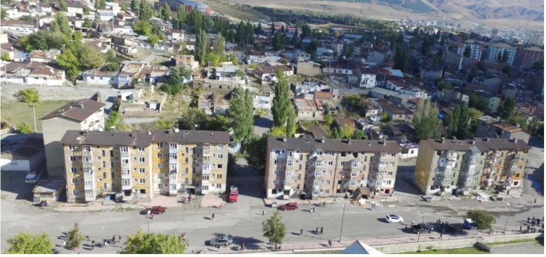
Resim 4. 18. Dağ Mahallesi Riskli Alanı Önceki Durum
