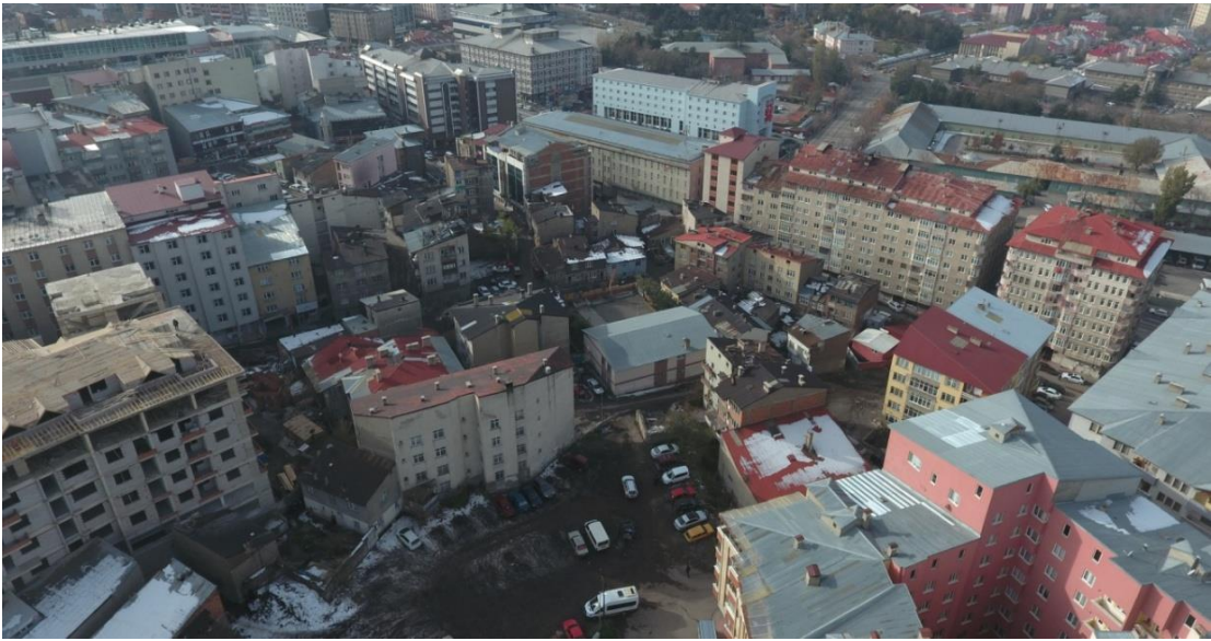
Resim 4. 21. Mumcu Mahallesinin Uygulama Öncesi Durumu
