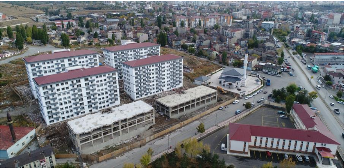
Resim 4. 19. Dağ Mahallesi Riskli Alan (8. Etap) Mevcut Durum
