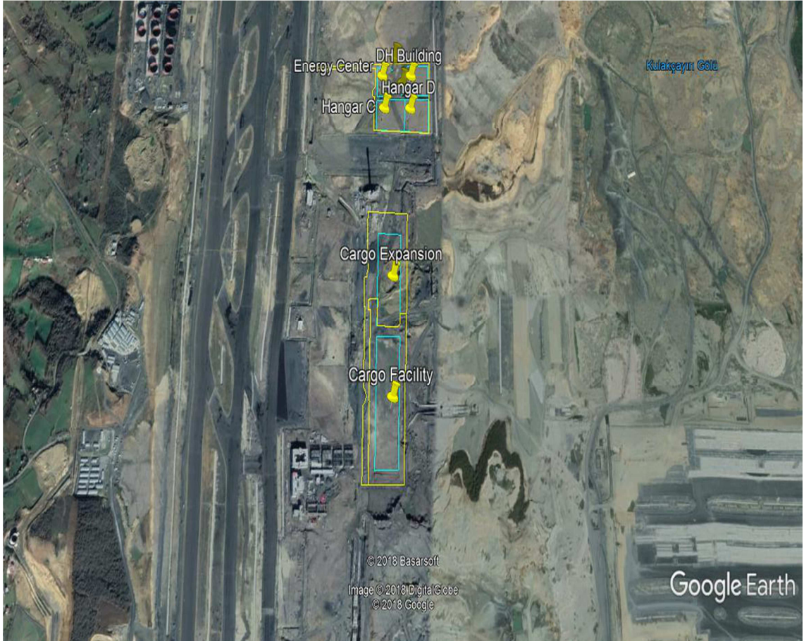
Şekil 4.1. Patlatma çalışmaları yapılan bölgenin görünümü
