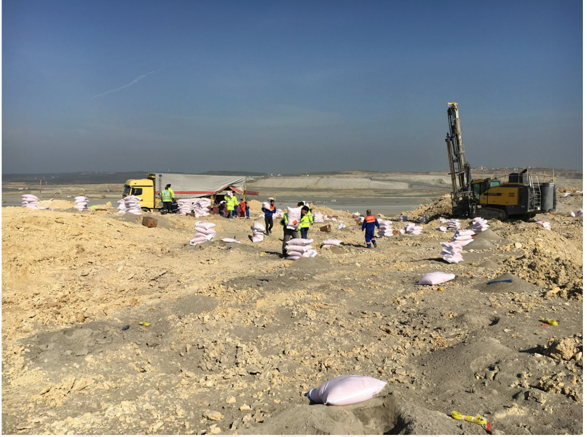
Şekil 4.9. Patlatmalı kazı hazırlık çalışmaları
