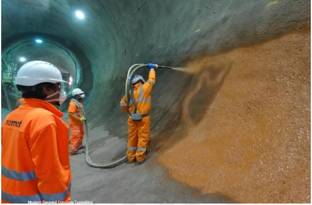
Şekil 11. Püskürtme membran uygulaması ile yalıtım yapılması (normet.com)
