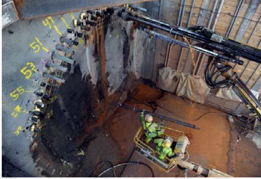
Şekil 2.17 Tynols Corner tüneline şemsiye borusu uygulaması
