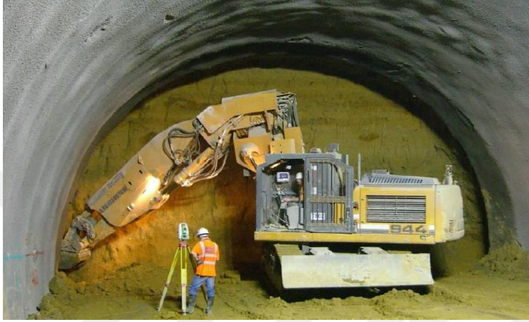
Şekil 2.15 Yeni Avusturya Tünel Açma Yöntemi
