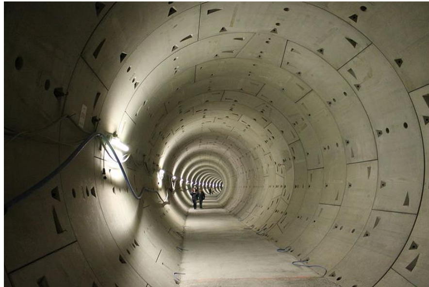
Şekil 2.29 EPBM ile tünel kaplaması (Prag Metrosu)
