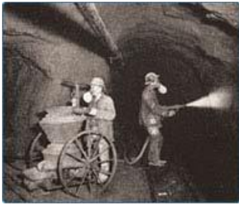
Şekil 3.3 Tabanca sistemi kullanılarak püskürtme betonun yüzeye uygulanması
