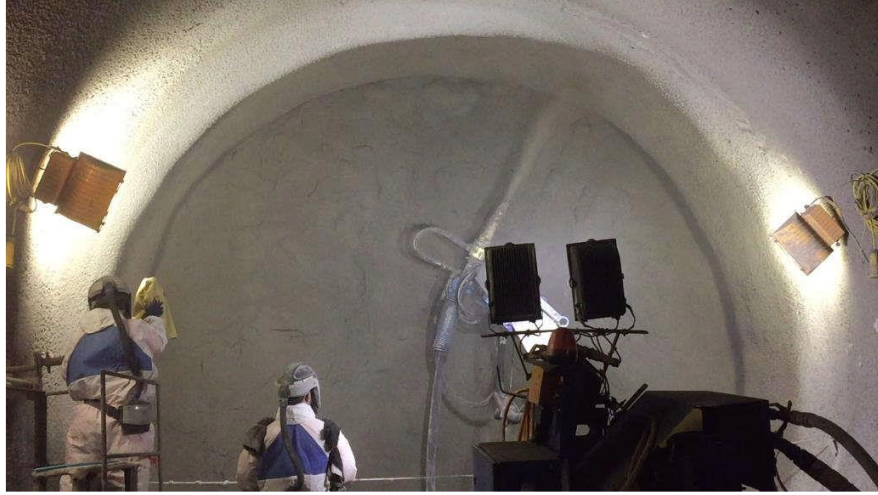
Şekil 4.15 Çelik lifli püskürtme beton uygulaması ile nihai kaplama yapılması
