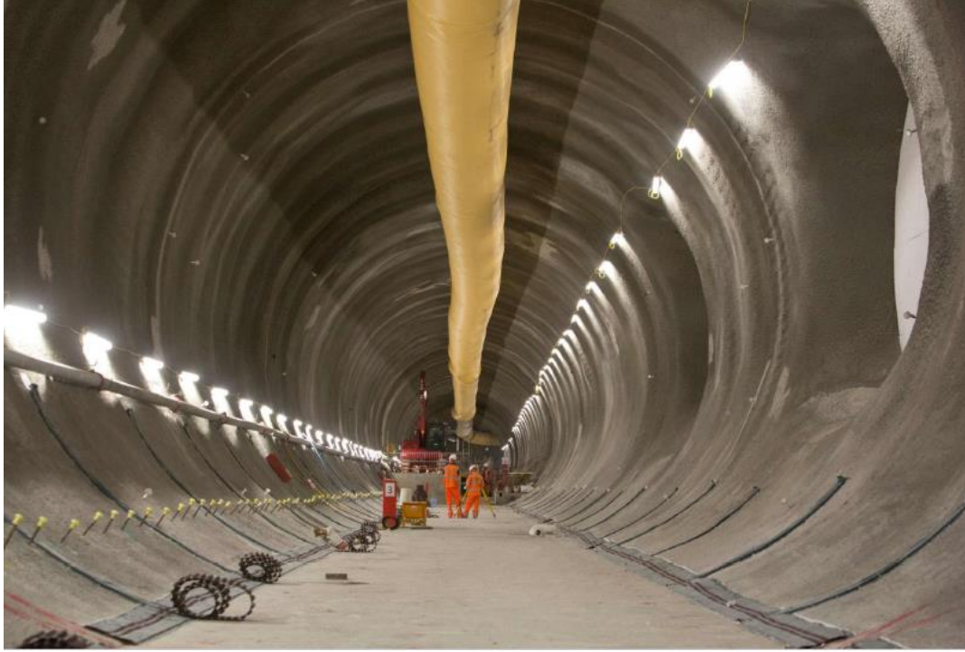
Şekil 4.3 Nihai kaplamanın püskürtme beton ile yapıldığı Londra Whitechapel platform tüneli (Crossrail)
