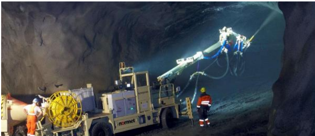
Şekil 3.5 Yaş püskürtme beton uygulaması
