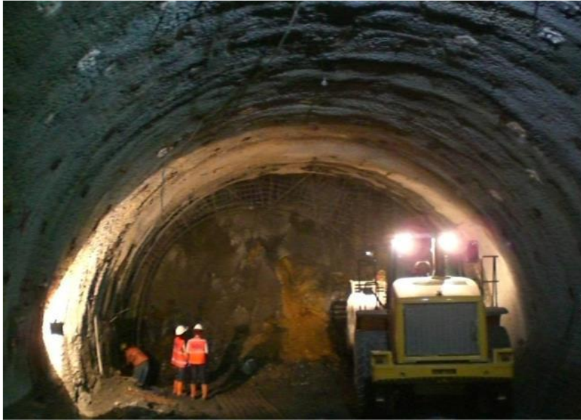
Şekil 2.19 ÜÜÇ Metro Projesi-Çarşı istasyonu P1 tüneli kazı-desteği
