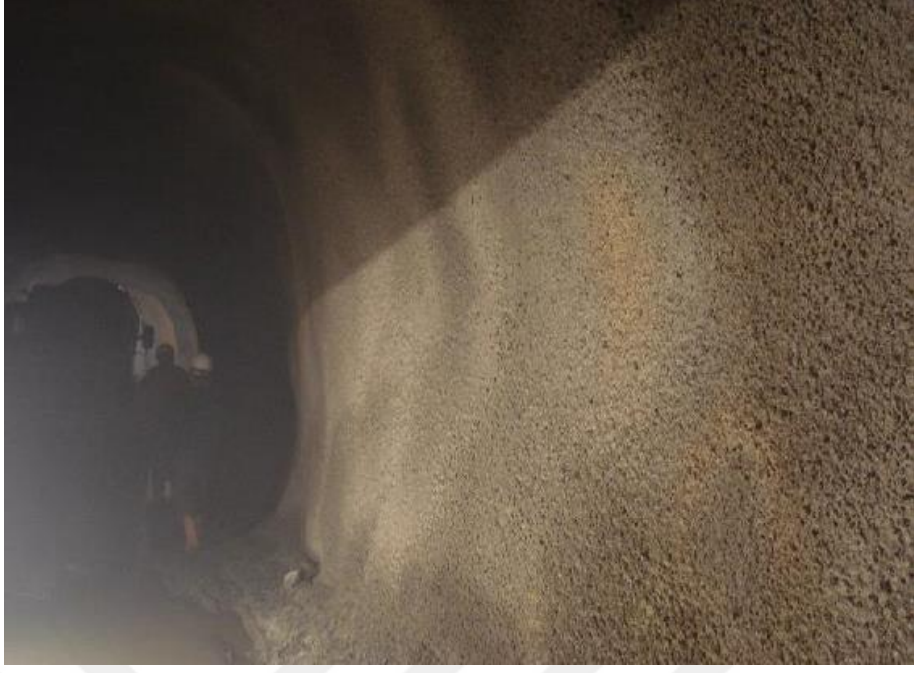
Şekil 8. Uzundere HES Tüneli'nin Çelik lifli püskürtme beton ile kaplama yapılması
