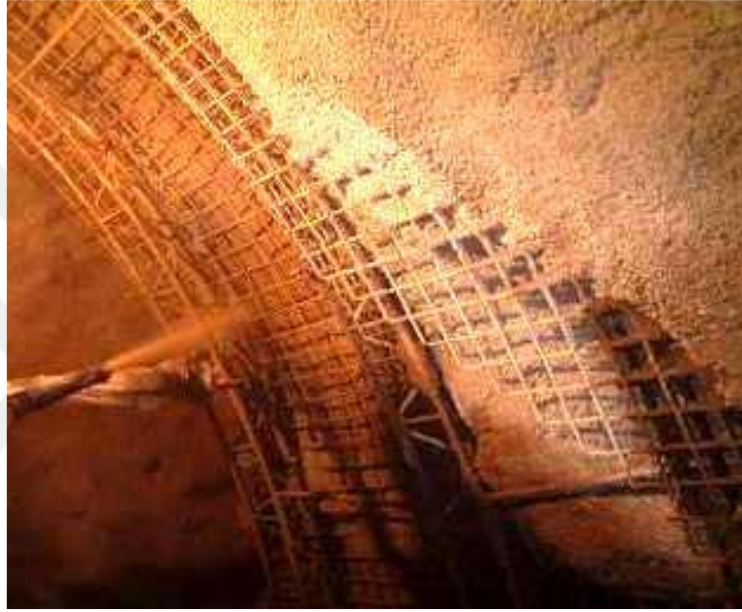
Şekil 4.14 Montajı yapılmış ikinci kaplama donatısı üzerine püskürtme beton uygulaması ile nihai kaplama yapılması (normet.com)
