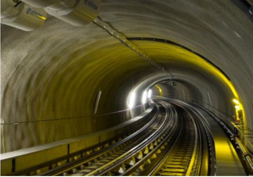
Şekil 10. Çelik lifli püskürtme beton uygulaması ile nihai kaplama yapılması (Fotoğraf: Shani Wallace, Tunnel Talk, Temmuz 2011).
