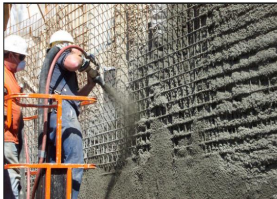
Şekil 3.3 Tabanca sistemi kullanılarak püskürtme betonun yüzeye uygulanması
