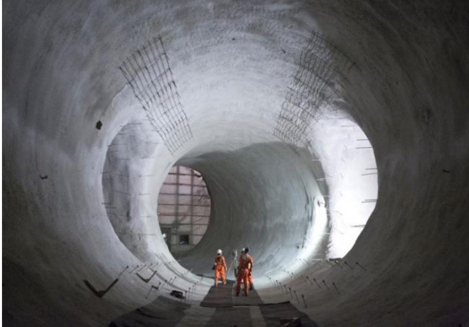
Şekil 9. Çelik lifli püskürtme beton ile kaplaması yapılan tüneller (Crossrail Projesi)
