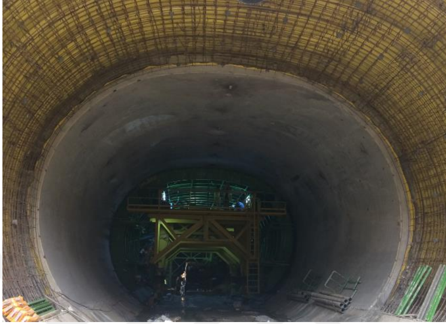
Şekil 4.1 CT Tipi Tünelin nihai kaplamasının dökme beton ile yapılması
