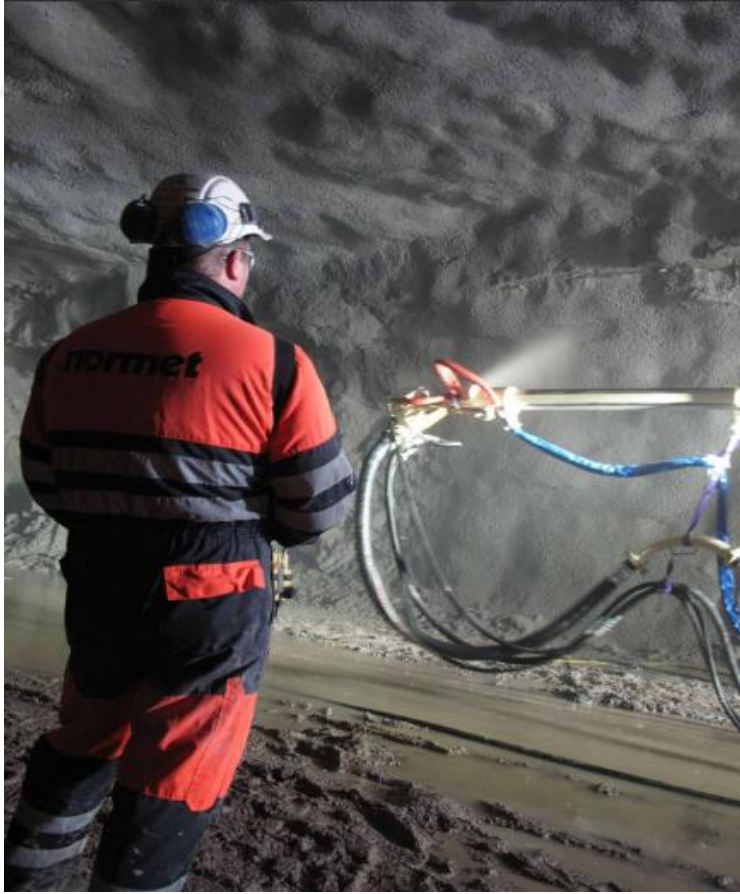
Şekil 3.4 Püskürtme beton uygulaması
