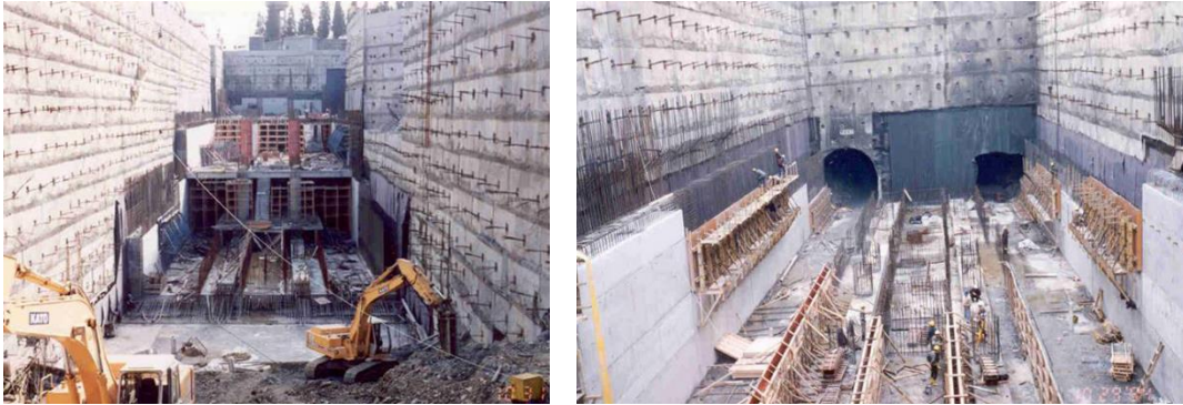
Şekil 2.30 Aç-Kapa metodu kullanılarak inşa edilen istasyon
