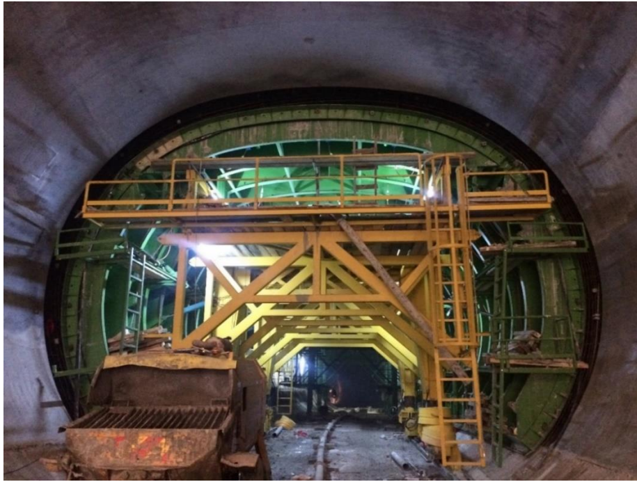
Şekil 4.2 Tünel kemerinin yürür kalıp ile nihai kaplama montajının yapılması
