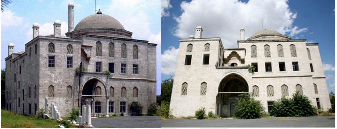
Şekil-11 Otağ-ı Hümayun Önceki Hali ve Restorasyon Sonrası
