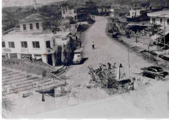
Şekil-1 1960'lı Yıllarda Esenler İlçe Merkezi Dört Yol Meydanı
