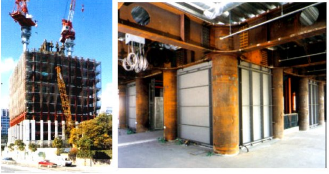
Şekil 4.1 Nippon Steel Binası Japonya [1].
