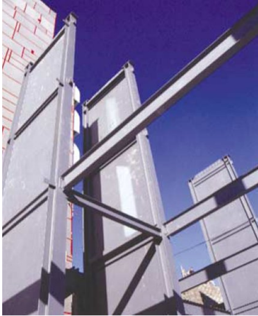
Şekil 2.1 Kanada'da çelik levha perdeli Canam Manac Genel Müdürlük Ek Binası
