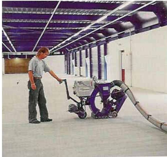
Şekil 3.6- Endüstriyel Süpürge İle Yüzeyin Temizlenmesi
