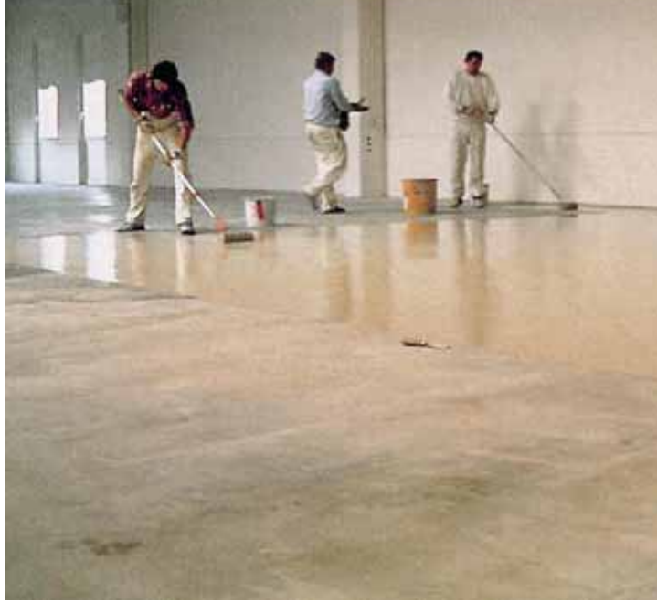
Şekil 3.8- Epoksi Uygulaması Öncesi Astar Tabakasının Sürülmesi
