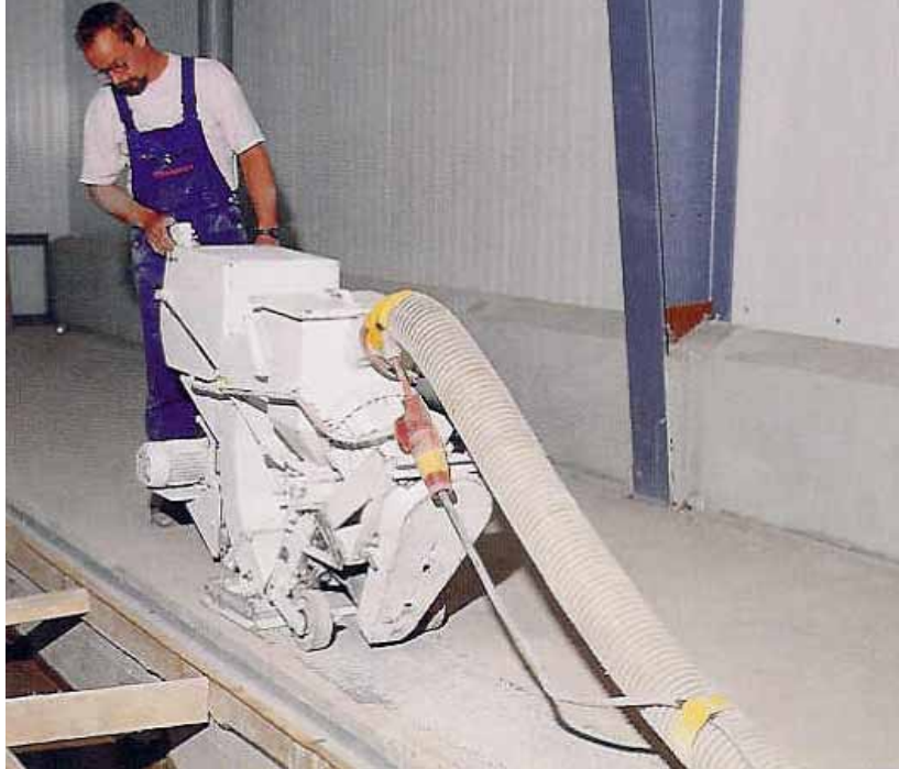
Şekil 3.7- Blast – Track Makinesi İle Zemin Hazırlığı Yapılması
