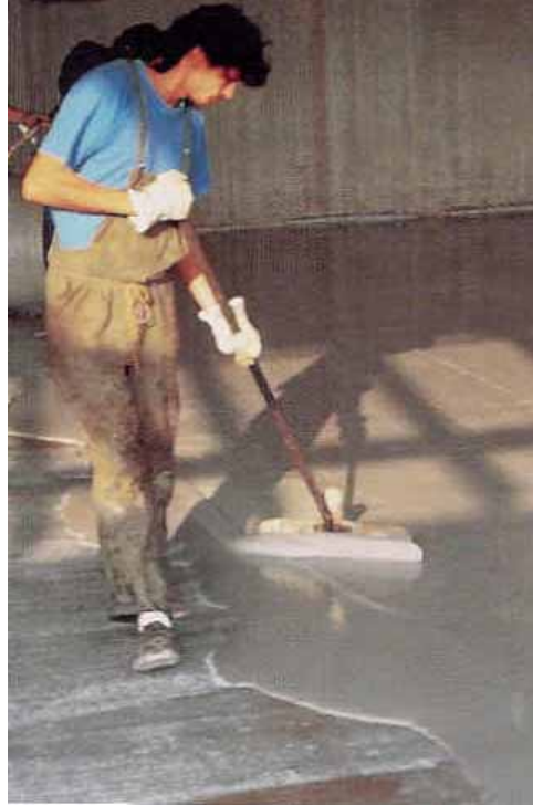
Şekil 3.9- Mala İle Epoksi Uygulaması Yapılması
