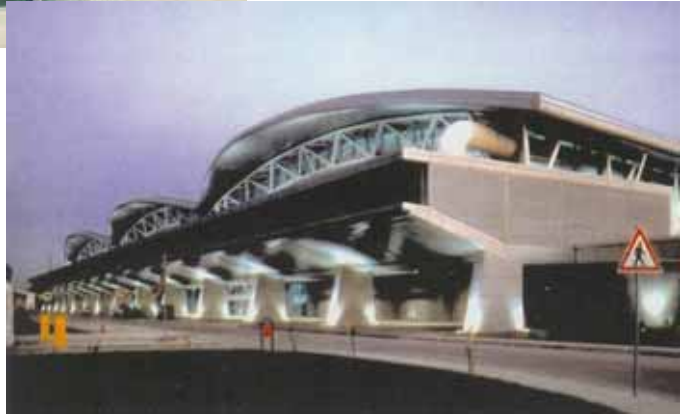
Şekil 3.107 Yapıya otoparktan bakış [26,31,32]
