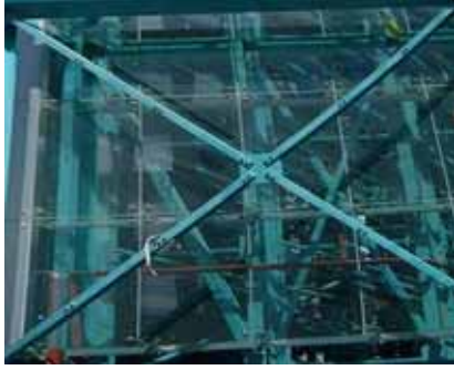
Şekil 3.70 Merkezi çaprazlı çelik perde görünüşü [28,29]
