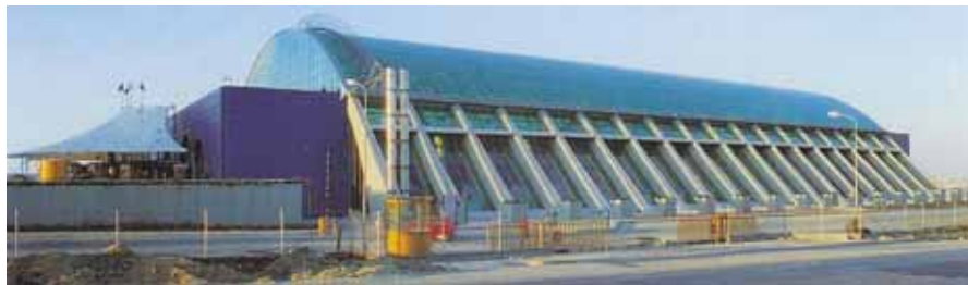
Şekil 3.149 Yapının dıştan cam çatısının görünüşü [26,27,30]
