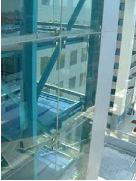
Şekil 3.81 Bina Giydirme Detay Görünüşü (Spider elemanlarının camı tutuşu) [28,29]
