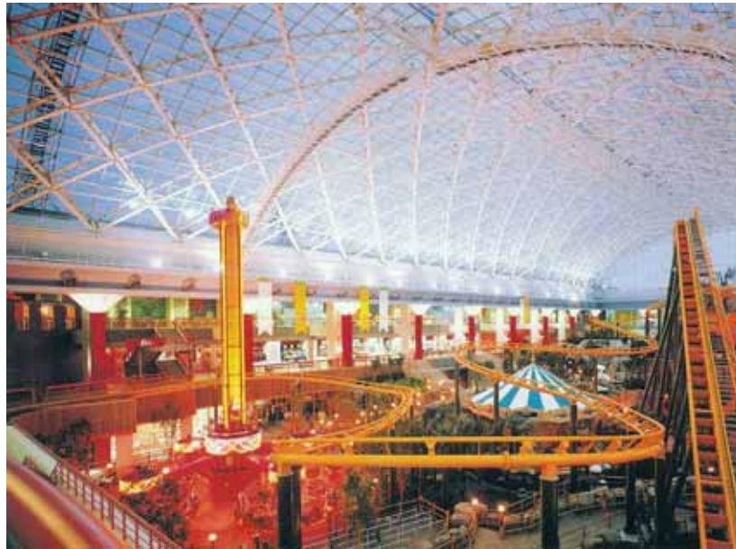
Şekil 3.151 Yapının ana mekânının genel görünüşü (Eğlence ekipmanlarının görünüşü) [26,27,30]
