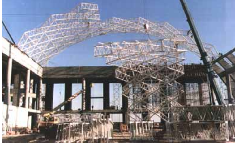
Şekil 3.142 Birleşmiş segmanların vinçler vasıtası ile montajı [26,27,30]
