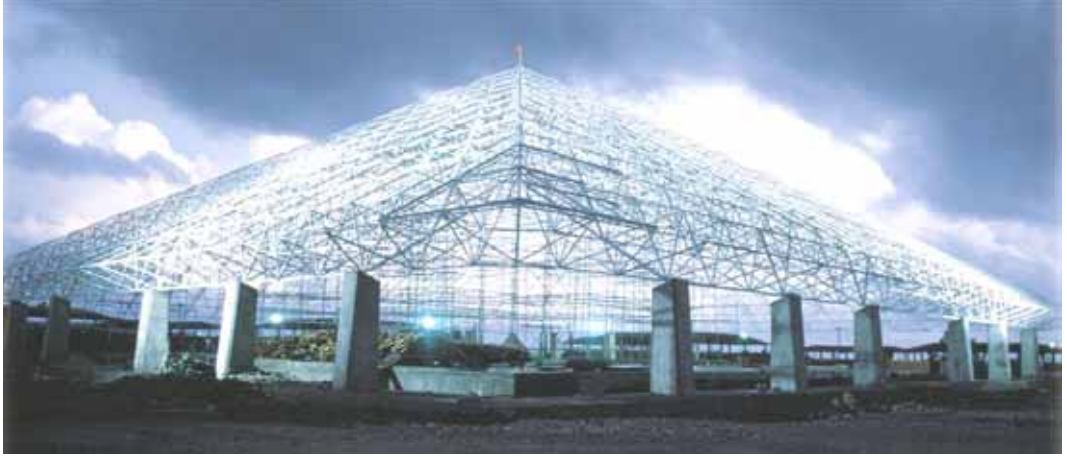
Şekil 3.111 Yapının inşaat halindeki görünüşü [28,29,30]
