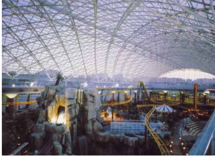
Şekil 3.150 Yapının ana mekânının genel görünüşü (Eğlence ekipmanlarının görünüşü) [26,27,30]
