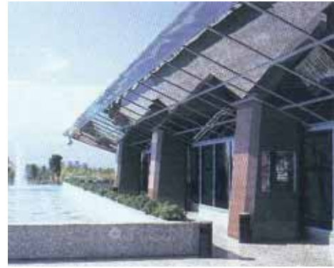
Şekil 3.113 Yapının giydirme cephe sisteminin görünüşü [28,29,30]
