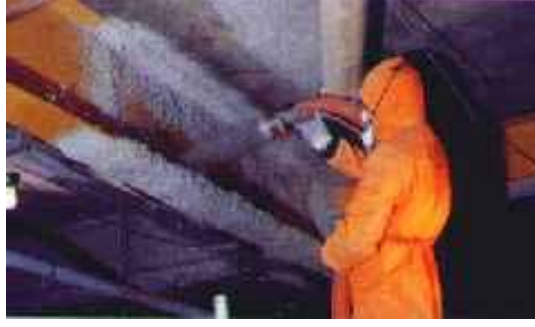
Şekil 2.8 Püskürtme sistemlerin çelik kirişe uygulanması {17}
