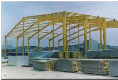
Şekil 2.35 Çerçevelerin stabil bir şekilde birbirine bağlanması.
