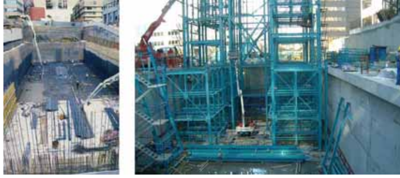
Şekil 3.68 Temel İnşaatı Görünüşü [28,29]
