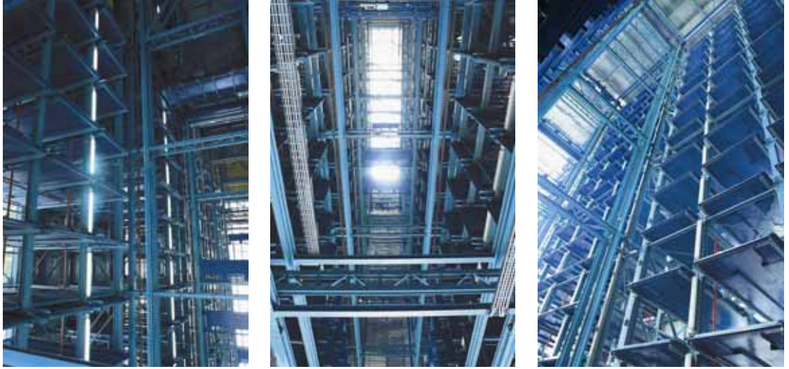
Şekil 3.76 Bina içi-Katlardaki araba rafları [28,29]
