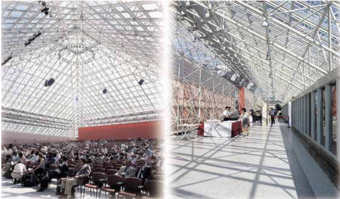
Şekil 3.114 Yapının giydirme cephe sisteminin içerden görünüşü [28,29,30]
