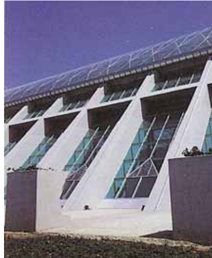
Şekil 3.138 Çatıyı destekleyen kolonların görünüşü [26,27,30]
