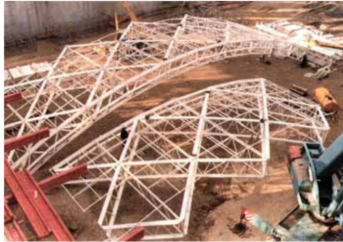
Şekil 3.141 Segmanların inşaat alanında montajı [26,27,30]
