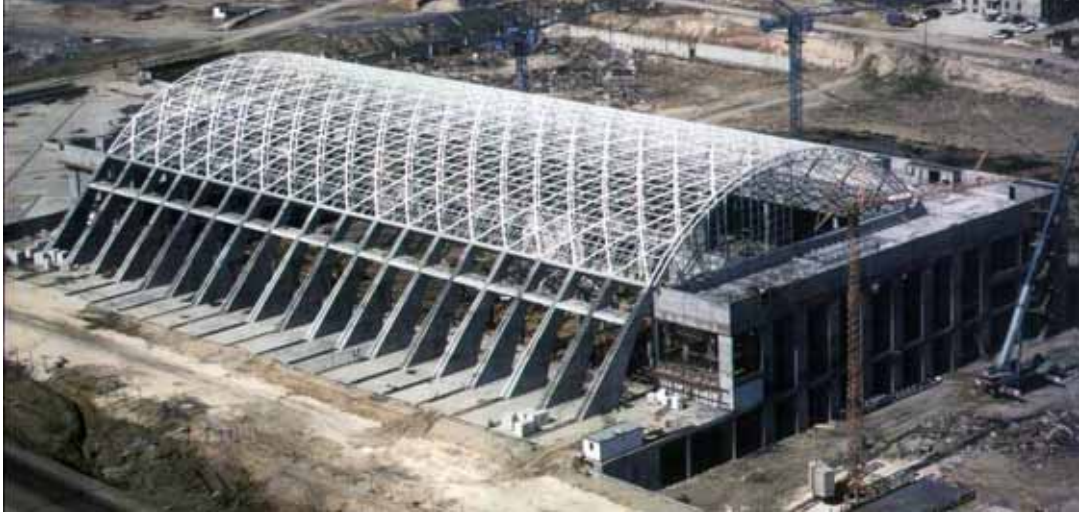
Şekil 3.144 Yapının inşaat hali [26,27,30]
