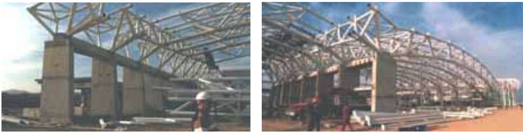
Şekil 3.100 Çelik çerçeve ayaklarının betonarme sistemle birleşmesi [26,31,32]
