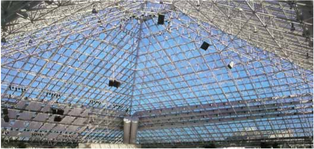
Şekil 3.112 Yapının taşıyıcı strüktürünün yapı içinden görünüşü [28,29,30]
