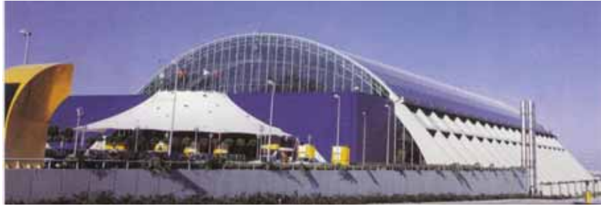
Şekil 3.153 Yapının giriş çadırının görünüşü [26,27,30]
