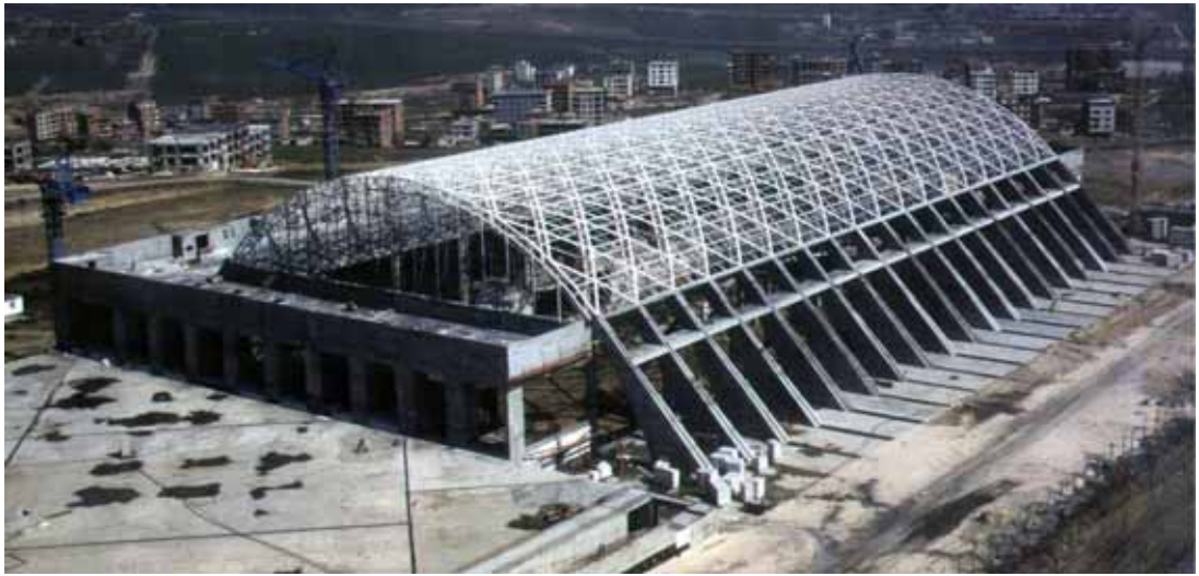
Şekil 3.143 Yapının inşaat hali [26,27,30]
