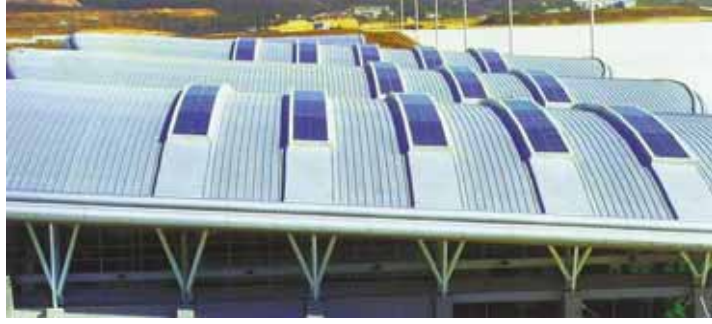
Şekil 3.94 Dış hatlar terminali çatı görünüşü [26,31,32]
