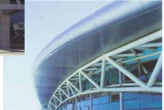
Şekil 3.98 Çelik Saçak Görünüşü (solda), Çaprazların Görünüşü (sağda) [26,31,32]
