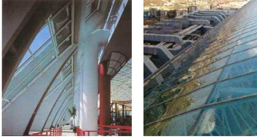
Şekil 3.148 Yapının içten (sol) ve dıştan (sağ) cam çatının görünüşleri [26,27,30]
