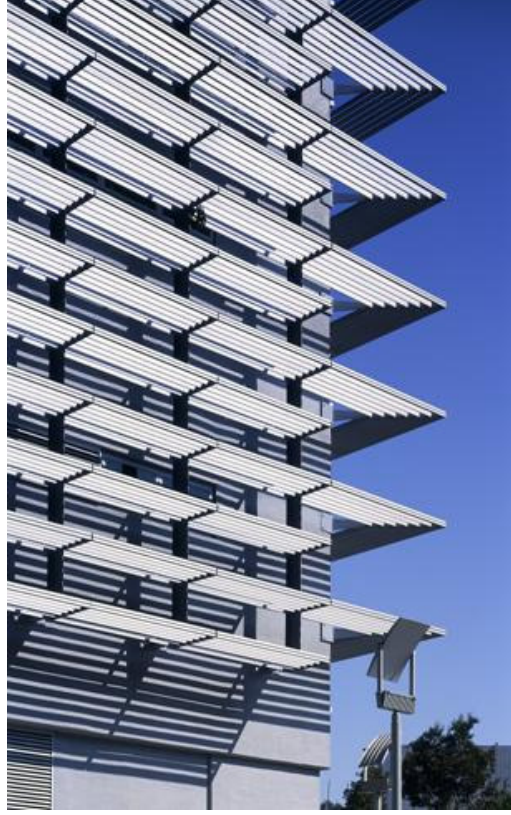
Şekil.2.50. Fotovoltaik cephe örneği [73]
