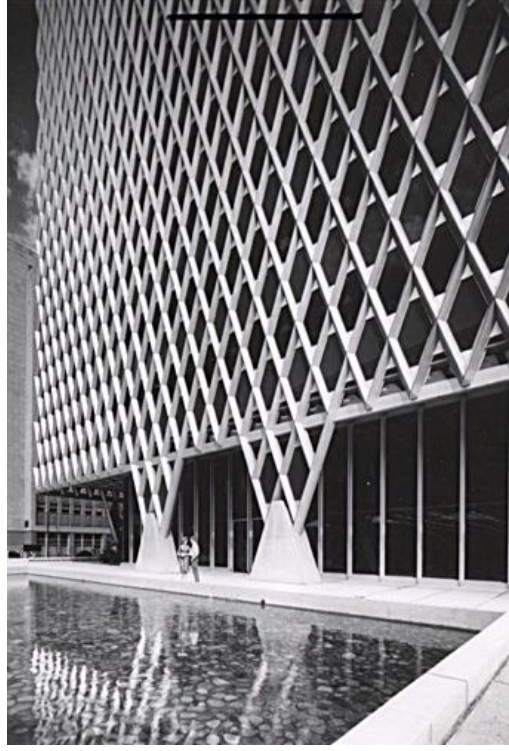
Şekil.2.26. IBM Office Building vevv kafes tüp, Pittsburgh [11]
