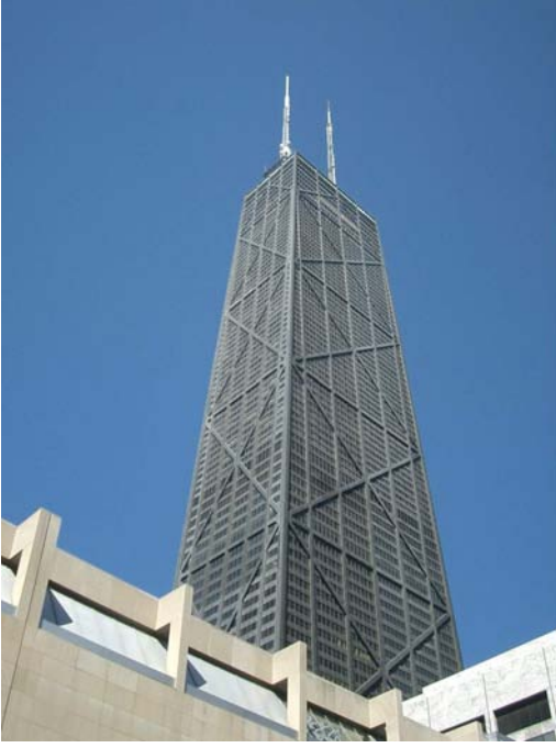
Şekil.2.24. John Hancock Center kolon-diyagonal kafesli sistem, Chicago [11]
