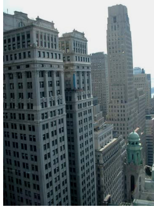
Şekil 1.14. Equitable Life Insurance Company Binası, New York [24]
