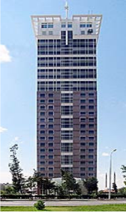
Şekil 1.33. Tekfen Tower, İstanbul [57]
