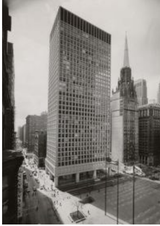
Şekil.2.21. Brunswick Binası t b ler sistem, Chicago [65]
