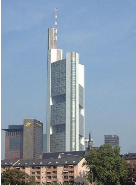
Şekil.2.41. Commerzbank Merkez Binası, Frankfurt [64]
