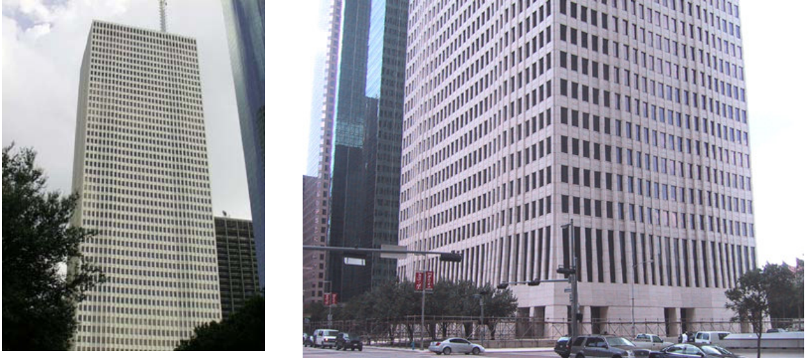
Şekil.2.28. One Shell Plaza tüp içinde tüp, Houston [11]
