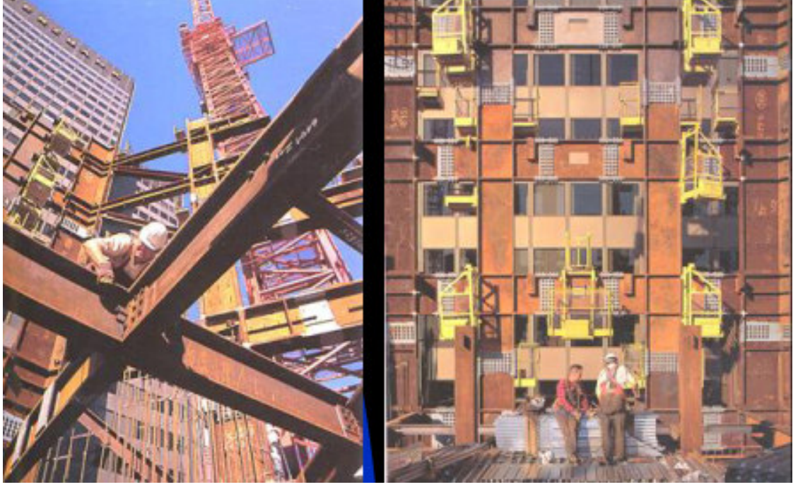
Şekil 3.7. İnşaat sırasında çekilmiş çelik strüktür fotoğrafı [121]
