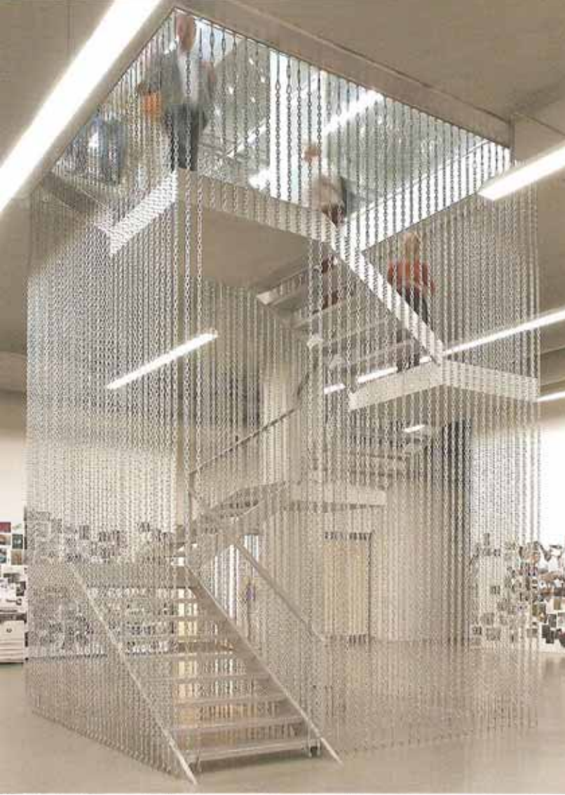
Resim 128 Çelik merdiven alt bölümde zincirlerle, üst bölümde ise camla çevrelenmiştir.
