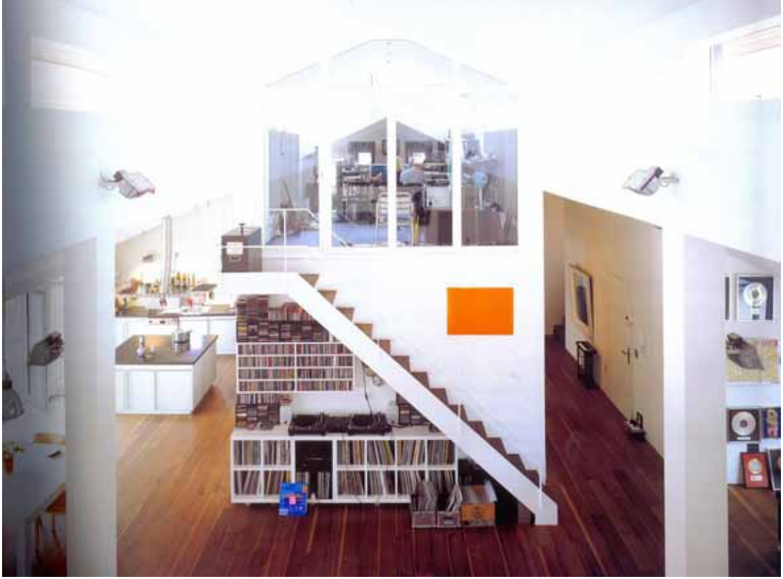
Resim 82 Berlin/Almanya. Uygun yükseklikte asma kat uygulanmış, çalışma alanı etrafı camla kapatılarak asma kat üzerine yerleştirilmiş. Cam uygulaması sayesinde çalışma alanı tepe pencerelerinden giren gün ışığından maksimum düzeyde faydalanabiliyor. Tepe pencerelerinin altına yerleştirilmiş olan projektörler ise tavana yöneltilerek çalışma alanının dolaylı şekilde aydınlatılmasını sağlıyor.
