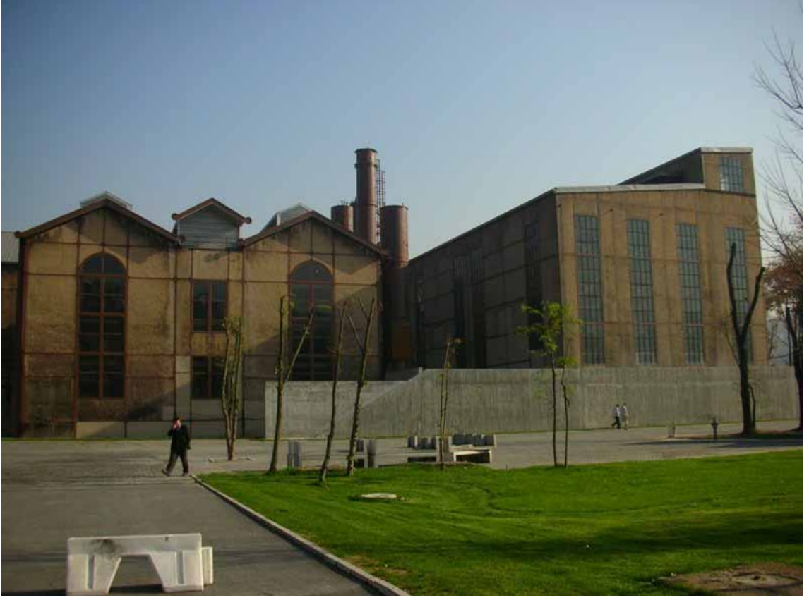
Fotoğraf 1 Silaharağa Elektrik Santrali, 2007
