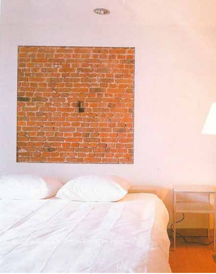
Resim 70 Antwerp/Belçika. 19.yy depo binası; duvar sıvayla kapatılıp boyanmış, asma tavan uygulamasıyla bina elemanları gizlenmiş, ama yatağın arkasında küçük bir alan çıplak tuğla olarak bırakılmış.
