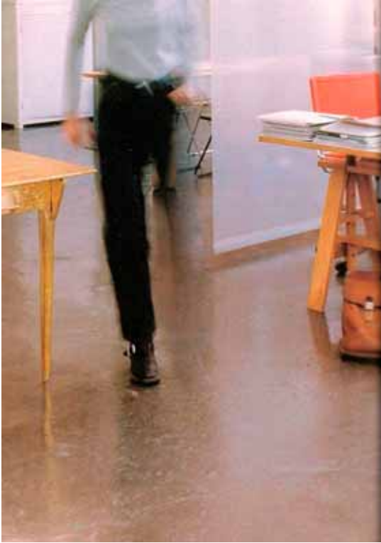
Resim 18 20.yüzyıl fabrika alanı, Milano/İtalya. Mevcut beton zemin üzerine cila uygulanarak kullanılmış.
