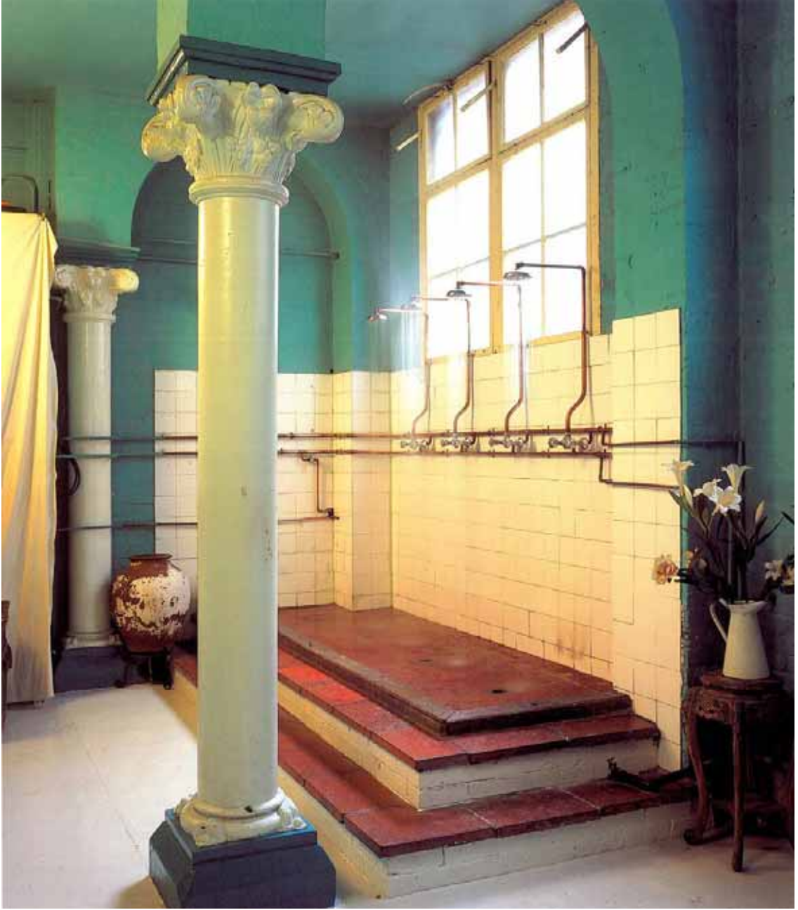
Resim 15 Londra/İngiltere. Doğal loftta müdahale edilmemiş bir duş alanı, taş zemin, duvarda eski fayanslar, bakır tesisat boruları
