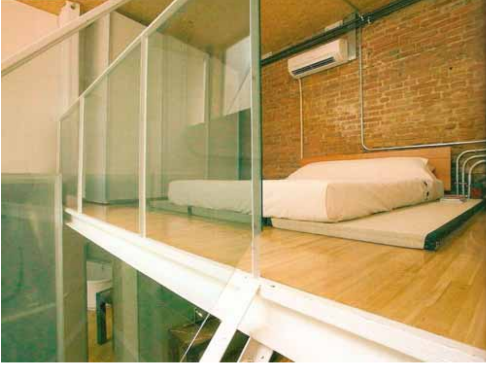
Resim 38 Madrid/İspanya. Asma katta yer alan yatak odası pleksiglas korkulukla çevrilerek güvenlik sağlanmış.
