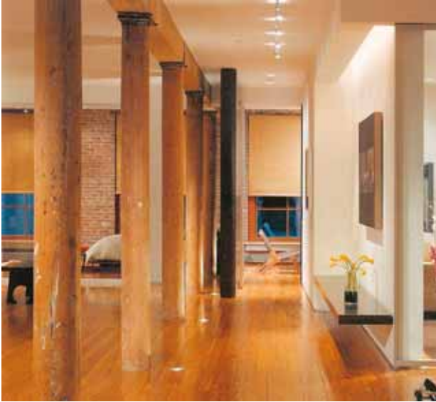
Resim 22 NewYork/ABD. Mekanın bir bölümündeki ahşap kiriş ve dikmeler doğal halleriyle bırakılmışlar.
