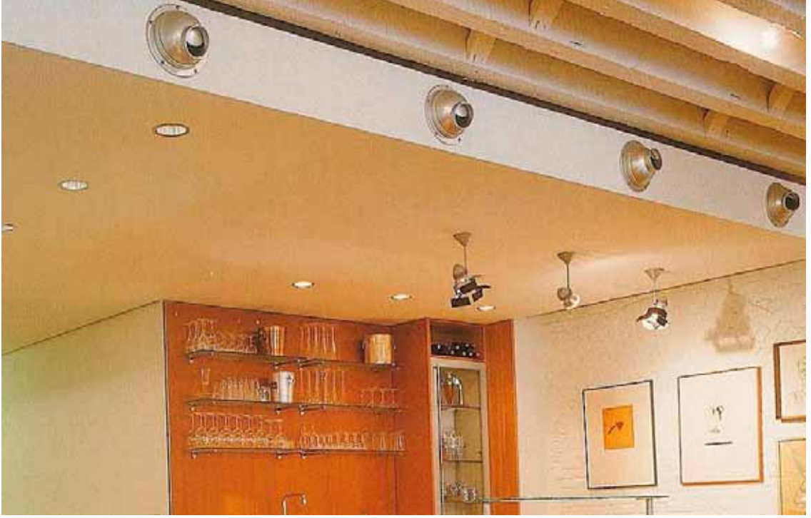
Resim 23 New York/ABD. Ahşap kırışlerin görüldüğü tavanın bir bölümüne asma tavan uygulaması yapılmış, gömme ve sarkıt aydınlatma öğeleri eklenmiş, elektrik kabloları asma tavanın içine gizlenmiş.
