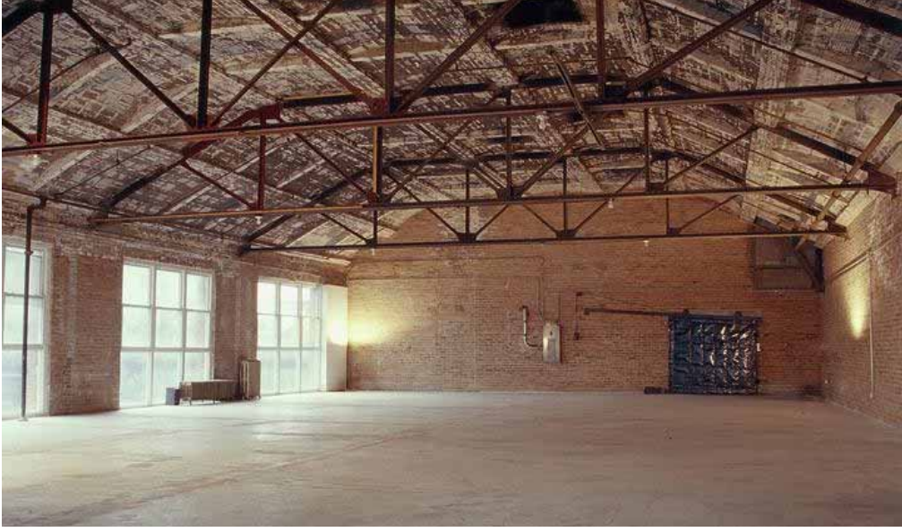
Resim 12 Dođal loft örneđi, tonoz çatıyı destekleyen elik kafes kiriř, aıkta bırakılmıř tesisat elemanları, ıplak tuđla duvarlar, beton zemin ve geniř pencereler.
