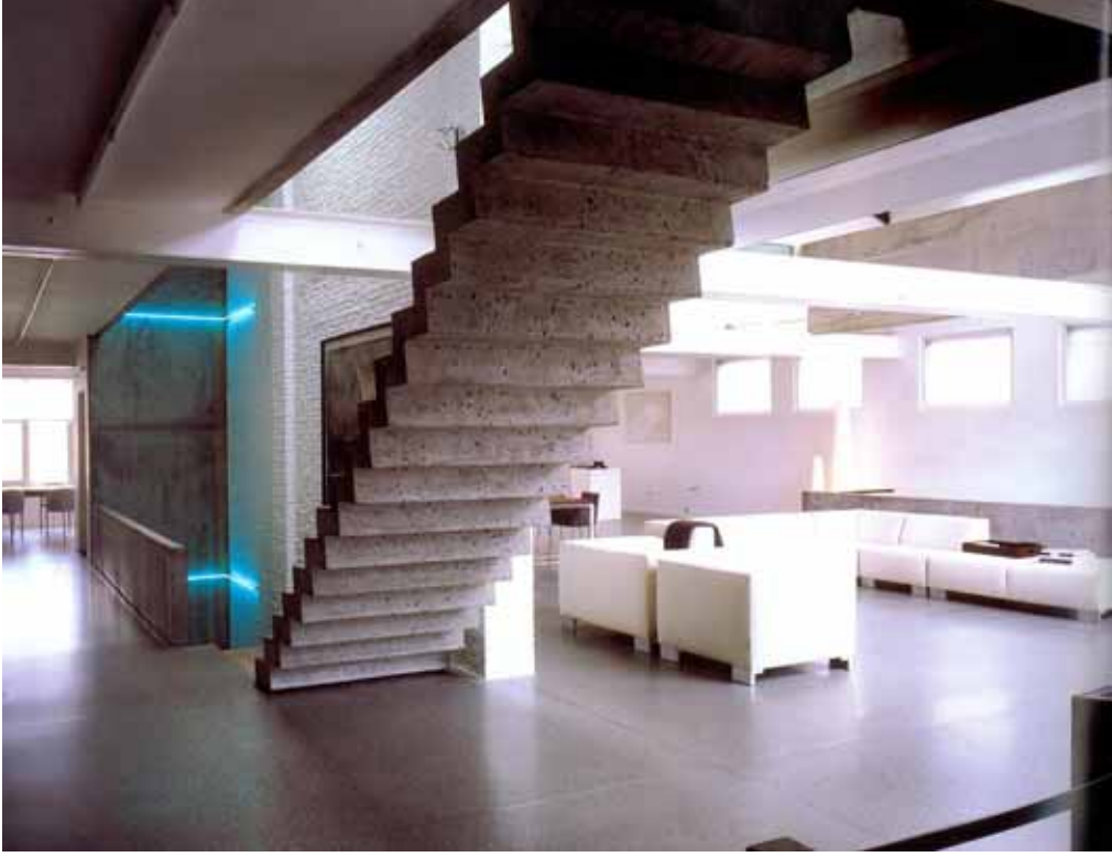
Resim 93 Antwerp/Belçika. Çelik kirişler beyaza boyanmış, merdivenin yanındaki duvar tuğlalar açıkta kalacak şekilde beyaza boyanmış, resmin sağ tarafında görünen duvar ise önce sıvayla kapatılarak tuğlalar gizlenmiş ardından beyaza boyanmıştır. Zeminde ise vinil döşeme kaplaması uygulanmıştır.
