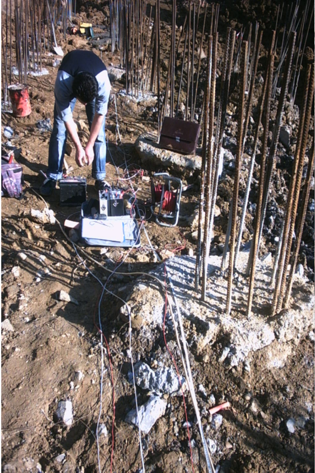
EK F2: BEYKOZ ÇUKURÇAYIR 60.YIL İ.Ö.O. SAHASI İLE İLGİLİ DES ÇALIŞMALARI
