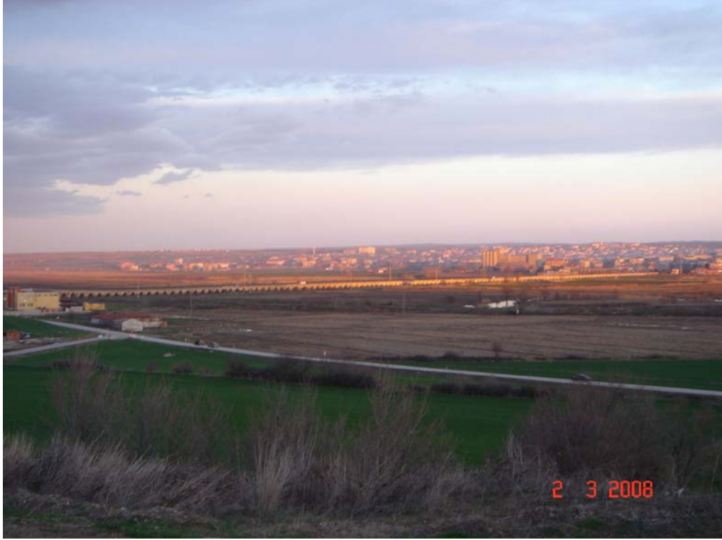
Foto 2. Köprü Genel Görünümü G – B Yönünden.
