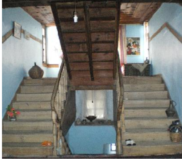
Resim-5.2.15 Asmazlar Konağı Merdiven Görünümü.Üç kollu merdiven sistemi görülmektedir. Orta kattan üst kata çıkış iki koldan yapılmakta ve üst kattan alt kata iniş tek koldan yapılmaktadır .(S.Gülçin Bozkurt,2009)
