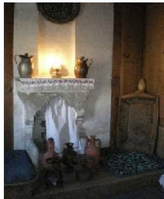
Resim-5.2.5 Sipahioğlu Konağı Ocak Örnekleri. Baş odada bulunan ocak oldukça özenli olup,çiçekli taş ocak şeklinde yapılmıştır.Ancak gelin odaları ve günlük odalarda ocaklar, tek sıra oymalı , çift sıra oymalı veya kireç sıvalı taş ocak şeklinde yapılmıştır. (S.Gülçin Bozkurt,2009)
