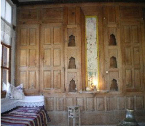
Resim-5.2.7 Sipahioğlu Konağı Dolapları.Dolaplarda sade bir işçilik göze çarpmaktadır.Ancak süslemenin ihmal edilmediği de görülmektedir. Dolap yüzlerinde üç sıra oyma bulunmaktadır.Dolap arası çiçeklikler kalem işi süslemelidir.Yüklük kısmına yatak,yorgan gibi eşyalar konulmakla birlikte gusülhane olarak da kullanılmaktadır.Dolaplara İse; giysiler ve günlük kullanılan eşyalar konulmaktadır. (S.Gülçin Bozkurt,2009)
