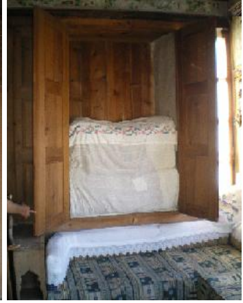
Resim-5.2.7 Sipahioğlu Konağı Dolapları.Dolaplarda sade bir işçilik göze çarpmaktadır.Ancak süslemenin ihmal edilmediği de görülmektedir. Dolap yüzlerinde üç sıra oyma bulunmaktadır.Dolap arası çiçeklikler kalem işi süslemelidir.Yüklük kısmına yatak,yorgan gibi eşyalar konulmakla birlikte gusülhane olarak da kullanılmaktadır.Dolaplara İse; giysiler ve günlük kullanılan eşyalar konulmaktadır. (S.Gülçin Bozkurt,2009)
