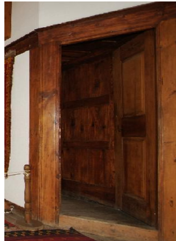
Resim-5.2.19 Kaymakamlar Konağı Baş Odası. Üst kat oda girişleri pahlı köşelerden yapılmaktadır. Oda döşemesi ahşap olup, seki altı ve seki üstü kot farklılığının olmadığı görülmektedir. (S.Gülçin Bozkurt, 2009)
