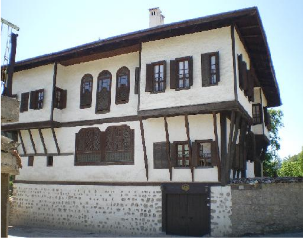
Resim-5.2.26 Gökçüoğlu Konağı Cephe Görünümü (S.Gülçin Bozkurt,2009)
