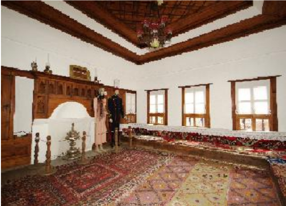
Resim-5.2.25 Kaymakamlar Konağı Sedir ve Tavan Görünümü.Baş oda tavanı tekne tavan şeklinde yapılmış olup,özenli bir işçilik kullanılmıştır.Eyvvan tavanları daha sade olup,geometrik desenler göze çarpmaktadır.Baş oda sedirleri odanın iki yanında yer almaktadır.Malzeme olarak döşemeyle uyumlu ahşap kullanılmıştır. (S.Gülçin Bozkurt,2009)
