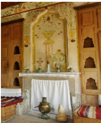
Resim-5.2.5 Sipahioğlu Konağı Ocak Örnekleri. Baş odada bulunan ocak oldukça özenli olup,çiçekli taş ocak şeklinde yapılmıştır.Ancak gelin odaları ve günlük odalarda ocaklar, tek sıra oymalı , çift sıra oymalı veya kireç sıvalı taş ocak şeklinde yapılmıştır. (S.Gülçin Bozkurt,2009)
