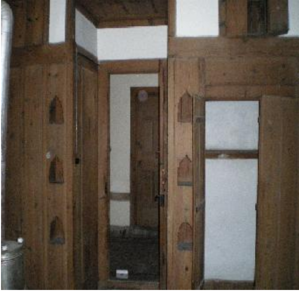
Resim-5.2.40 Mümtazlar Konağı Dolap ve Yüklük Görünümü. Dolap ve yüklüklerde oldukça basit bir işçiliğin kullanıldığı görülmektedir.Yüklük aynı zamanda gusülhane olarak kullanılmaktadır.Dolap yüzlerinde üç sıra oymalar yer almaktadır. (S.Gülçin Bozkurt,2009)
