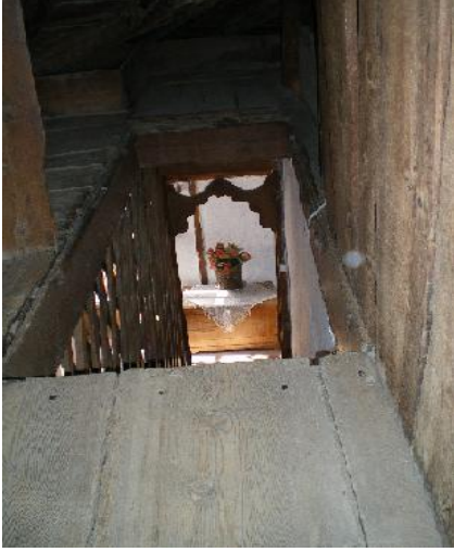
Resim-5.2.6 Sipahioğlu Konağı Merdivenleri. Tek kollu olup,korkuluk olarak ahşap çıtalar çapraz bir şekilde çakılmıştır.Merdiven girişlerinde süslü kemerler görülmektedir. (S.Gülçin Bozkurt,2009)
