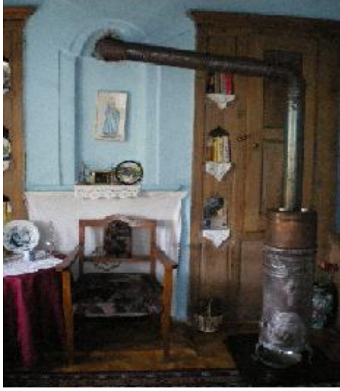
Resim-5.2.14 Asmazlar Konağı Ocak Görünümü.Ocaklar çiçekli taş ocak şeklinde yapılmıştır.Ancak 19.yy ın ikinci yarısında ocaklar işlevini yitirmeye başladığı için ocak davlumbazının yerine soba bacası deliği açılarak soba kullanılmaya başlanmıştır.(S.Gülçin Bozkurt,2009)
