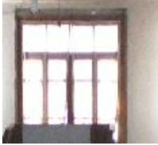
Resim-5.2.12 Asmazlar Konağı Pencere Görünümü. Evin çıkma yapan kısımlarında ve üst katta pencereler daha geniş tutulmuş olup, alt katta daha dar yapılmışlardır.(S.Gülçin Bozkurt,2009)
