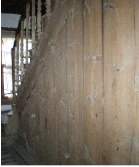
Resim-5.2.39 Mümtazlar Konağı Merdiven Görünümü. Tek kollu merdiven sistemi uygulanmıştır.Katlar arasında, korkuluk olarak daraba yapılmıştır. (S.Gülçin Bozkurt,2009)
