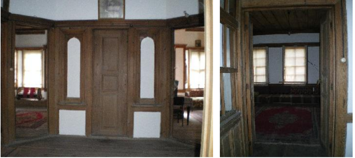
Resim-5.2.35 Mümtazlar Konağı Oda Girişi ve Döşemesi.Üst kat oda girişleri pahlı köşelerden yapılmakta olup,alt kat odaları doğrudan girişlidir.Odalarda seki altı ve seki üstü kot farklılığı görülmemektedir. (S.Gülçin Bozkurt,2009)
