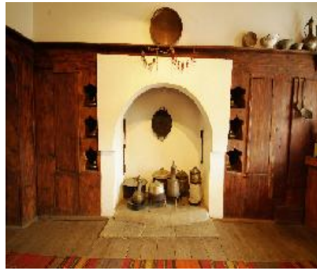
Resim-5.2.22 Kaymakamlar Konağı Ocak Görünümü.Baş odasının ocağı tek sıra oymalı ocaklardandır.Aşevi mutfağının ocağı ise;oldukça büyük olup,kireç sıvalı taş ocak şeklinde yapılmıştır . (S.Gülçin Bozkurt,2009)
