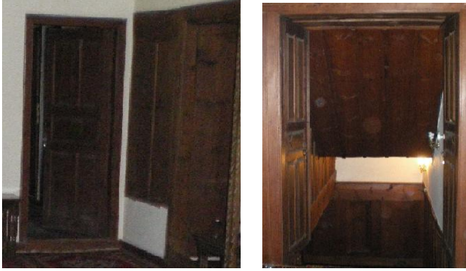
Resim-5.2.29 Gökçüoğlu Konağı Oda Kapıları Görünümü. Oda kapıları tek kanatlı olup,üst katta merdiven başı kapısı çift kanatlı olarak yapılmıştır. (S.Gülçin Bozkurt,2009)
