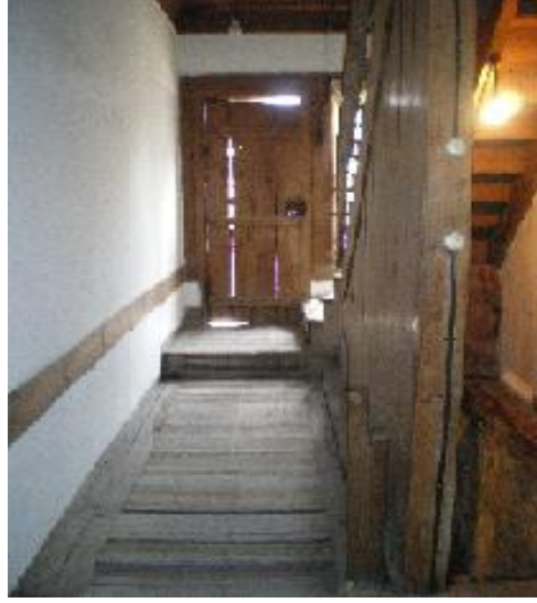
Resim-5.2.39 Mümtazlar Konağı Merdiven Görünümü. Tek kollu merdiven sistemi uygulanmıştır.Katlar arasında, korkuluk olarak daraba yapılmıştır. (S.Gülçin Bozkurt,2009)
