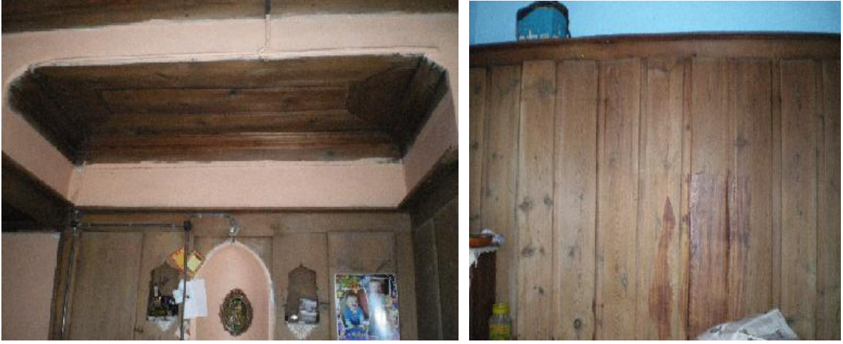
Resim-5.2.16 Asmazlar Konağı Dolap Görünümü. Resim-5.2.12 de görüldüğü gibi dolaplar oldukça sade olup dolap yüzlerinde üç sıra oymalar yer almaktadır. Oda girişinde yer alan dolaplarda aynı sadeliktir. Mutfak dolaplarında ise işlevsellik ön planda tutulmuş süslemeden kaçınılmıştır. (S.Gülçin Bozkurt,2009)
