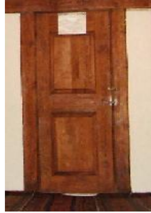
Resim-5.2.21 Kaymakamlar Konağı Kapı Görünümü.Kapılar tek kanatlı olup,dönemin özelliklerini yansıtan ahşap kapılardır.Basit bir işçiliğin kullanıldığı görülmektedir. (S.Gülçin Bozkurt,2009)
