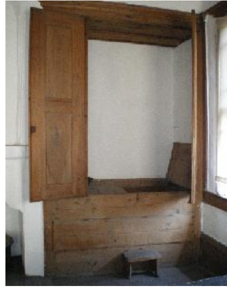
Resim-5.2.40 Mümtazlar Konağı Dolap ve Yüklük Görünümü. Dolap ve yüklüklerde oldukça basit bir işçiliğin kullanıldığı görülmektedir.Yüklük aynı zamanda gusülhane olarak kullanılmaktadır.Dolap yüzlerinde üç sıra oymalar yer almaktadır. (S.Gülçin Bozkurt,2009)
