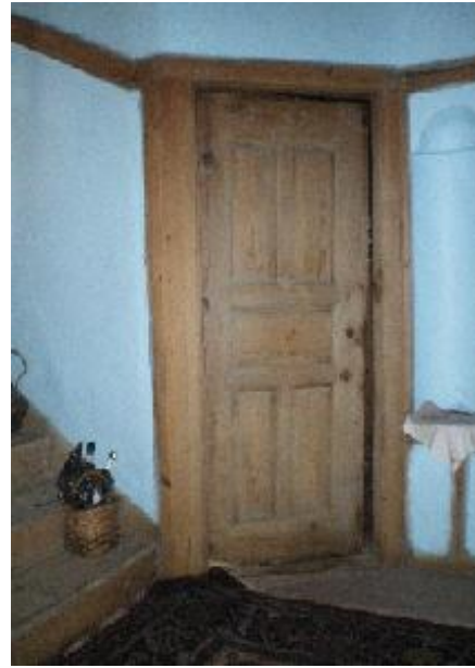
Resim-5.2.13 Asmazlar Konağı Kapı Görünümü. Üst kat odalarına girişler çift kanatlı kapılarla,alt kat odalarına girişler tek kanatlı kapılarla yapılmaktadır.Kapı kanatlarının görünümü dönemin özelliklerini yansıtmakta olup,basit bir işçiliğin kullanıldığı görülmektedir. (S.Gülçin Bozkurt,2009)
