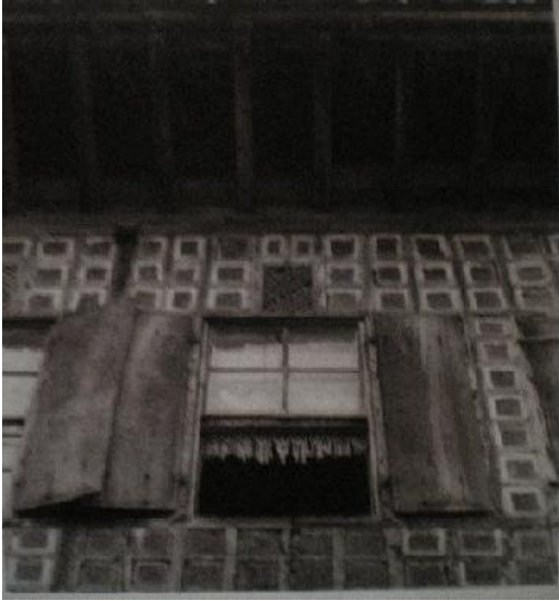
Resim-3.10. Türk Evinde Tepe Penceresinin En Küçük Formu ve Ahşap Kapaklı, Sürme Pencere Örneği, Araklı –Trabzon
