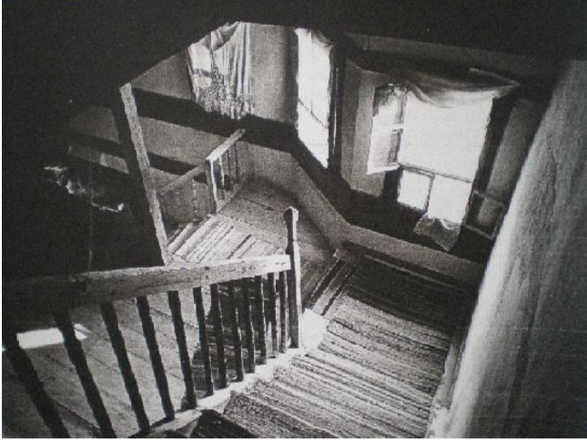
Resim-5.2.23 Kaymakamlar Konağını Merdiven Görünümü. Tek kollu olup evin çıkma köşeleri pahlandırılarak merdivene yönlendirilmiştir. (Reha Günay'dan,Türk Ev Geleneği ve Safranbolu Evleri ,sf.191)
