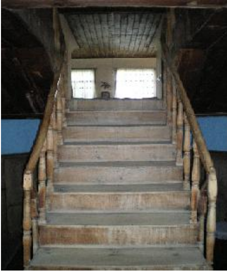
Resim-5.2.15 Asmazlar Konağı Merdiven Görünümü.Üç kollu merdiven sistemi görülmektedir. Orta kattan üst kata çıkış iki koldan yapılmakta ve üst kattan alt kata iniş tek koldan yapılmaktadır .(S.Gülçin Bozkurt,2009)
