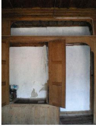
Resim-5.2.7 Sipahioğlu Konağı Dolapları.Dolaplarda sade bir işçilik göze çarpmaktadır.Ancak süslemenin ihmal edilmediği de görülmektedir. Dolap yüzlerinde üç sıra oyma bulunmaktadır.Dolap arası çiçeklikler kalem işi süslemelidir.Yüklük kısmına yatak,yorgan gibi eşyalar konulmakla birlikte gusülhane olarak da kullanılmaktadır.Dolaplara İse; giysiler ve günlük kullanılan eşyalar konulmaktadır. (S.Gülçin Bozkurt,2009)
