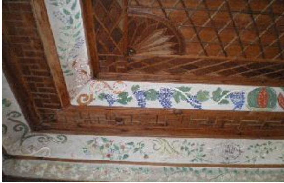
Resim-3.14.Özenli Bir Yapıda Kalem İşi Tekniğiyle Yapılmış Bir Tavan Örneği (S.Gülçin Bozkurt)
