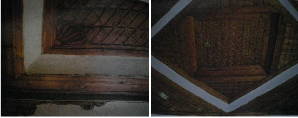
Resim-3.13.Özenli Bir Yapıda Karelerle ve Göbekte Gerçekleştirilen Tavan Kaplaması ve Oda Tavan İlişkisi, ( Ö.Küçükerman, Kendi Mekanının Arayışı İçinde Türk Evi,sf.164-166)
