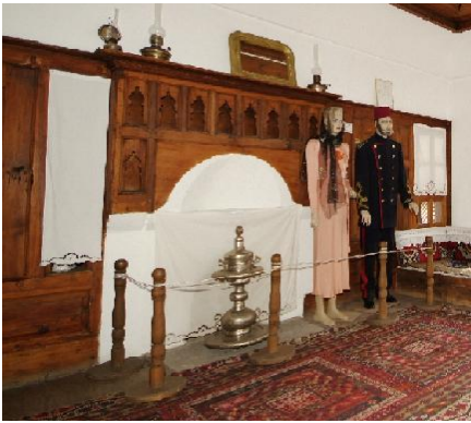
Resim-5.2.22 Kaymakamlar Konağı Ocak Görünümü.Baş odasının ocağı tek sıra oymalı ocaklardandır.Aşevi mutfağının ocağı ise;oldukça büyük olup,kireç sıvalı taş ocak şeklinde yapılmıştır . (S.Gülçin Bozkurt,2009)
