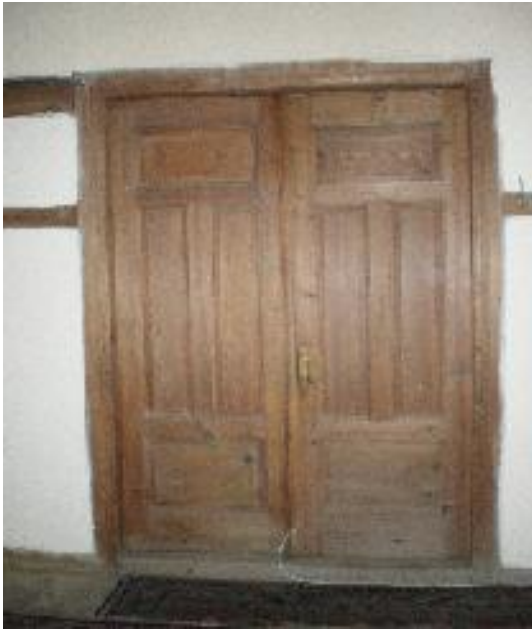
Resim-5.2.13 Asmazlar Konağı Kapı Görünümü. Üst kat odalarına girişler çift kanatlı kapılarla,alt kat odalarına girişler tek kanatlı kapılarla yapılmaktadır.Kapı kanatlarının görünümü dönemin özelliklerini yansıtmakta olup,basit bir işçiliğin kullanıldığı görülmektedir. (S.Gülçin Bozkurt,2009)
