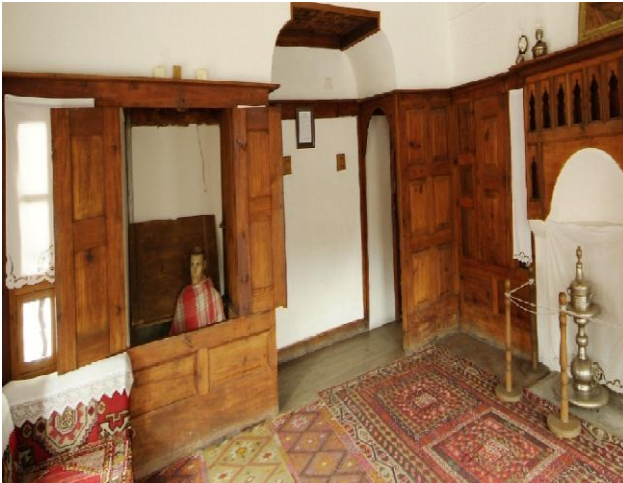
Resim-5.2.19 Kaymakamlar Konağı Baş Odası. Üst kat oda girişleri pahlı köşelerden yapılmaktadır. Oda döşemesi ahşap olup, seki altı ve seki üstü kot farklılığının olmadığı görülmektedir. (S.Gülçin Bozkurt, 2009)
