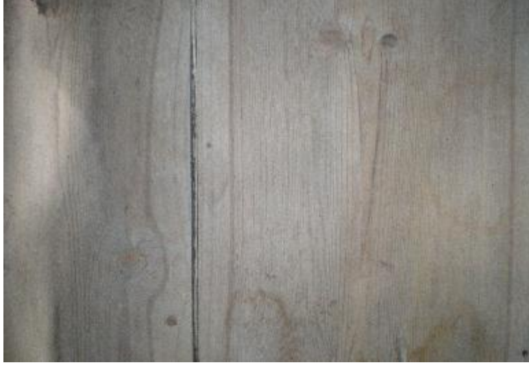
Resim-4.27.Asmazlar Konağından Ahşap Yer Döşemesi Örneği. (S.Gülçin Bozkurt ,2009)
