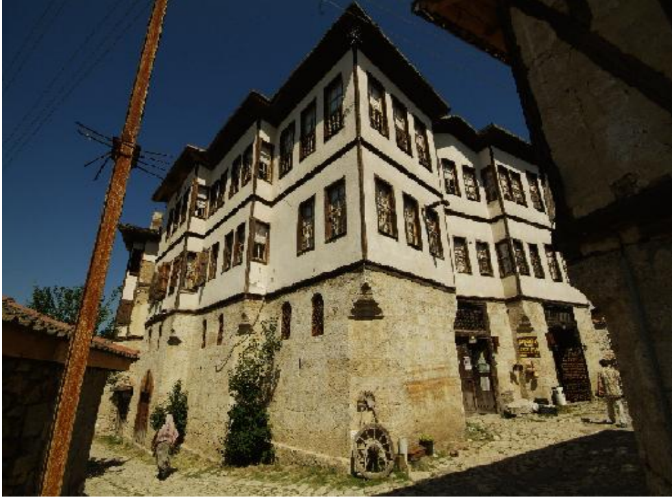
Resim-5.2.1 Sipahioğlu Konağı Ön Cephe Görünümü.(S.Gülçin Bozkurt,2009)
