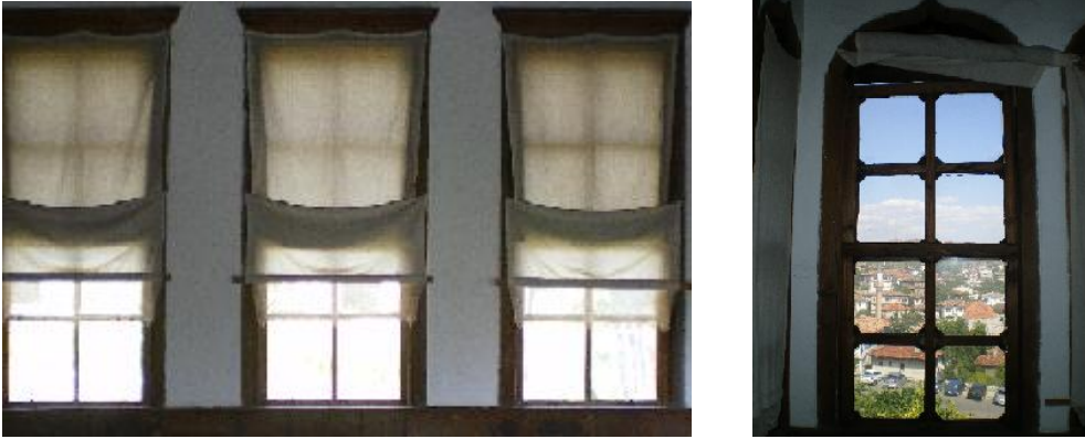
Resim-5.2.36 Mümtazlar Konağı Pencere Görünümü. Oda pencereleri sürgülü pencerelerden olup, oldukça büyüktür.Sofa pencereleri ise dönemin özelliklerini yansıtmakta olup,yarım daire silme kemerler görülmektedir. (S.Gülçin Bozkurt,2009)
