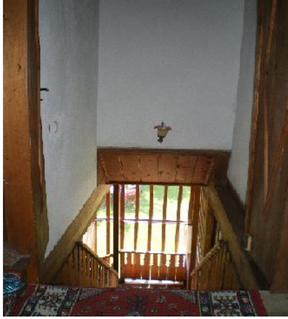
Resim-4.34.Asmazlar Baę Evinden Tek Kollu Merdiven Örneęi, Safranbolu (S.Gülçin Bozkurt,2009)
