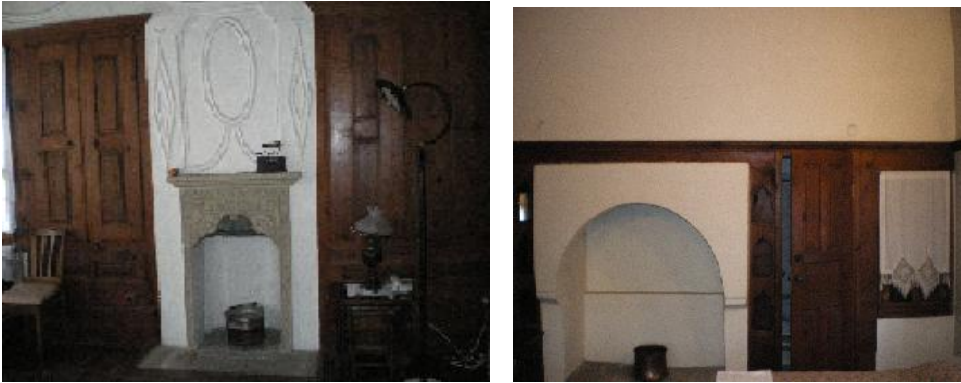
Resim-5.2.30 Gökçüoğlu Konağı Ocak Görünümü.Baş odasında bulunan ocak dönemin özelliklerini yansıtmakta olup,çiçekli taş ocaklardandır.Aşevi ocağı ise daha büyük olup,kireç sıvalı ve taş ocak şeklinde yapılmıştır. (S.Gülçin Bozkurt,2009)
