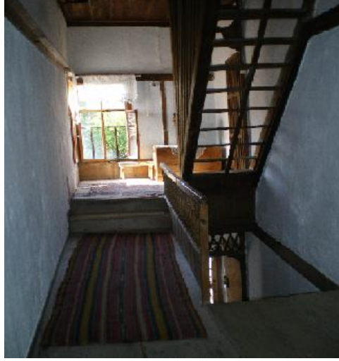
Resim-5.2.6 Sipahioğlu Konağı Merdivenleri. Tek kollu olup,korkuluk olarak ahşap çıtalar çapraz bir şekilde çakılmıştır.Merdiven girişlerinde süslü kemerler görülmektedir. (S.Gülçin Bozkurt,2009)
