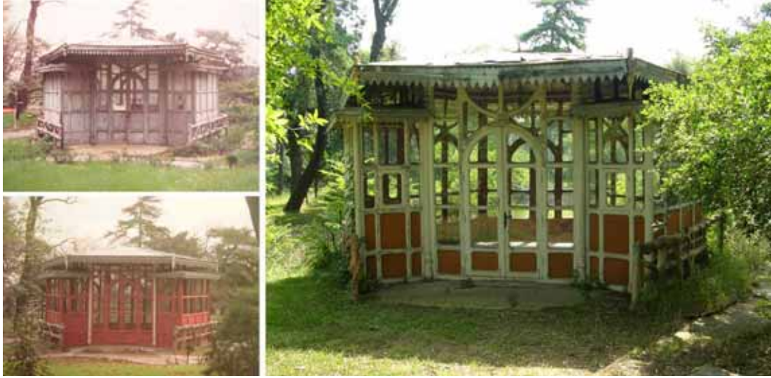
Şekil 4.85 Kebap Köşkü: Solda Yıldız Sarayı Vakfı tarafından yapılan onarımdan (1984) önceki ve sonraki görünüşü (Yıldız Sarayı Vakfı, 1985 ; Kaşif, 2010).
