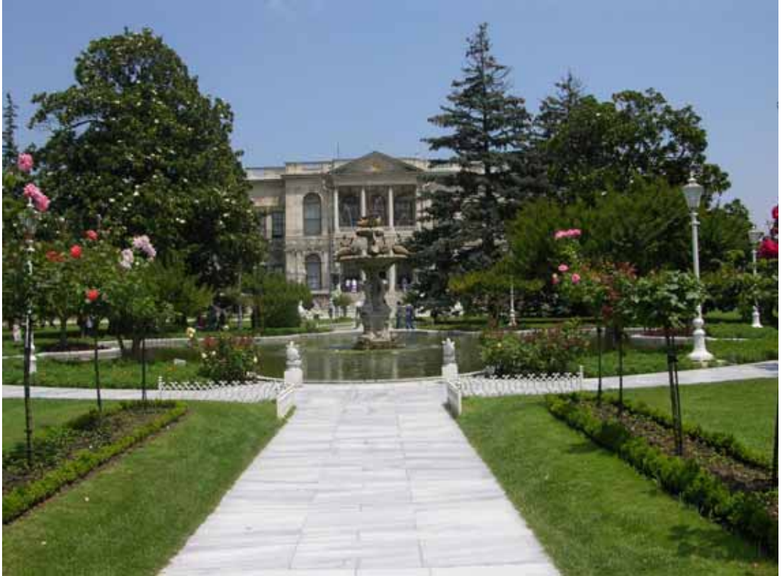
Şekil 4.23 Koltuk Kapısından Mabeyn Binasının görünüşü (Kaşif, 2010).
