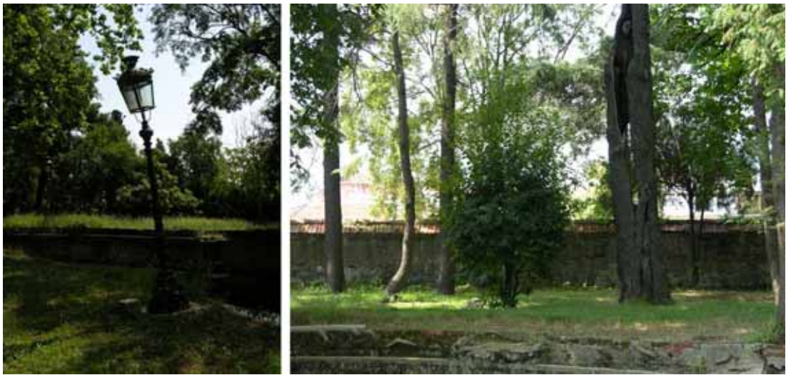
Şekil 4.89 Hasbahçede bakımsız durumda olan aydınlatma elemanı – İçi boşalmış ve neredeyse devrilmek üzere olan ağaç gövdesi (Kaşif, 2010).
