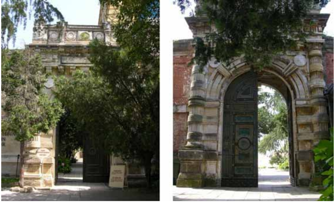
Şekil 4.61 Harem İç Kapısı: Dış - iç cephe görünüşü (Kaşif, 2010).
