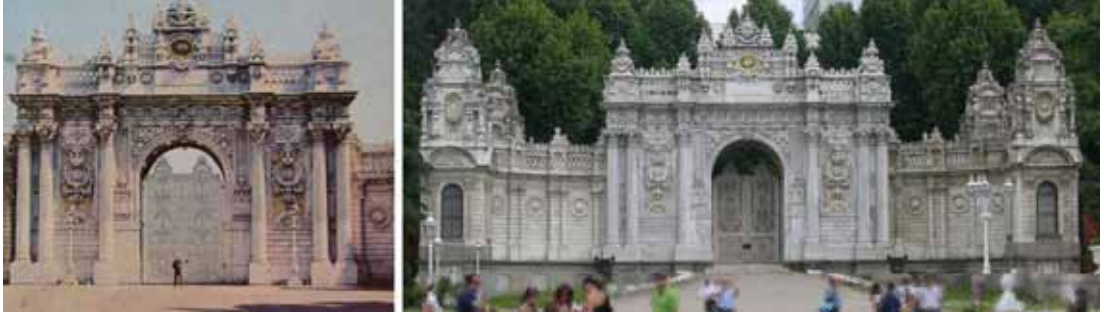
Şekil 4.12 Saltanat Kapısı: Dış – İç cephe görünüşü (Keskin, 1988 ; Kaşif, 2010).
