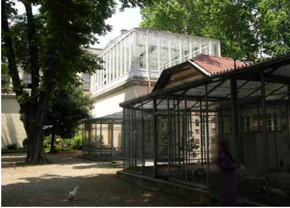
Şekil 4.19 Camlı Köşk ve Kuşluk görünüşü (Kaşif, 2010).
