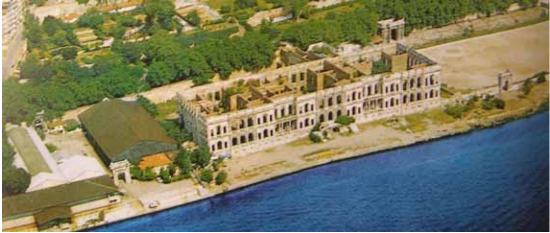
Şekil 3.33 Çırağan Sarayı: 1910 yangını sonrası dört duvarı kalan sarayın 1980'li yıllardaki görünüşü (Gülersoy, 1983, s.2).
