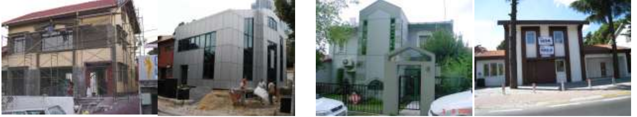
Şekil 5.47. Yapısal değişime uğrayan Levent evleri
