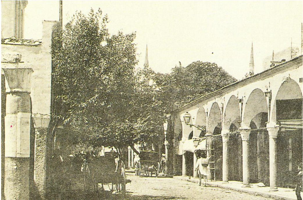
Şekil 3.12: Revaklar Yıkılmadan Önce Direklerarası (M.K.A.)
