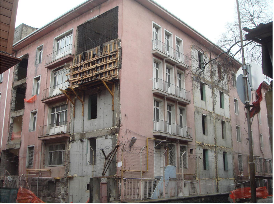
Şekil 5.20: Vezneciler Yurdu Güçlendirme Çalışması, 2011
