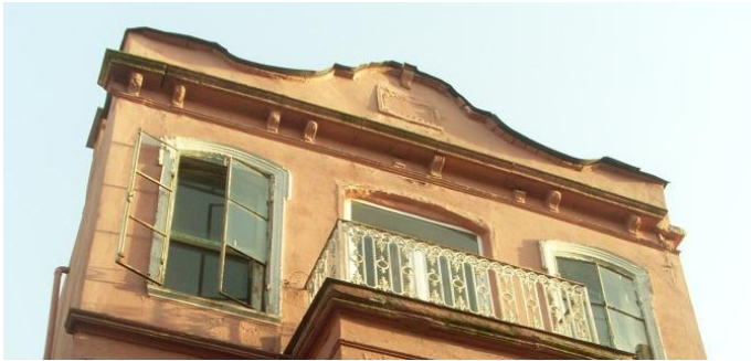
Şekil 131: 2385 ada 151 parseldeki yapıda kâgir furuş örneği.
