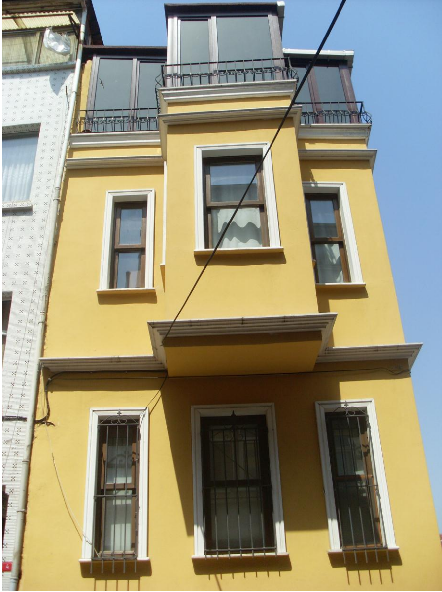
Şekil 71: Ek kata örnek olarak Pulcu Sokak, 1278 Ada/5 Parseldeki yapı verilebilir (Gündoğan,2010).
