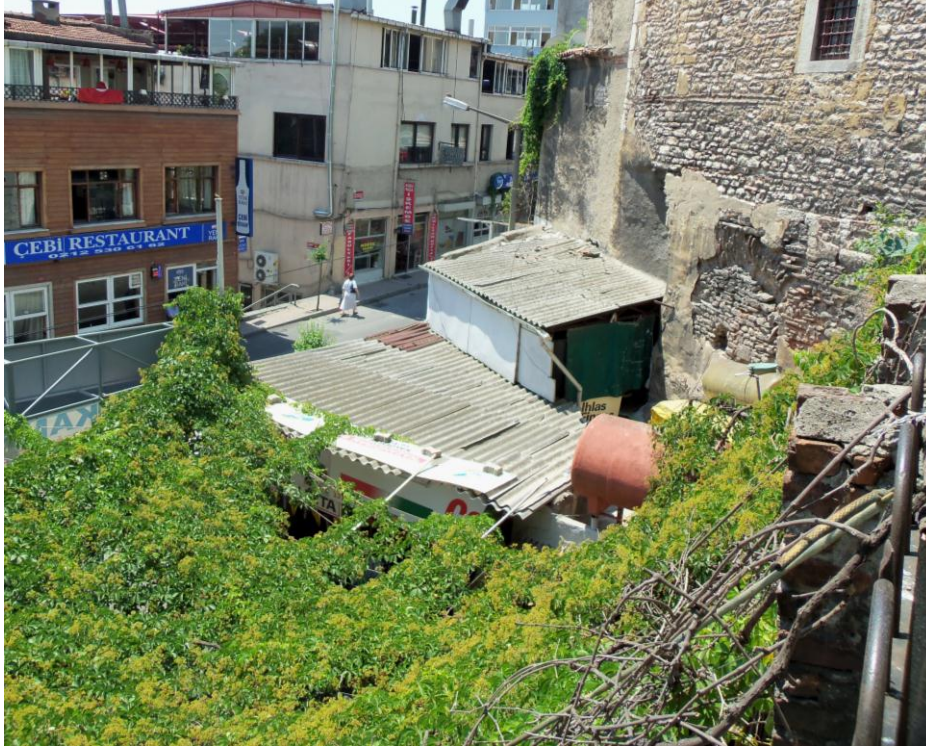
Şekil 36: Hagios Menas Kilisesi'nden yola bakış ve altındaki dükkânların üst kottan görünüşü (Gündoğan,2011).
