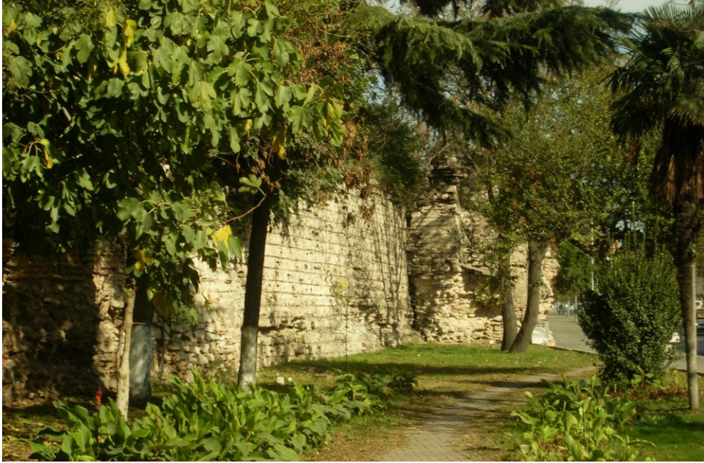
Şekil 81: İstasyonun alt kısmında yer alan sur parçası (Gündoğan,2010).
