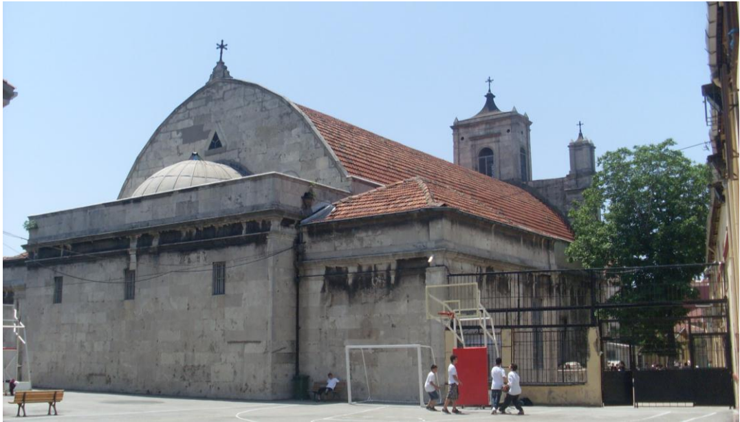
Şekil 40: Surp Kevork Ermeni Kilisesi'nin Sahakyan Nunyan Lisesi'nin bahçesinden görünümü (Gündoęan,2010).
