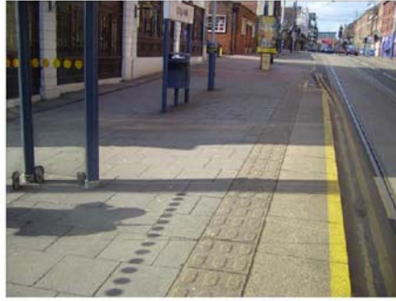
Fotoğraf 3: Tramvay durağında eliptik yüzey uygulaması örneği
