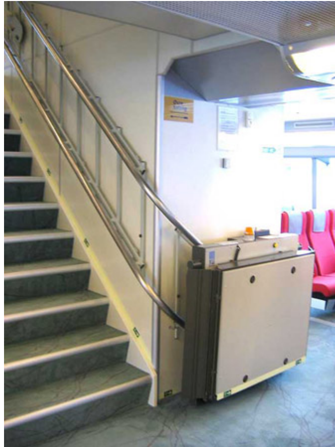
Şekil 3.41 : Deniz aracı içerisinde merdiven asansörü kullanım örneği (URL-16)
