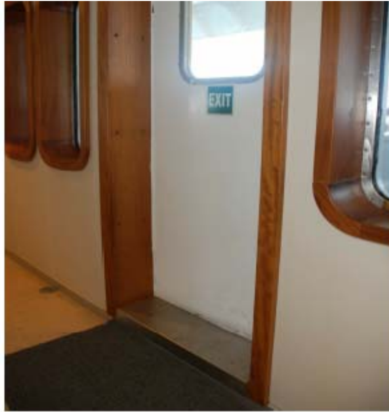
Şekil 3.54 : ŞH Beykoz vapuru açık yolcu mahaline çıkış engeli (Bkz: EK-3)
