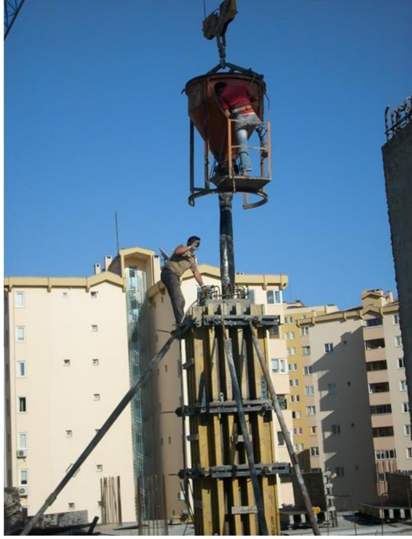
Şekil 4.38 Anket yapılan şantiyelerden bir fotoğraf
