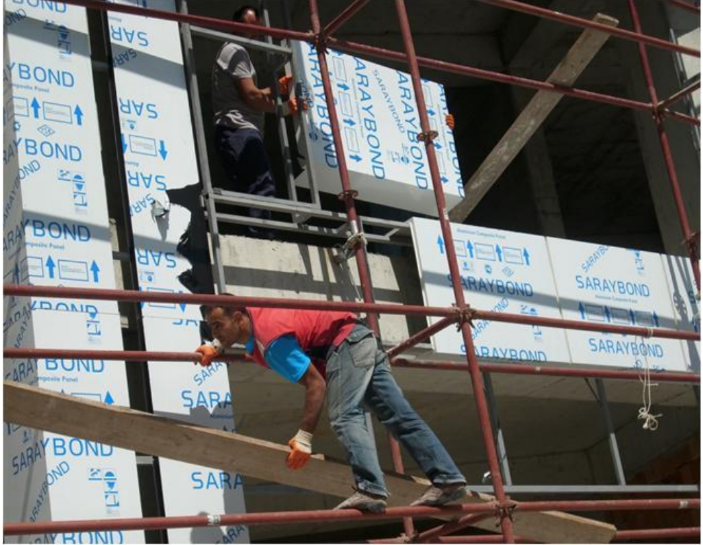
Şekil 4.28 Anket yapılan şantiyelerden bir fotoğraf
