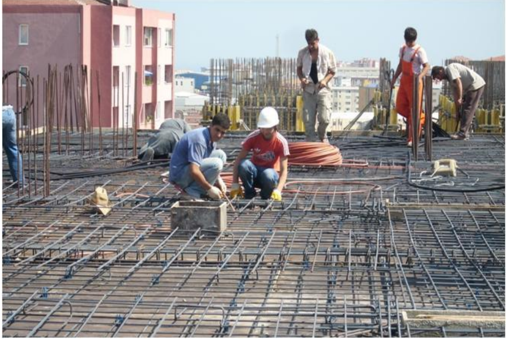
Şekil 4.22 Anket yapılan şantiyelerden bir fotoğraf
