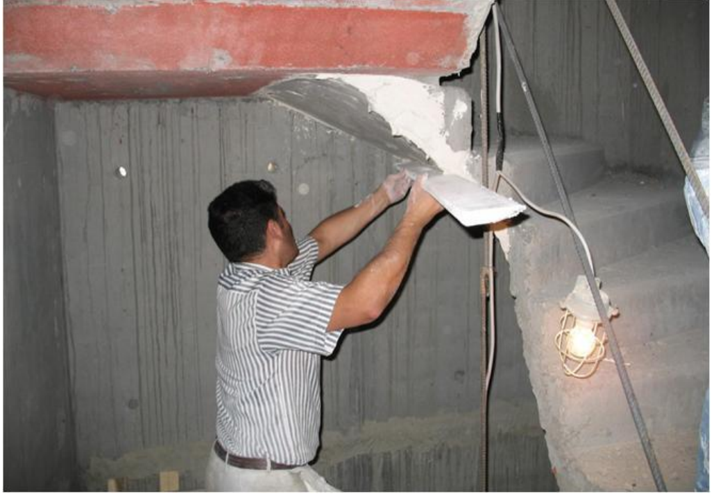
Şekil 4.35 Anket yapılan şantiyelerden bir fotoğraf
