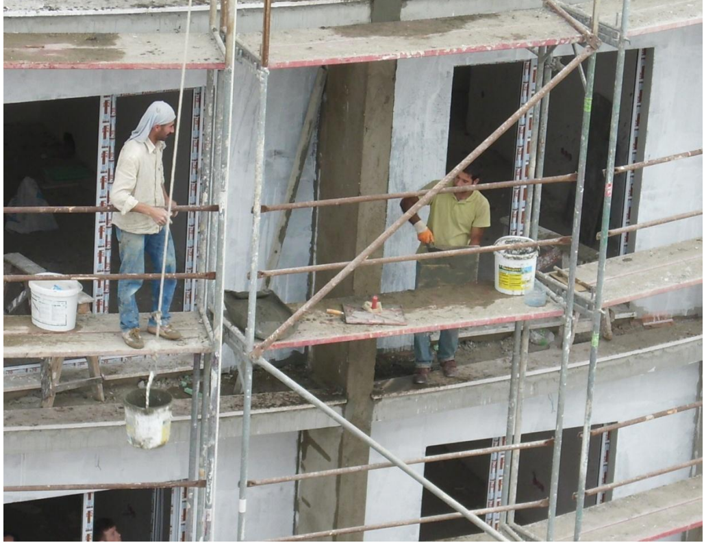
Şekil 4.29 Anket yapılan şantiyelerden bir fotoğraf
