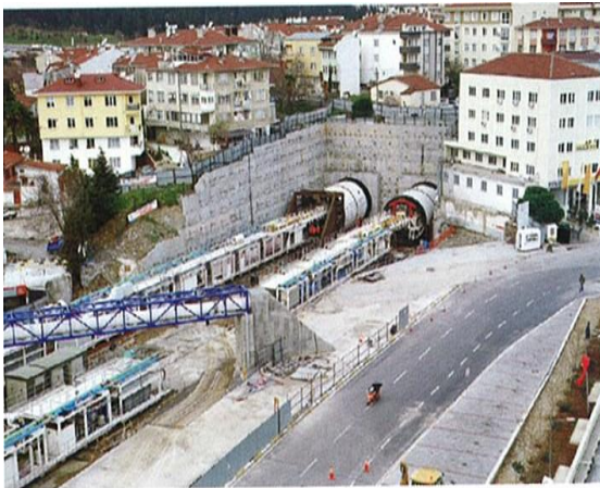
Kadıköy Avrılıkçeşme tünel portalı
