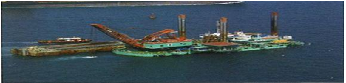
Şekil 6.1 Boğazda Yapılan Kazı Çalışması
