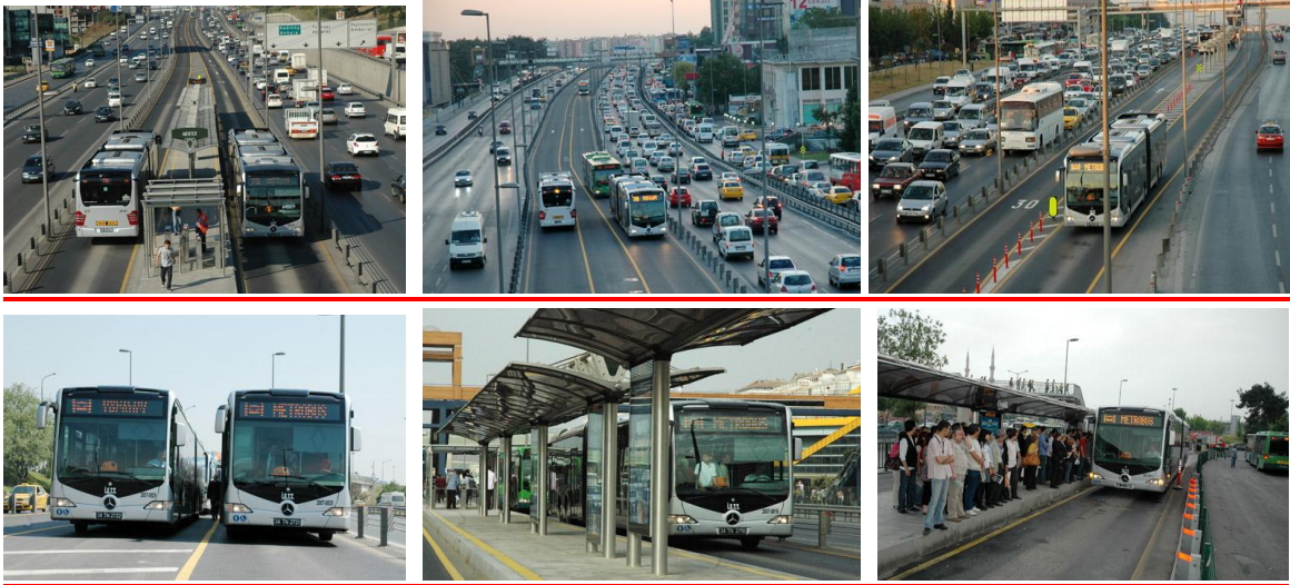
Şekil 6.12 “Avcılar – Kadıköy Söğütlüçeşme Metrobus Hattı” (Cors-Tr Sistemi’nin İşletmeye Alınması Sonrasında Tüm Projedeki Koordinat Aplikasyonları, Arazi Alımları ile Değerlendirmelerinin Tamamı Cors-Tr ile Yapılarak İnşaat Tamamlanmıştır.)
