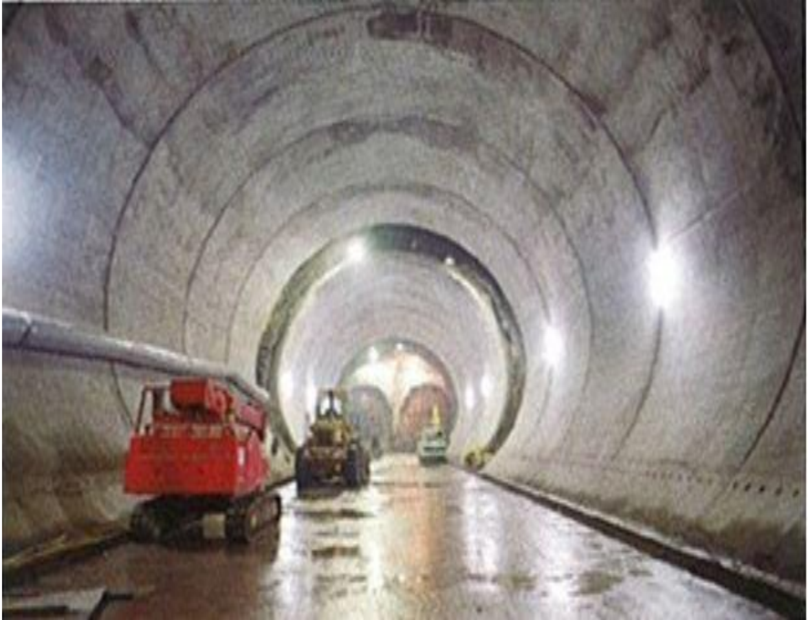
Şekil 4.24 NATM ile İnşaa Edilen Üsküdar Makas Tüneli
