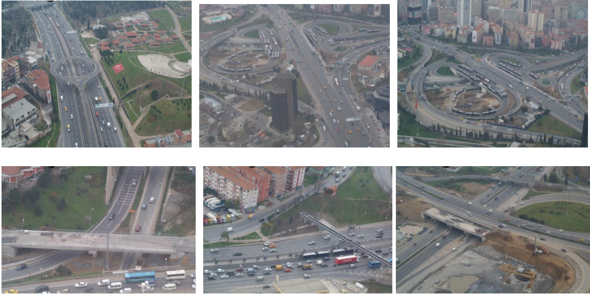
Şekil 6.11 “Avcılar - Söğütlüçeşme Metrobus Hattı İnşaat Anı Resimleri” (Cors-Tr Sistemi’nin İşletmeye Alınması Sonrasında Tüm Projedeki Koordinat Aplikasyonları, Arazi Alımları ile Değerlendirmelerinin Tamamı Cors-Tr ile Yapılarak İnşaat Tamamlanmıştır.)
