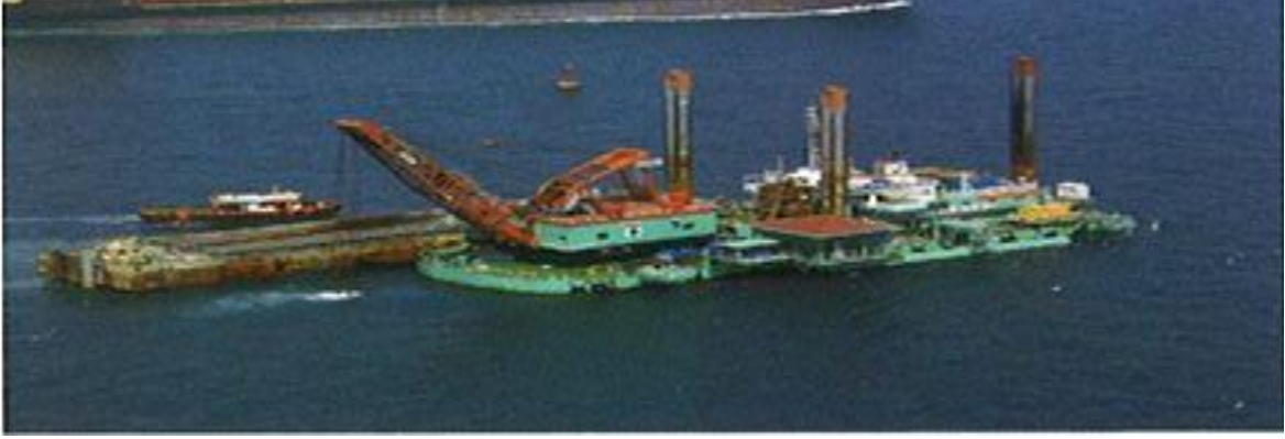
Şekil 4.17 Boğazda Yapılan Kazı Çalışması
