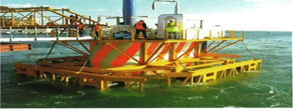
Şekil 4.18 Batırma Tüp Tünele Düşey Erişimi Sağlayan Şaft
