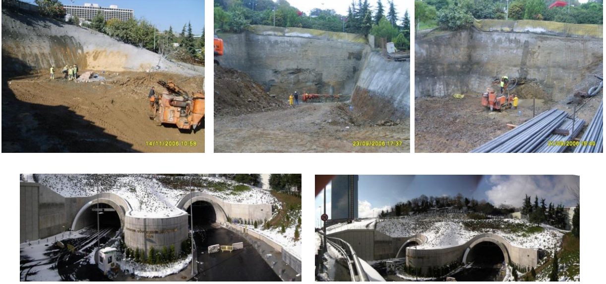
Şekil 6.8 “ Bomonti - Dolmabahçe Gidiş – Geliş Karayolu Tüneli İnşaatı ” Tünel Dolmabahçe Çıkış Aynası ve Dolmabahçe Kavşağı İnşaatı (Cors-Tr Sistemi'nin İşletmeye Alınması Sonrasında Tünel Dışındaki Tüm Proje Koordinat Aplikasyonları, Arazi Alımları ile Değerlendirmelerinin Tamamı Cors-Tr ile Yapılarak İnşaat Tamamlanmıştır.)
