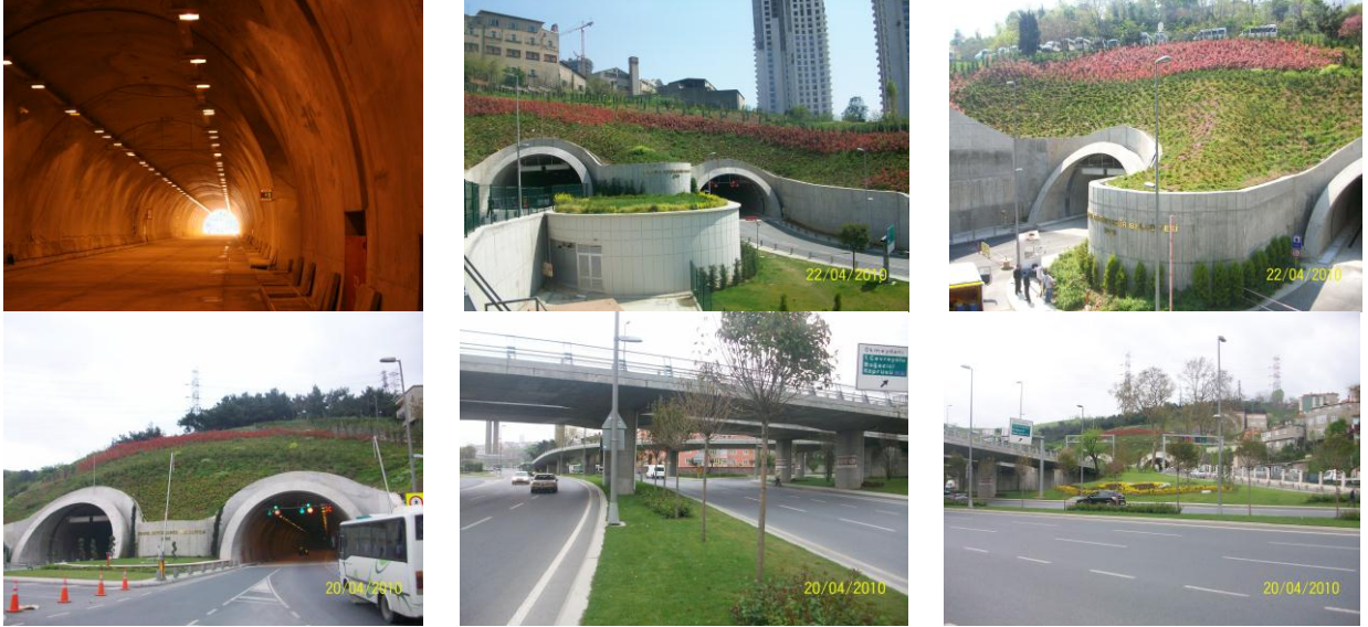
Şekil 6.9 “ Kağıthane-Piyalepaşa & Bomonti-Dolmabahçe Gidiş-Geliş Karayolu Tünelleri İnş. ” Karayolu Tünelleri ve Çıkış Ağzlarındaki Kavşakların İş Sonu Resimleri 2010 (Cors-Tr Sistemi'nin İşletmeye Alınması Sonrasında Tünel Dışındaki Tüm Proje Koordinat Aplikasyonları, Arazi Alımları ile Değerlendirmelerinin Tamamı Cors-Tr ile Yapılarak İnşaat Tamamlanmıştır.)
