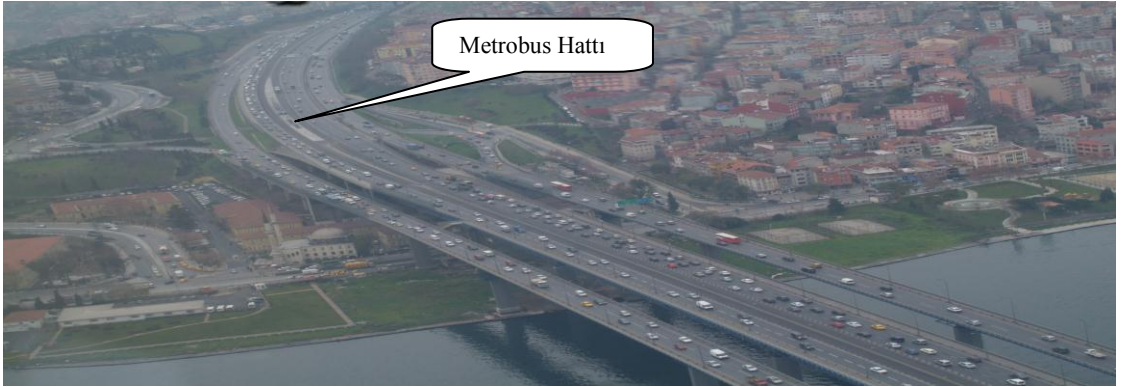
Şekil 6.14 Avcılar-Topkapı Metrobus Hattı Haliç Köprüsü Geçışı
