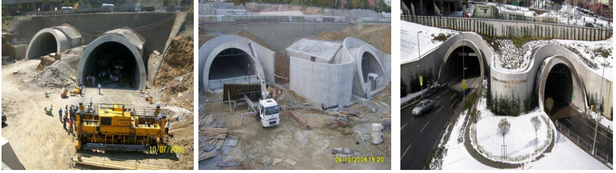
Şekil 6.6 “ Kağıthane – Piyalepaşa Gidiş-Geliş Karayolu Tüneli İnşaatı ” Tünel Piyalepaşa Çıkış Aynası ve Piyalepaşa Kavşağı İnşaatı (Cors-Tr Sistemi'nin İşletmeye Alınması Sonrasında Tünel Dışındaki Tüm Proje Koordinat Aplikasyonları, Arazi Alımları ile Değerlendirmelerinin Tamamı Cors-Tr ile Yapılarak İnşaat Tamamlanmıştır.)
